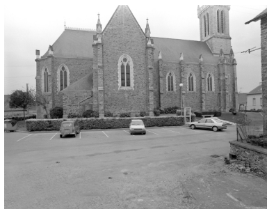
Elévation nord : vue générale Phot. Guy Artur, Phot. Norbert Lambart IVR53_19933500441X
