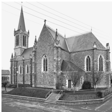
Elévation sud-est : vue générale Phot. Guy Artur, Phot. Norbert Lambart IVR53_19933500443X
