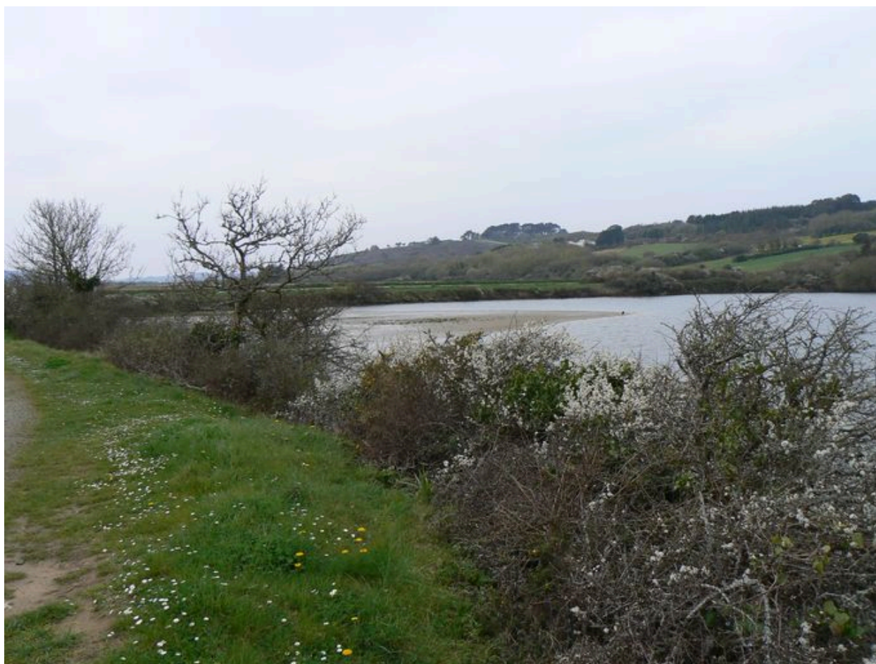
Digue-route de l'Aber côté étang
