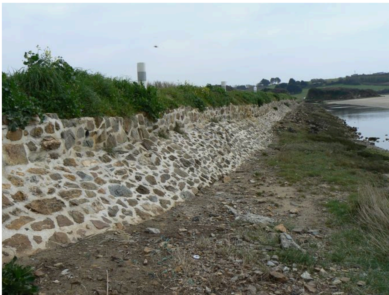
Digue-route de l'Aber côté estran
