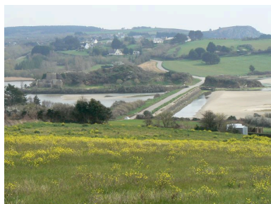
Vue générale de la digue-route de l'Aber Phot. Julien Amghar IVR53_20072908773NUCA
