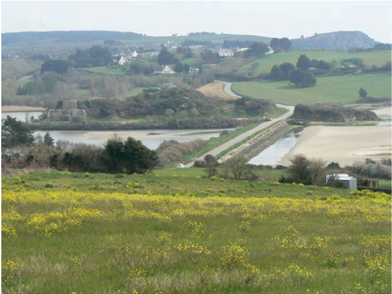
Vue générale de la digue-route de l'Aber
