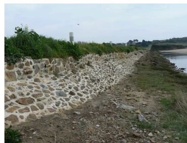
Digue-route de l'Aber côté estran Phot. Julien Amghar IVR53_20072908774NUCA
