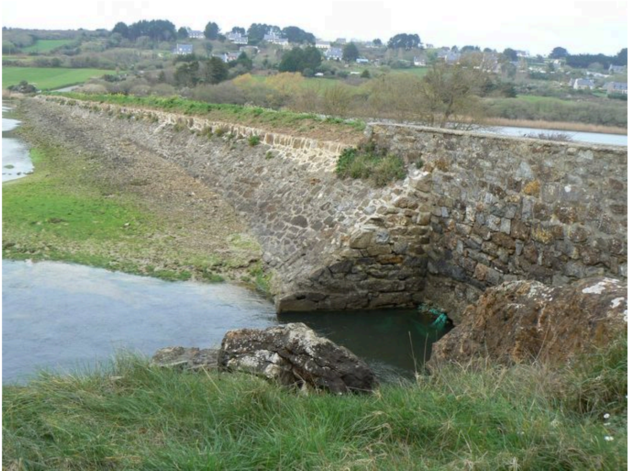
Digue-route de l'Aber côté estran
