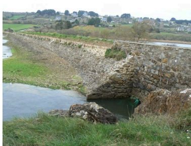
Digue-route de l'Aber côté estran Phot. Julien Amghar IVR53_20072908775NUCA
