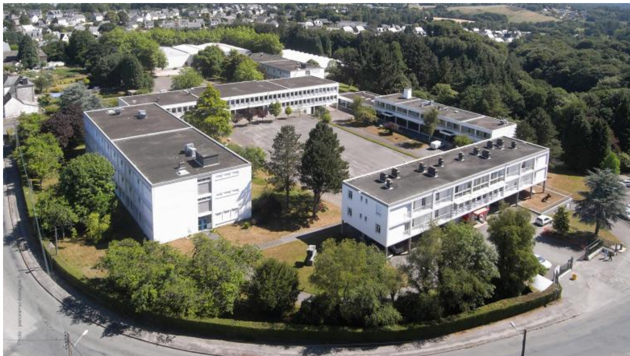
Vue aérienne oblique prise du sud-ouest vers le nord-est. Au premier plan, à droite, l'entrée principale.
