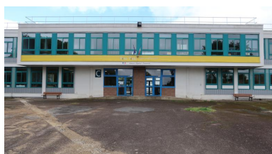
Bâtiment C, façade nord, détail de la partie centrale : le CDI en encorbellement. Phot. Thierry Goyet IVR53_20192205720NUCA
