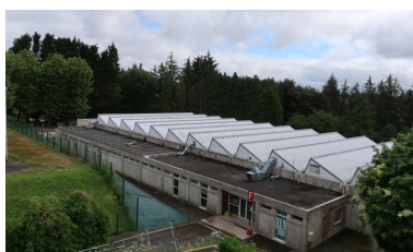
Bâtiment F (ateliers), façade ouest et toiture à sheds (vue prise du bâtiment C). Phot. Thierry Goyet IVR53_20192205723NUCA
