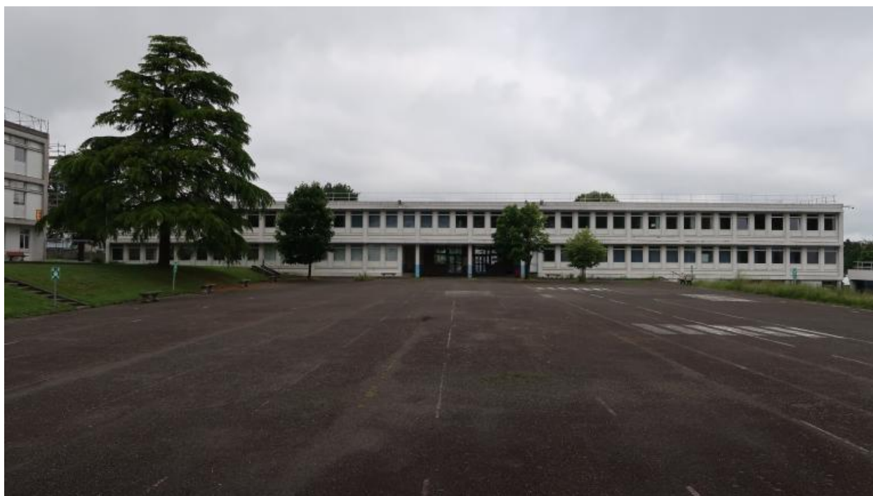
Façade sud du bâtiment C (externat). Au premier plan, la vaste cour.
