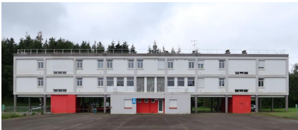
Bâtiment A (administration, logements...), façade nord, Jean De Jaegher, architecte, 1967.
