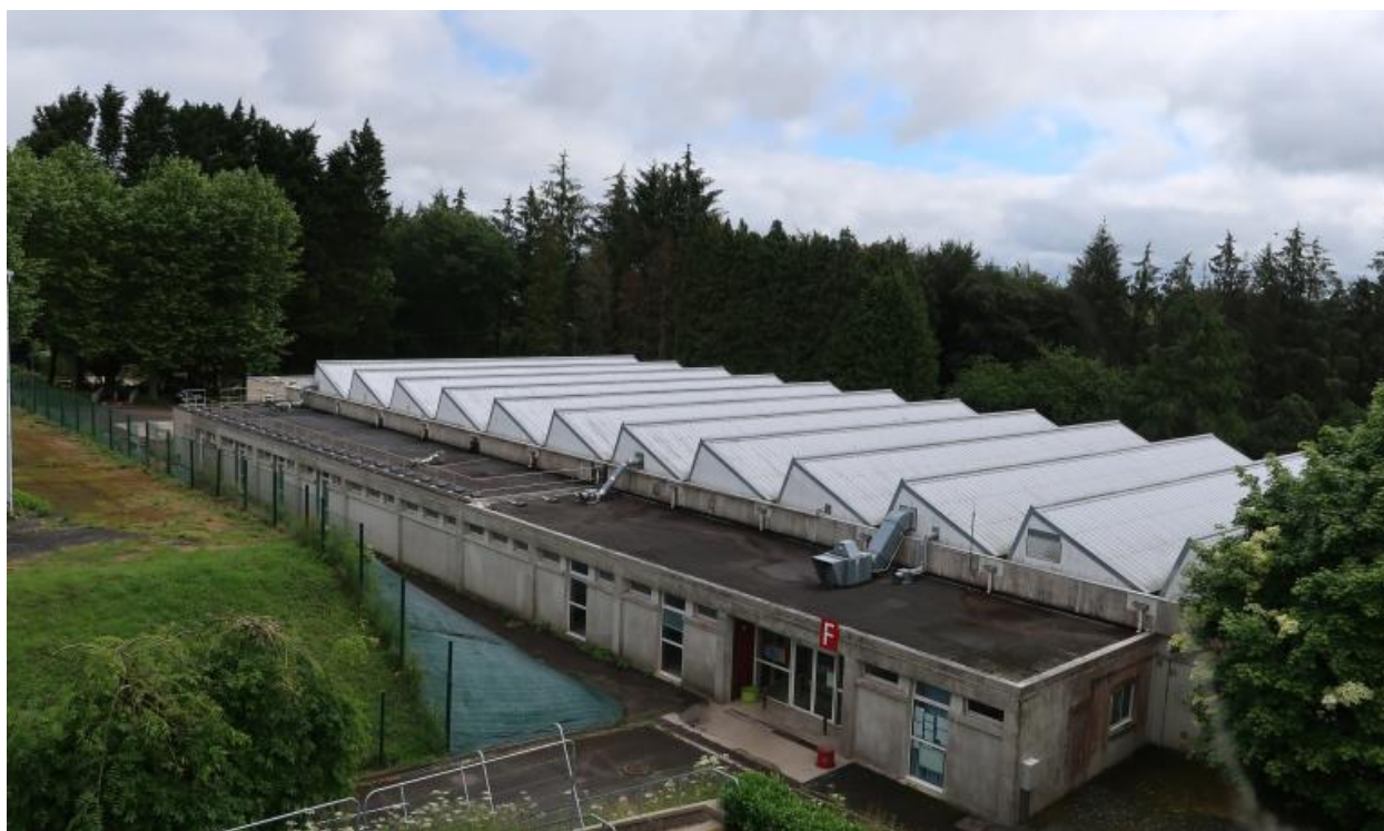
Bâtiment F (ateliers), façade ouest et toiture à sheds (vue prise du bâtiment C).
