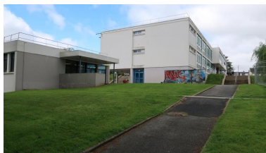
Façade nord du bâtiment B (restauration, entrée) et façade est du bâtiment C. Phot. Thierry Goyet IVR53_20192205727NUCA
