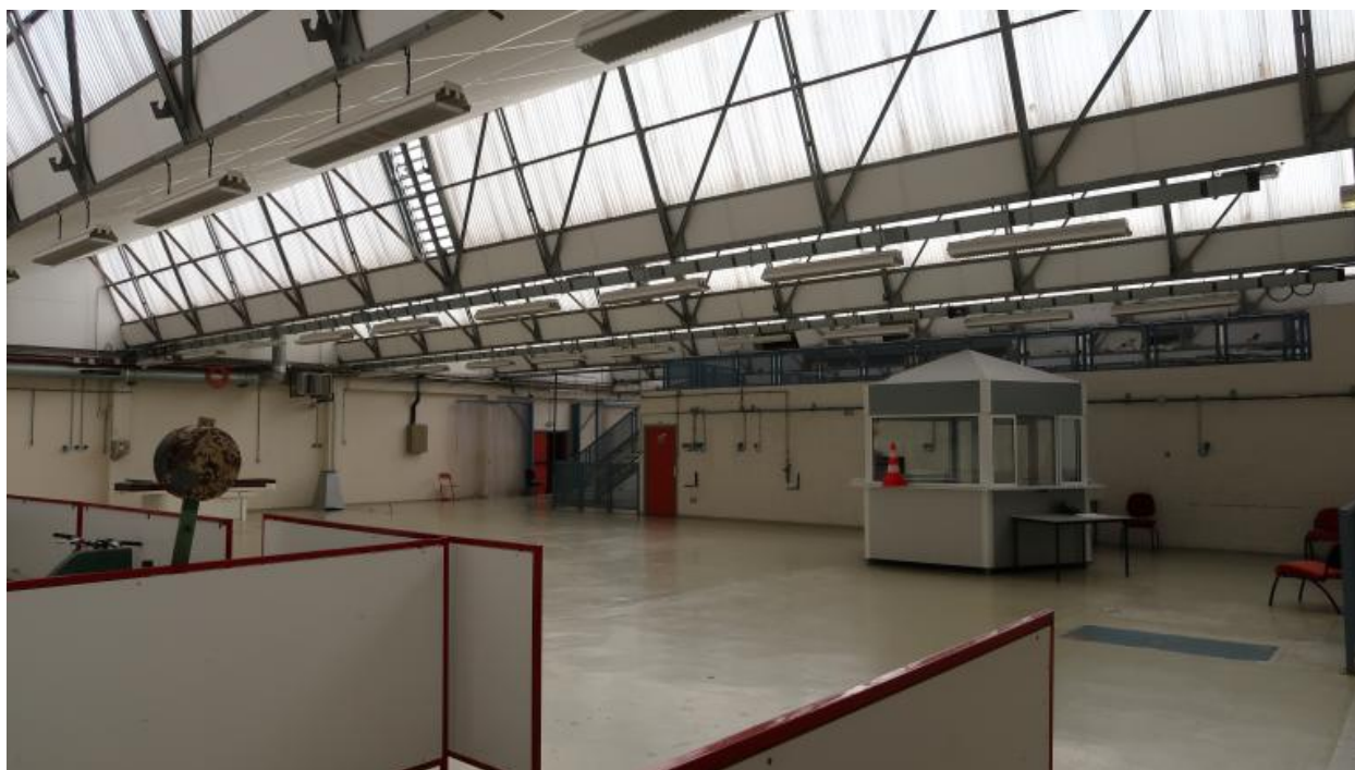
Ateliers, vue intérieure. Initialement prévus pour les formations liées à l'industrie automobile, les vastes espaces servent désormais aux formations aux métiers de la sécurité.
