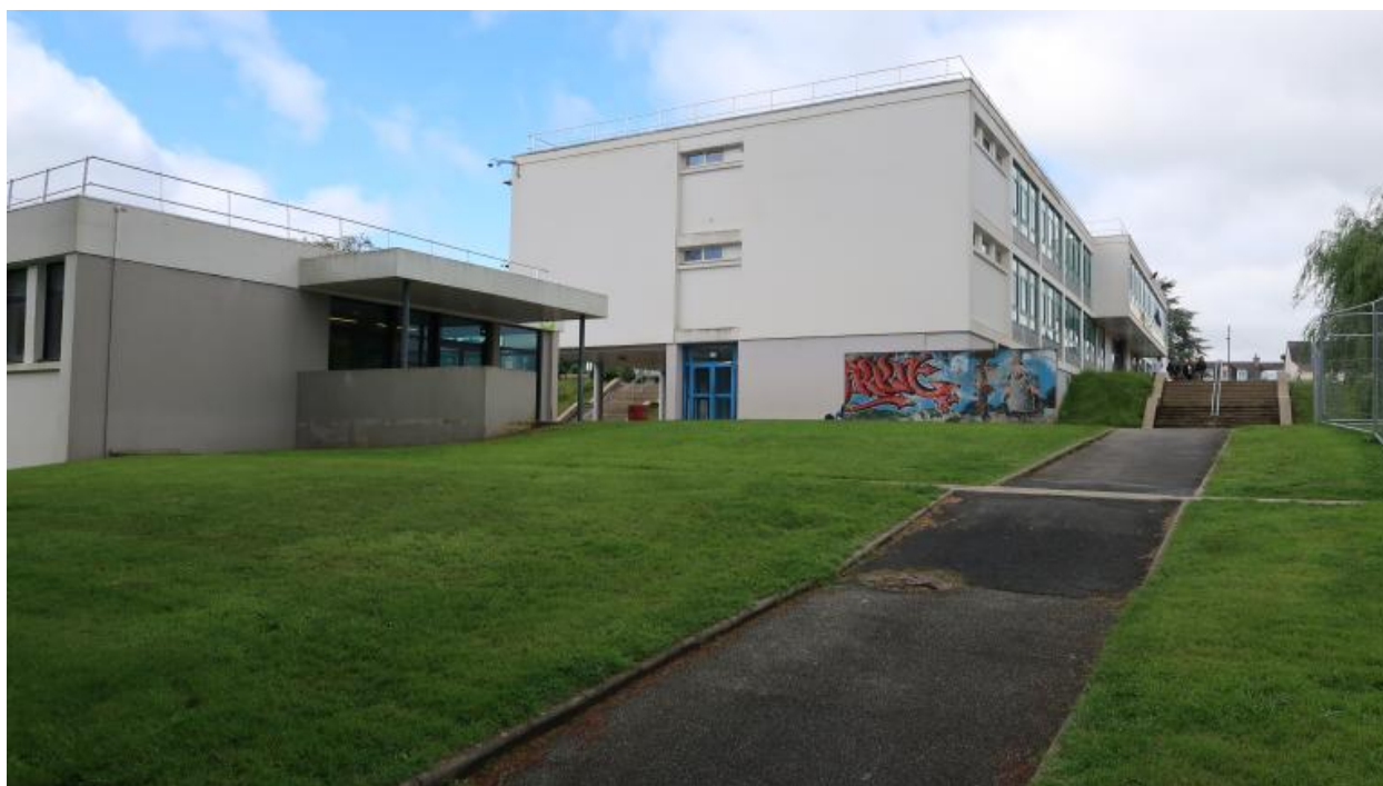
Façade nord du bâtiment B (restauration, entrée) et façade est du bâtiment C.
