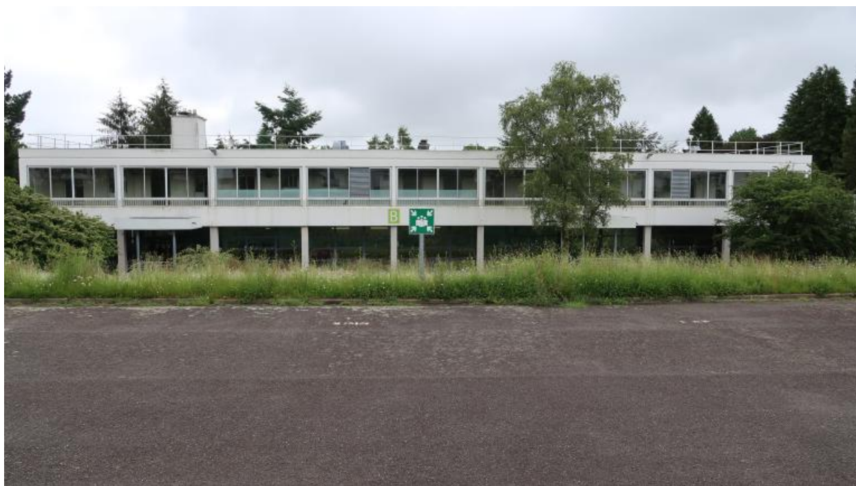
Façade ouest du bâtiment B (restauration, CDI...).
