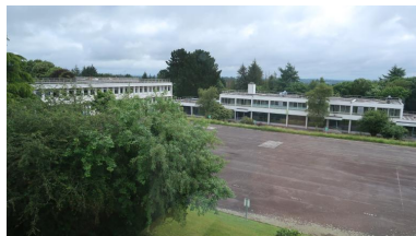
Vue d'ensemble, bâtiments C (externat), B (restauration) et cour, prise du bâtiment E (internat de garçons). Phot. Thierry Goyet IVR53_20192205716NUCA
