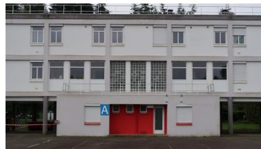
Bâtiment A (administration, logements...), façade nord : vue de détail sur la partie centrale (noter les trois trames de pavés de verre qui éclairent l'escalier). Phot. Thierry Goyet IVR53_20192205713NUCA
