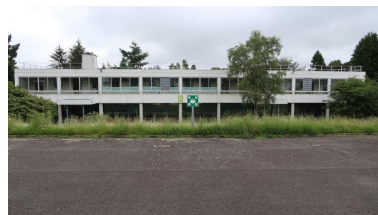
Façade ouest du bâtiment B (restauration, CDI...). Phot. Thierry Goyet IVR53_20192205714NUCA
