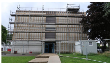
Pignon nord du bâtiment E (internat des garçons et salles de classe), en cours de réhabilitation thermique (19/06/2018). Phot. Thierry Goyet IVR53_20192205717NUCA
