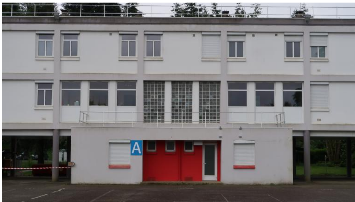
Bâtiment A (administration, logements...), façade nord : vue de détail sur la partie centrale (noter les trois trames de pavés de verre qui éclairent l'escalier.
