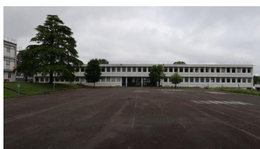
Façade sud du bâtiment C (externat). Au premier plan, la vaste cour. Phot. Thierry Goyet IVR53_20192205711NUCA
