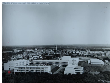
Vue aérienne oblique prise du sud. Vers 1970. IVR53_2022205004NUC
