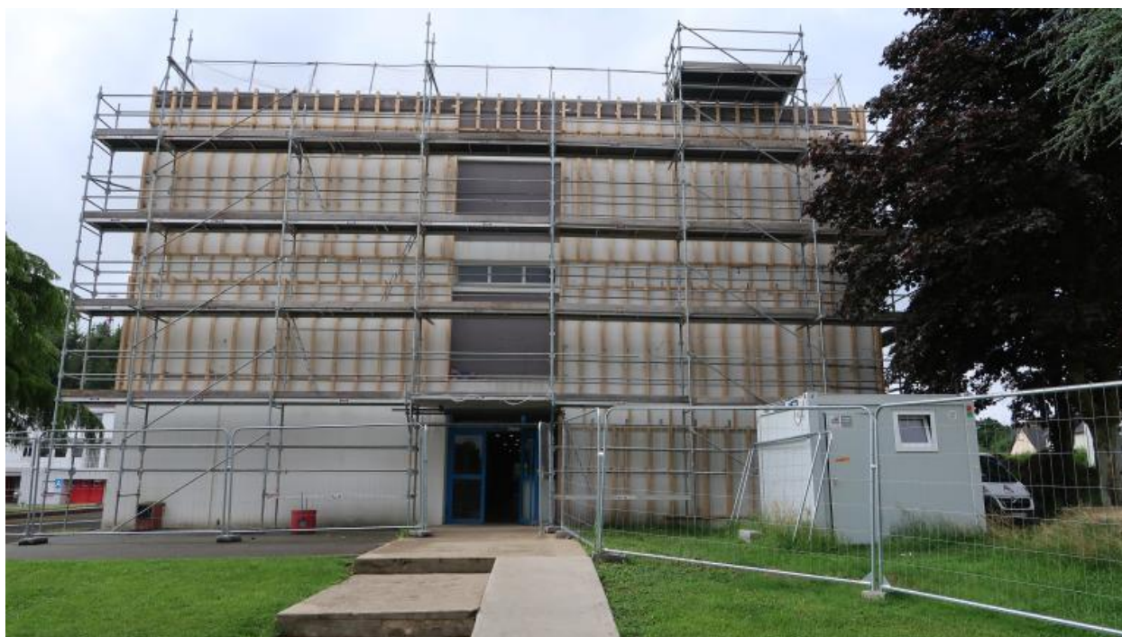
Pignon nord du bâtiment E (internat des garçons et salles de classe), en cours de réhabilitation thermique (19/06/2018).
