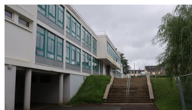
Façade nord du bâtiment C (externat), vue prise de l'est. L'architecte utilise la déclivité pour créer un préau traversant, donnant accès au réfectoire et à la cour.. Phot. Thierry Goyet IVR53_20192205722NUCA
