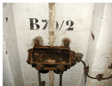
Vue du boîtier de connexion téléphonique - en position ouvert - surmonté du marquage B 70/2 Phot. Guillaume Lécueillier IVR53_20062904859NUCA
