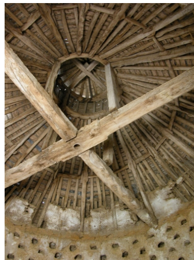
Pigeonnier ; détail, charpente Phot. Claude Quillivic IVR53_20043503641NUCA
