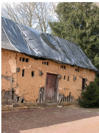
Remise à pan de bois Phot. Claude Quillivic IVR53_20043503643NUCA
