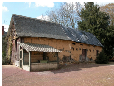
Remise à pan de bois Phot. Claude Quillivic IVR53_20043503642NUCA
