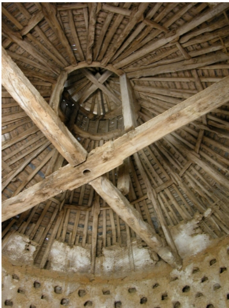
Pigeonnier ; détail, charpente
