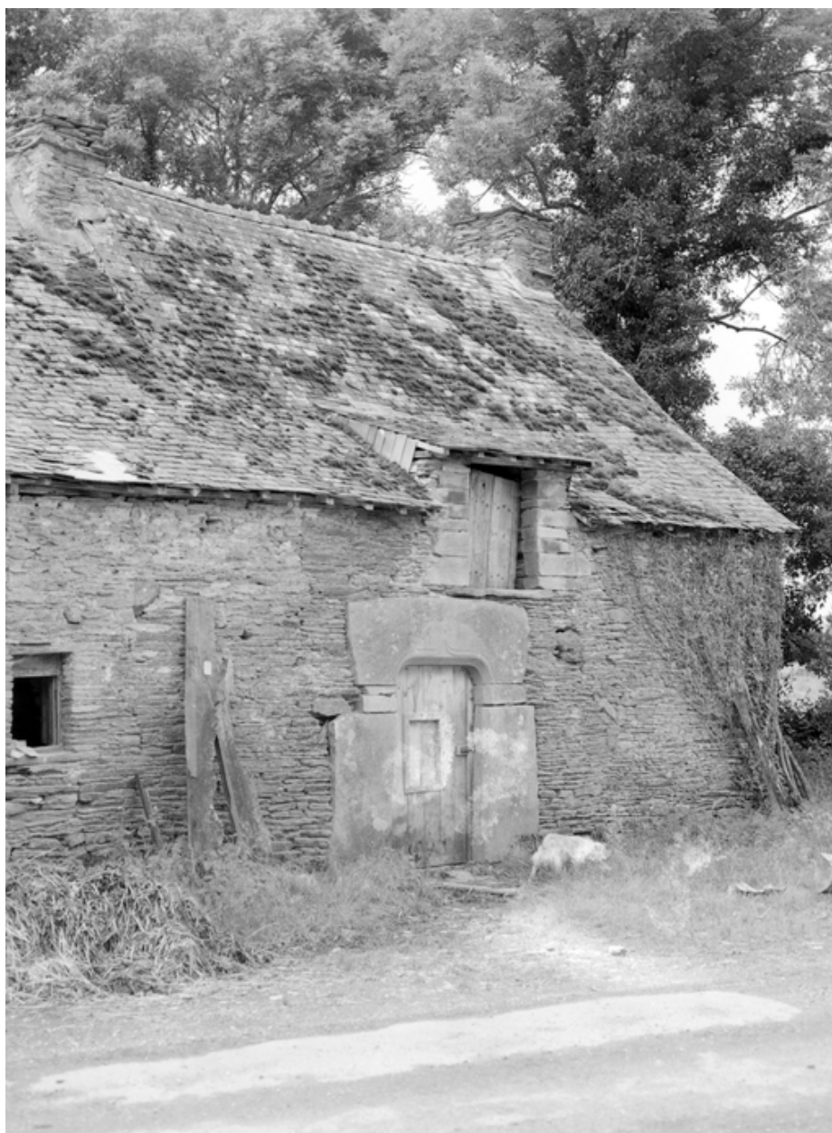
Maison : élévation nord (état en 1983)
