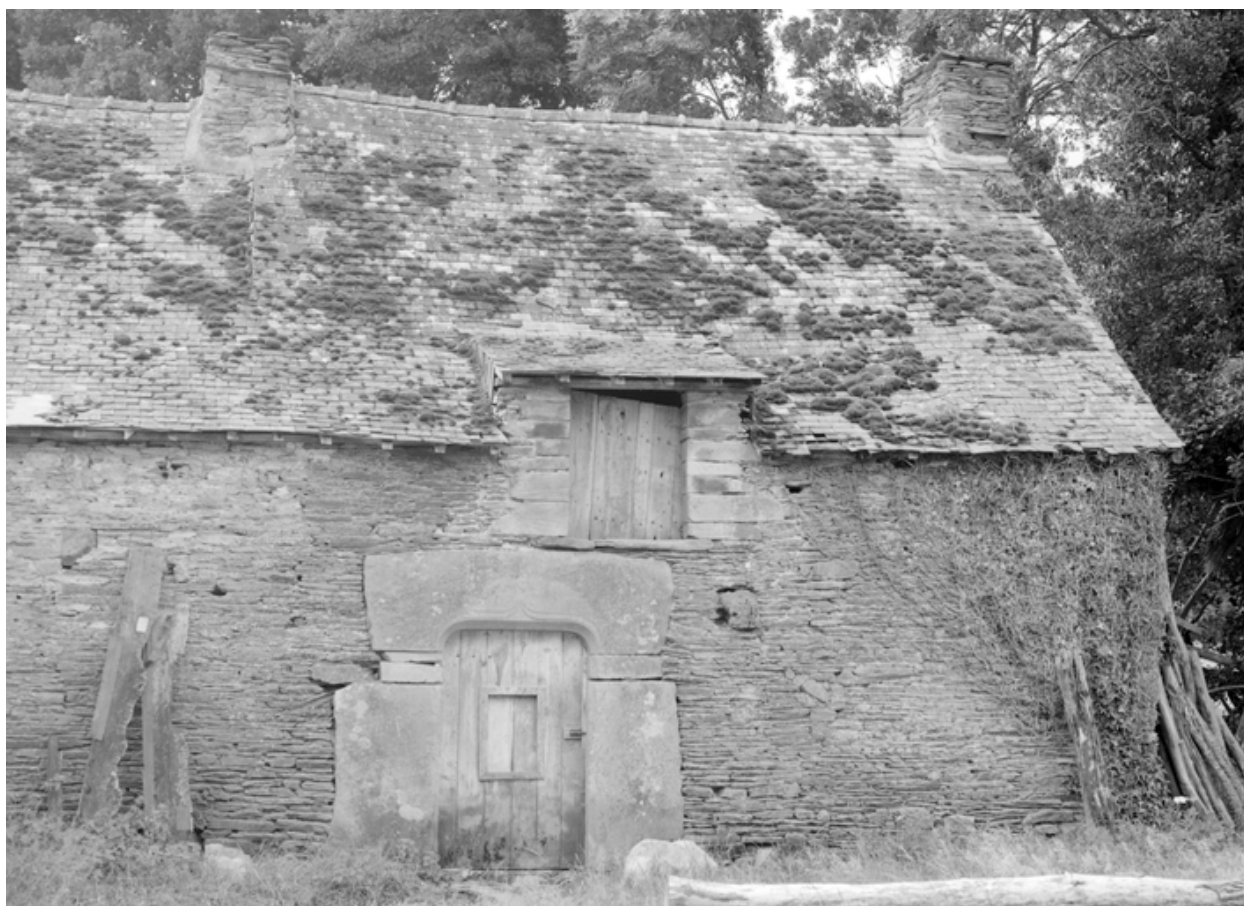
Maison : élévation nord (état en 1983)
