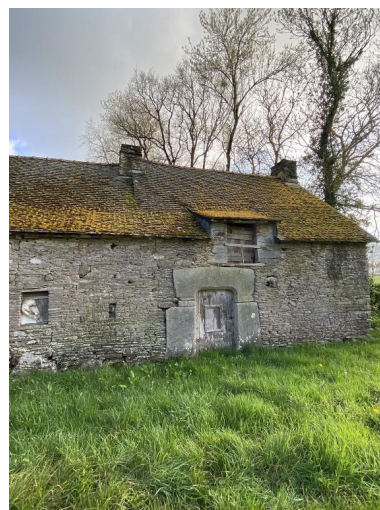
Vue générale, élévation nord-est. (état en mars 2025) Phot. Baptiste Oligo IVR53_20255610095NUCA
