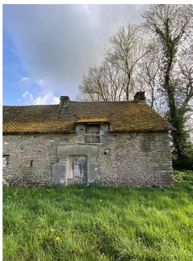
Vue générale, élévation nord. (état en mars 2025) Phot. Baptiste Oligo IVR53_20255610093NUCA
