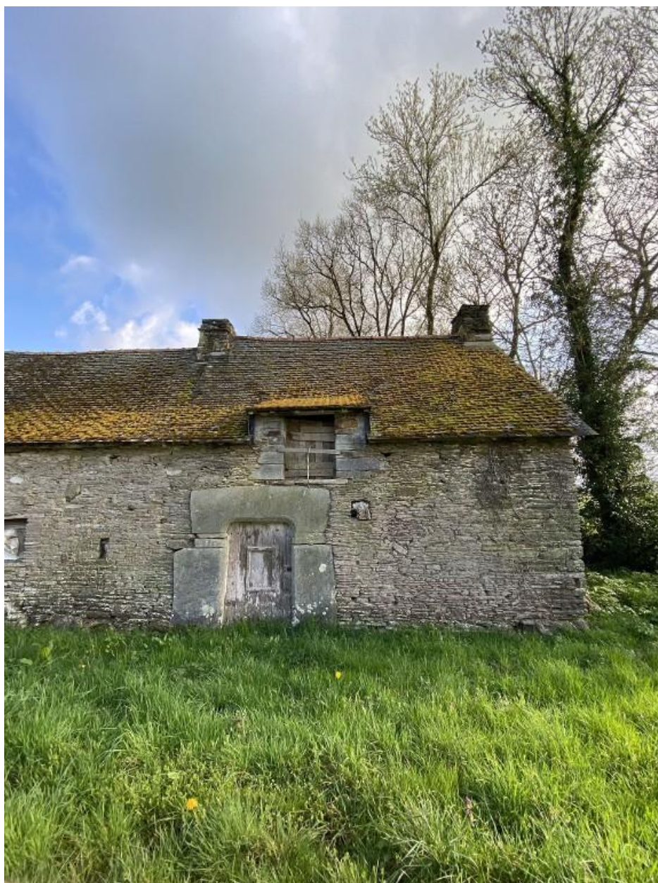
Vue générale, élévation nord. (état en mars 2025)
