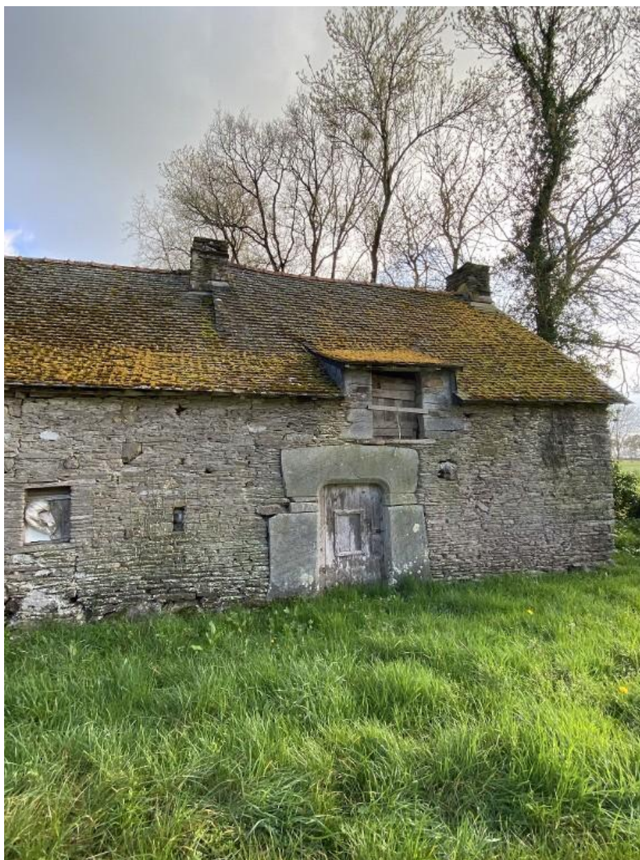
Vue générale, élévation nord-est. (état en mars 2025)
