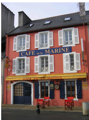
Le Café de la Marine (corps de bâtiment gauche) Phot. Françoise Péron IVR53_20062908403NUCA
