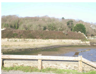
Partie orientale des lignes de Quéléren Phot. Guillaume Marie IVR53_20072908955NUCA
