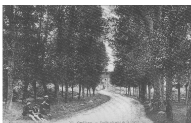
Carte postale : partie avancée de la digue (porte de Crozon) Repro. Florence Despretz IVR53_20082908507NUC
