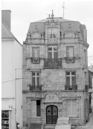
Maison : élévation sud (état en 1985) Phot. Norbert Lambart IVR53_19855600700X
