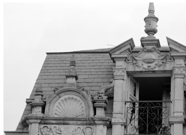
Maison, élévation sud : une lucarne (état en 1985) Phot. Norbert Lambart IVR53_19855600701X
