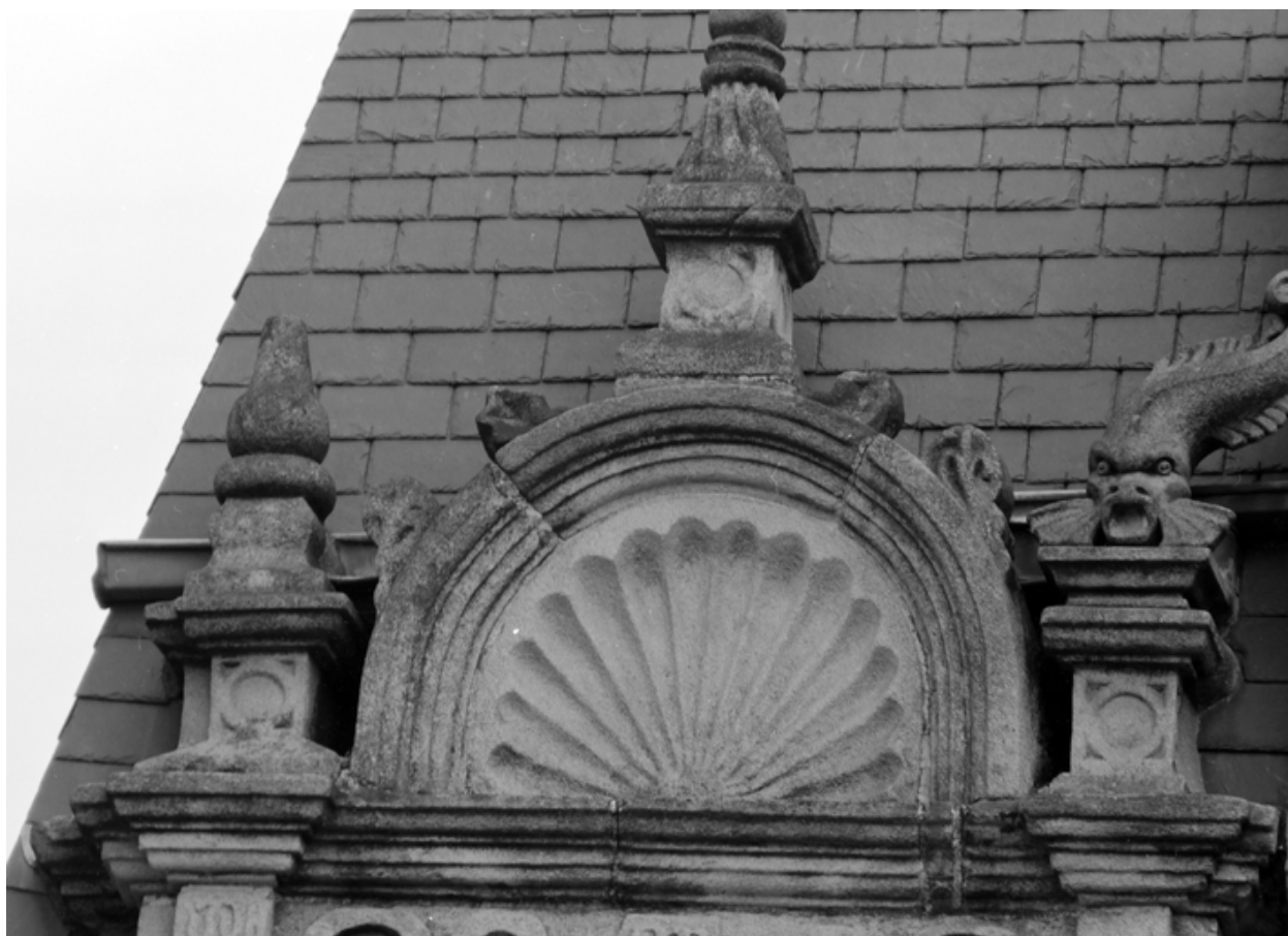
Maison, élévation sud : le fronton d'une lucarne (état en 1985)
