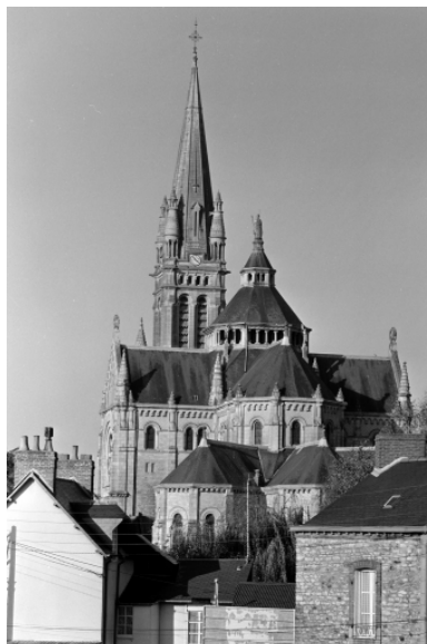
Elévation Est : vue générale. Phot. Guy Artur, Phot. Norbert Lambart IVR53_19943502186X
