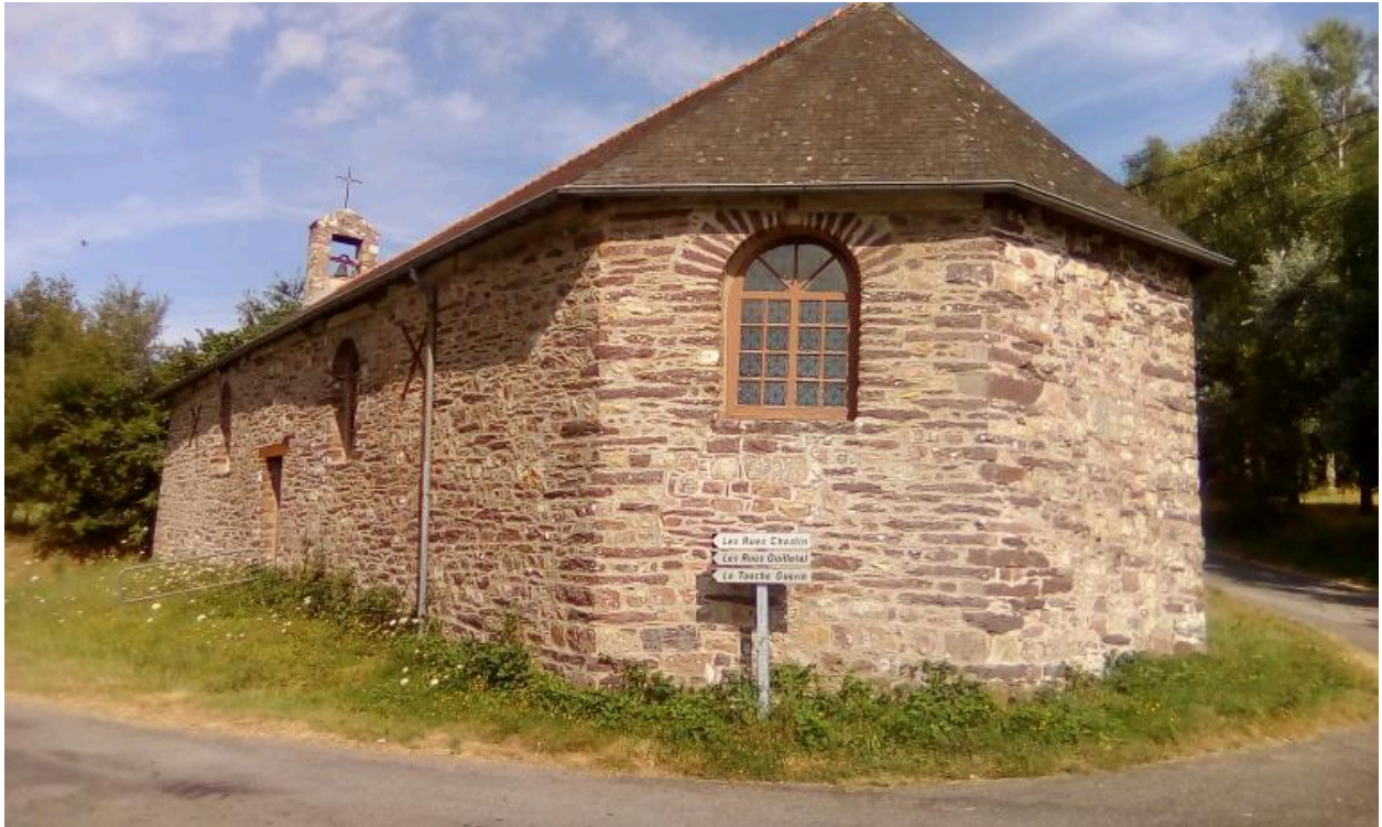
Vue générale sud-est de la chapelle
