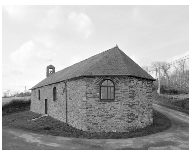
Vue générale est Phot. Bernard Bègne, Phot. M. Loyon IVR53_19933500056X
