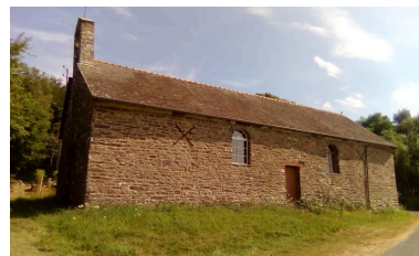
Vue générale sud de la chapelle Phot. Laurence Marquet IVR53_20183506955NUCA
