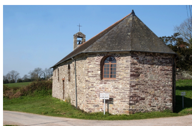
Vue générale est Phot. Guy Artur, Phot. Norbert Lambart IVR53_20023502713NUCA
