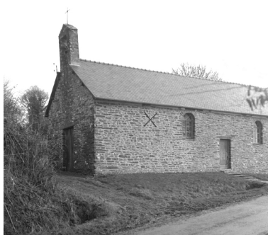
Vue générale sud en 1993 Phot. Jean-Pierre Ducouret IVR53_19823500900X
