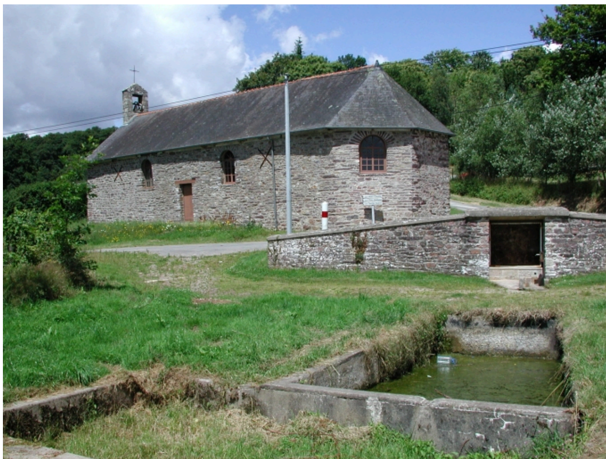
Vue générale sud
