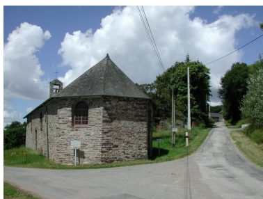
Vue de situation sud-est ; l'entrée du manoir de Beauvais à l'arrière-plan Phot. Claude Quillivic IVR53_20023513195NUCA
