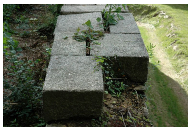
Vue de l'ouvrage à cornes de Quéliverzan : couronnement du parapet des créneaux de fusillade Phot. Guillaume Lécueillier IVR53_20052903531NUCA
