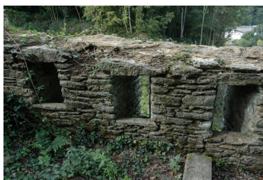
Vue de l'ouvrage à cornes de Quéliverzan : parapet des créneaux de fusillade Phot. Guillaume Lécueillier IVR53_20052903532NUCA
