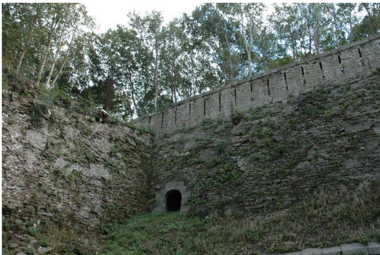
Vue de l'ouvrage à cornes de Quéliverzan : poterne débouchant dans le fossé sec surmontée de créneaux de fusillade
