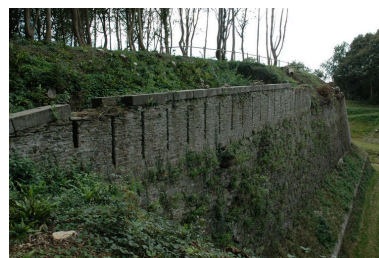
Vue de l'ouvrage à cornes de Quéliverzan : parapet des créneaux de fusillade Phot. Guillaume Lécueillier IVR53_20052903533NUCA
