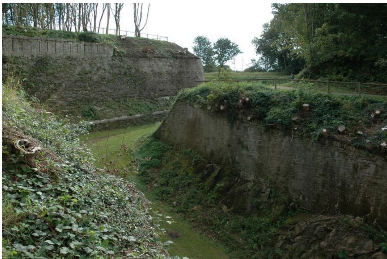
Vue de l'ouvrage à cornes de Quéliverzan : fossé sec, escarpe et contrescarpe
