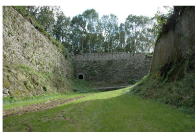
Vue de l'ouvrage à cornes de Quéliverzan : poterne débouchant dans le fossé sec surmontée de créneaux de fusillade Phot. Guillaume Lécueillier IVR53_20052903523NUCA
