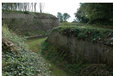
Vue de l'ouvrage à cornes de Quéliverzan : fossé sec, escarpe et contrescarpe Phot. Guillaume Lécueillier IVR53_20052903537NUCA
