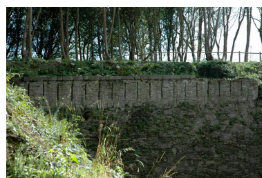
Vue de l'ouvrage à cornes de Quéliverzan : créneaux de fusillade Phot. Guillaume Lécueillier IVR53_20052903536NUCA
