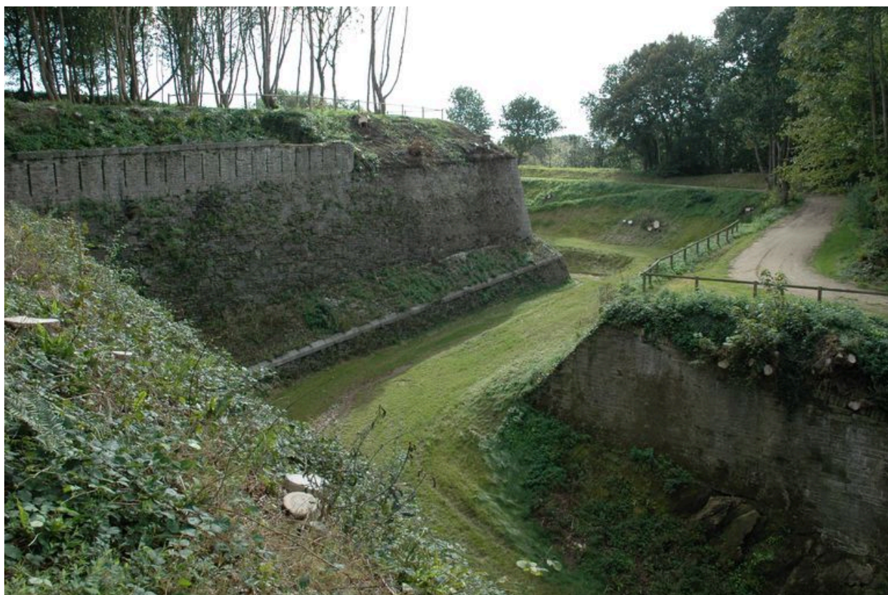
Vue de l'ouvrage à cornes de Quéliverzan : fossé sec dominé par un parapet percé de créneaux de fusillade
