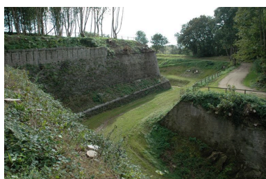
Vue de l'ouvrage à cornes de Quéliverzan : fossé sec dominé par un parapet percé de créneaux de fusillade Phot. Guillaume Lécueillier IVR53_20052903534NUCA
