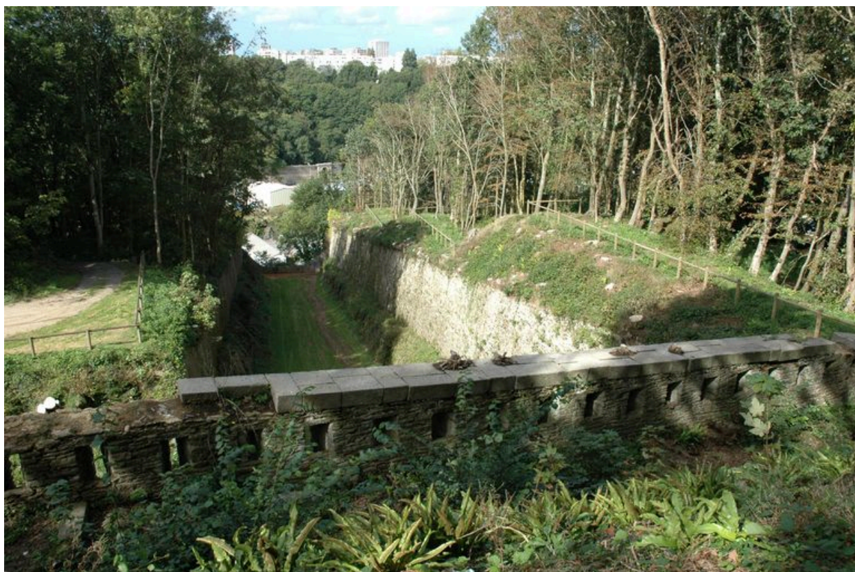
Vue de l'ouvrage à cornes de Quéliverzan : créneaux de fusillade flanquant le fossé et le pied de la courtine
