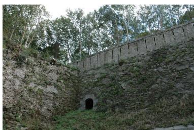
Vue de l'ouvrage à cornes de Quéliverzan : poterne débouchant dans le fossé sec surmontée de créneaux de fusillade Phot. Guillaume Lécueillier IVR53_20052903520NUCA
