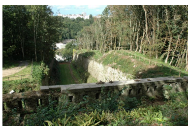
Vue de l'ouvrage à cornes de Quéliverzan : créneaux de fusillade flanquant le fossé et le pied de la courtine Phot. Guillaume Lécueillier IVR53_20052903526NUCA
