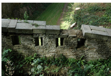
Vue de l'ouvrage à cornes de Quéliverzan : créneaux de fusillade Phot. Guillaume Lécueillier IVR53_20052903529NUCA
