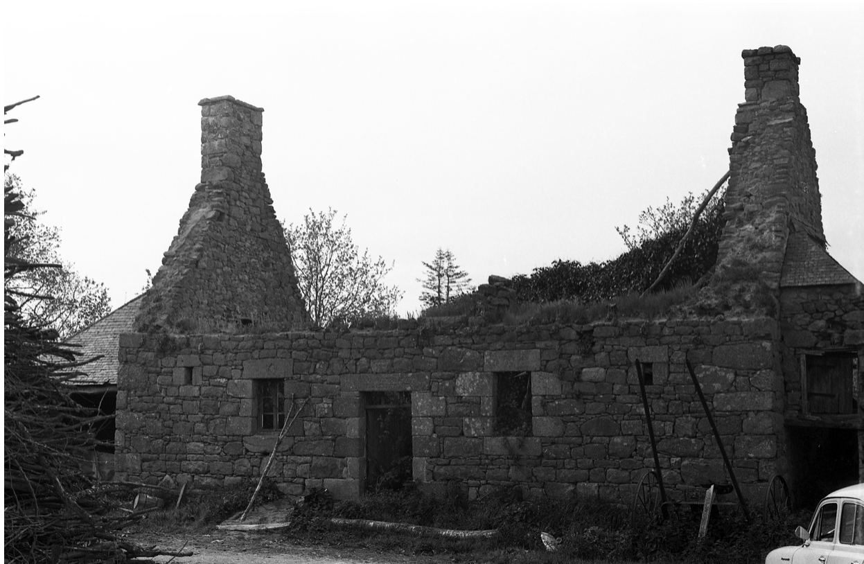
Vue générale de la façade sud
