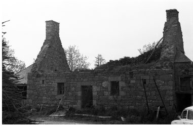
Vue générale de la façade sud
