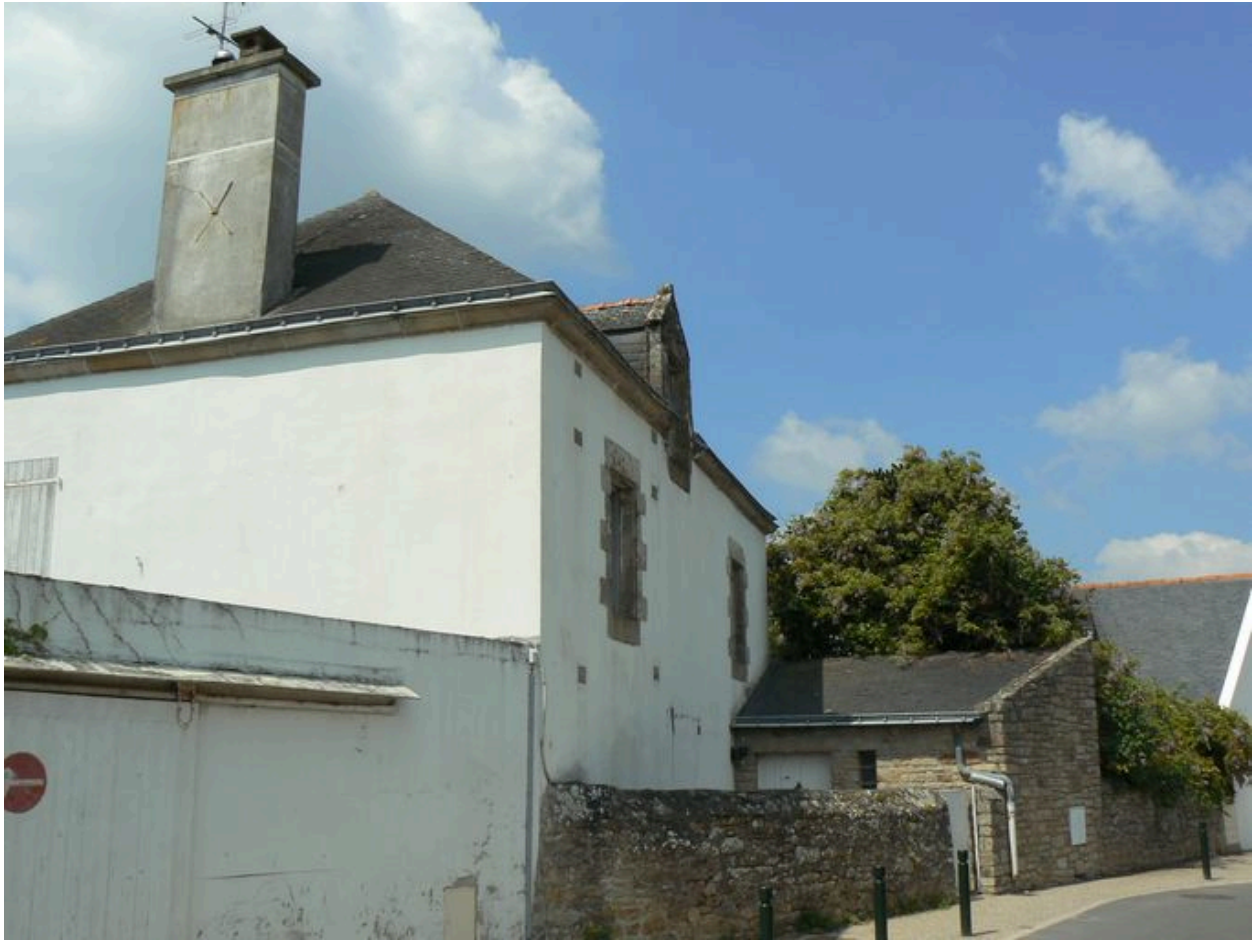
Vue générale de la maison de capitaine du 12 rue de la Pointe du Bill
