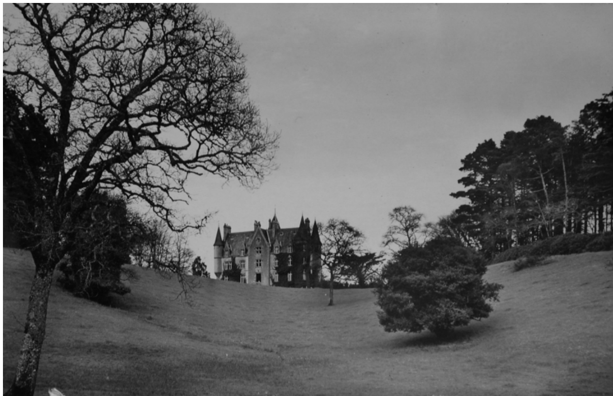
Vue de situation dans les années 1960
