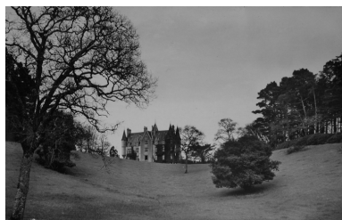
Vue de situation dans les années 1960
