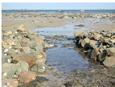
Vue du pertuis Nord-Ouest bien conservé et opérationnel Phot. Guy Prigent IVR53_20082208087NUCA
