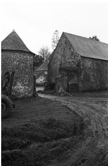
Entrée ouest de la basse- cour (nord-ouest). Phot. Jean-Claude Groussard IVR53_19683500522Z
