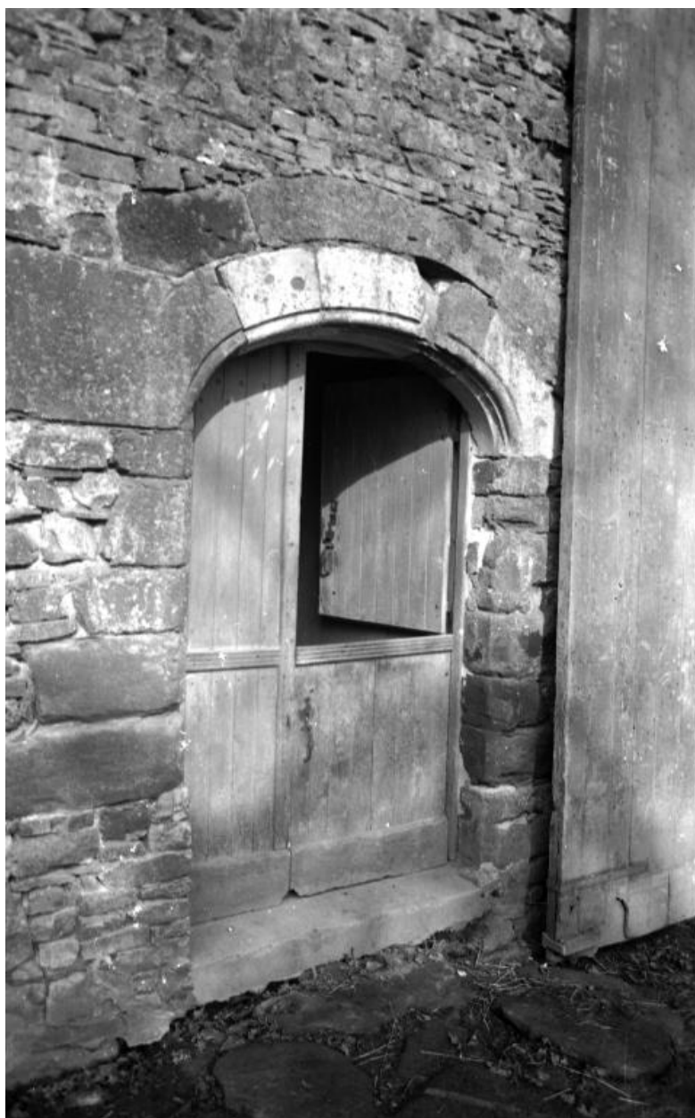
Porte de communs, vue de détail.
