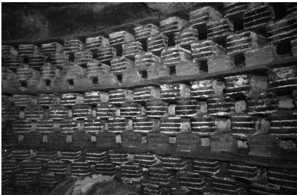
Pigeonnier, intérieur, vue de détail.
