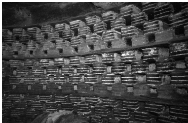
Pigeonnier, intérieur, vue de détail. Phot. Jean-Claude Groussard IVR53_19683500530Z
