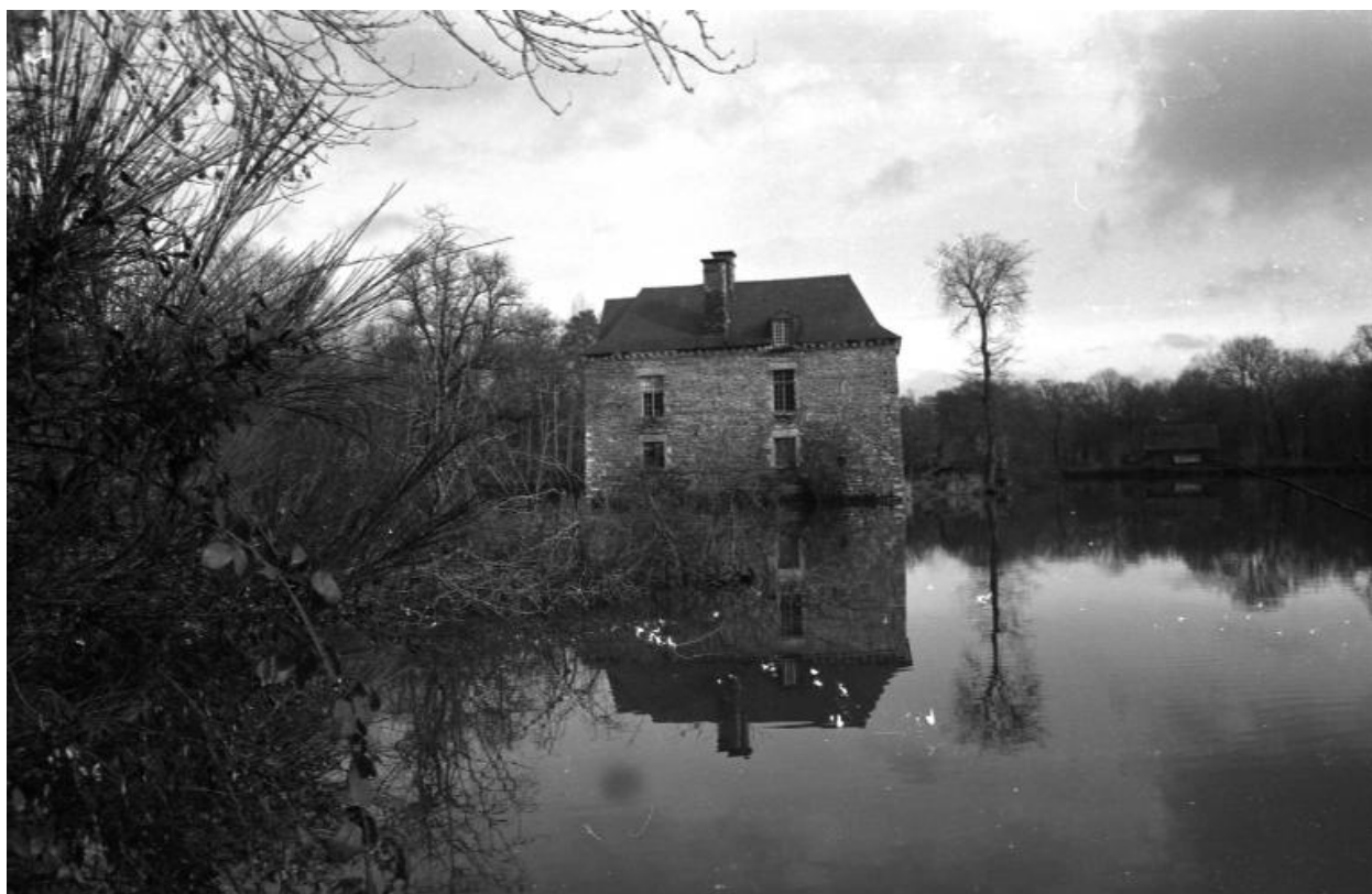
Vue de situation sud.
