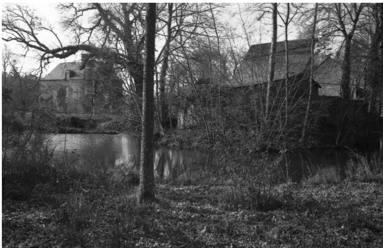
Vue de situation du nord-est.
