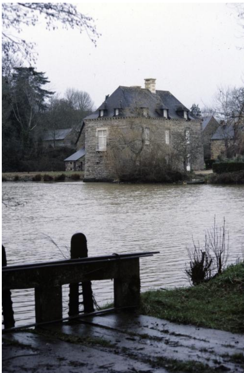
Vue de situation prise du sud-est.
