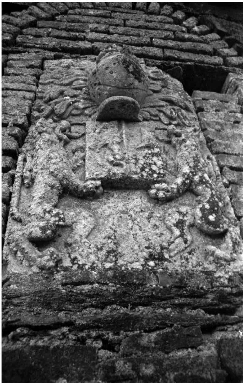
Pigeonnier, écusson, vue de détail.
