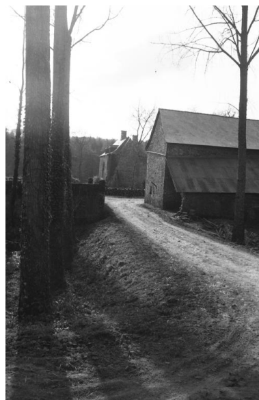
Entrée de la cour avec château, prise du nord-ouest. Phot. Jean-Claude Groussard IVR53_19683500640Z
