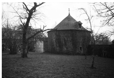
Entrée ouest de la basse-cour. Phot. Jean-Claude Groussard IVR53_19683500639Z
