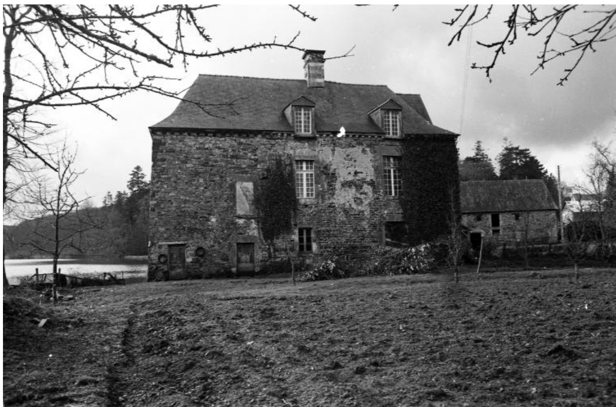
Face nord, vue générale.
