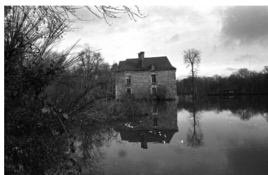
Vue de situation sud. Phot. Jean-Claude Groussard IVR53_19683500525Z
