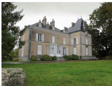
Façade ouest Phot. Frédéric Déan IVR53_20133520070NUCA
