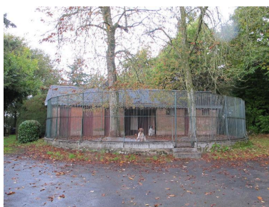
Chenil : vue générale Phot. Frédéric Déan IVR53_20133520069NUCA
