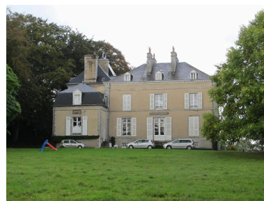
Façade est Phot. Frédéric Déan IVR53_20133520072NUCA
