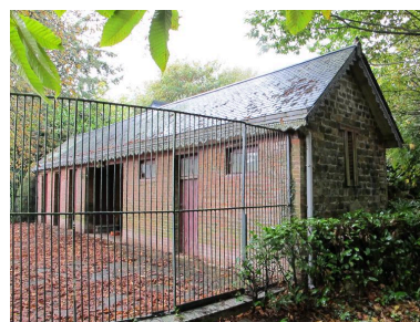
Chenil : vue générale Phot. Frédéric Déan IVR53_20133520073NUCA
