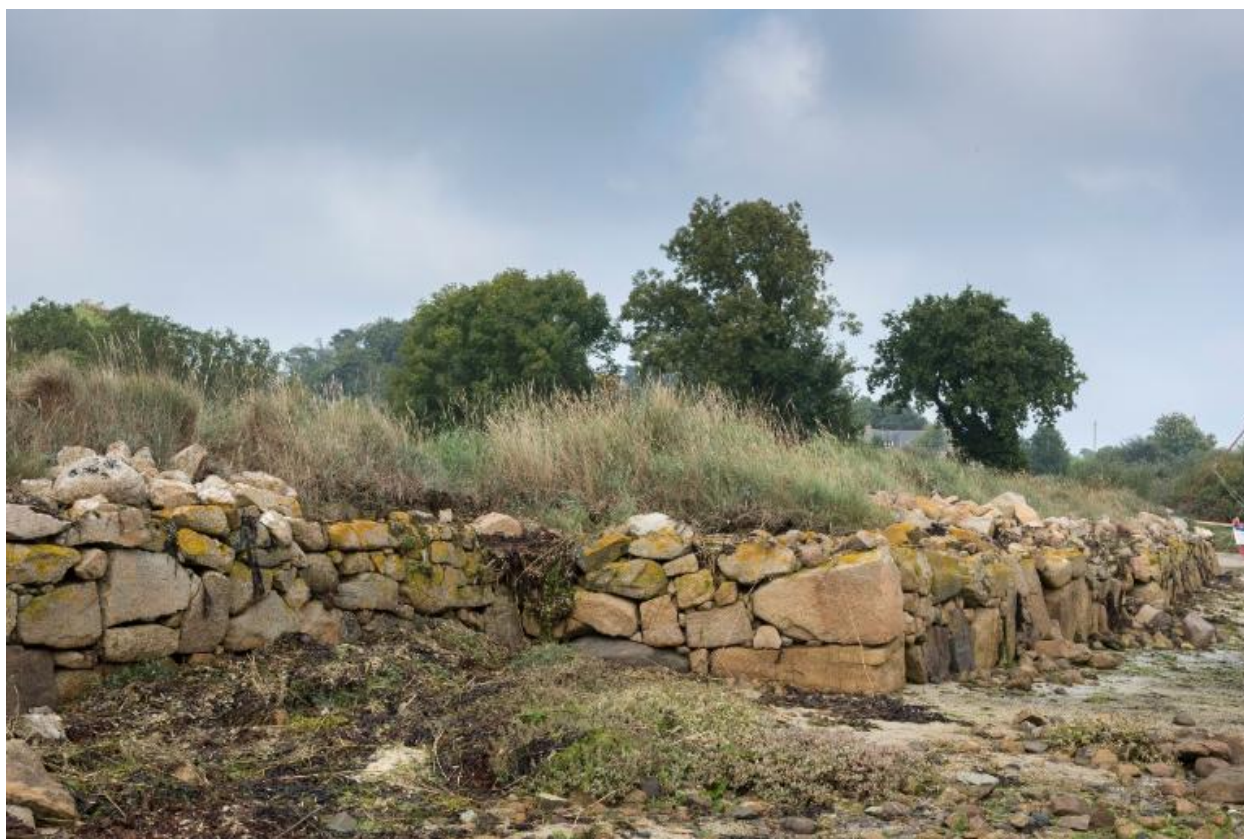
Vue d'ensemble d'un mur de soutènement composé de gros blocs de granite, sur la rive ouest de l'anse de Pellinec
