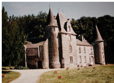
Vue générale de la façade antérieure Phot. Elise Lauranceau IVR53_20052904361NUCA
