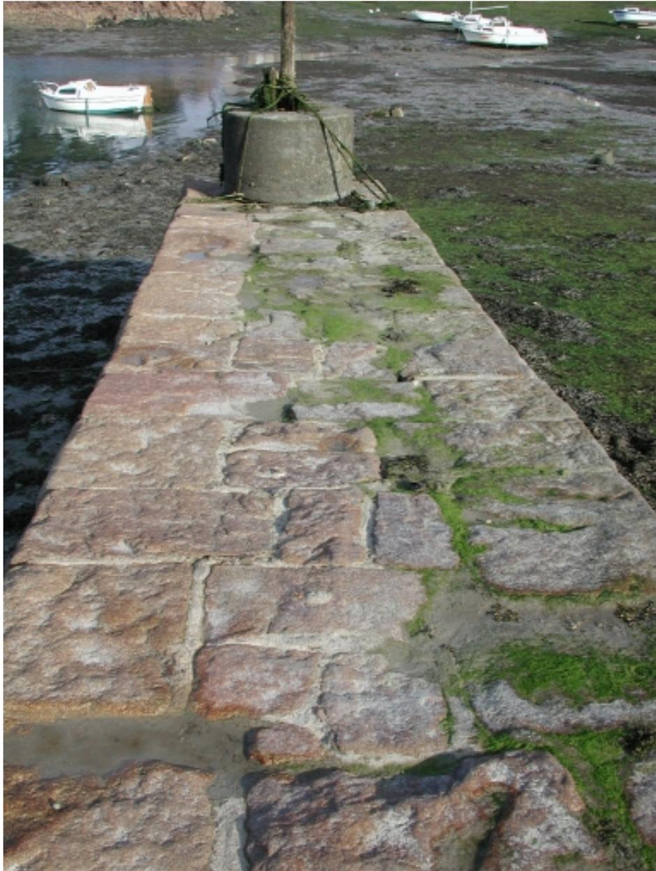
Vue du parement de la jetée Ouest : remarquer la disposition des pierres maçonnées
