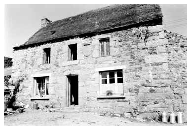
Maison 3 (Saint Goudan, au sud de la maison 2) : élévation sud Phot. Jean-Pierre Ducouret IVR53_19662200752Z
