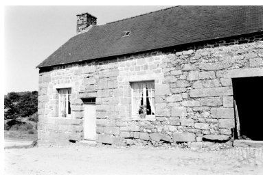
Maison (Les îles) : élévation sud Phot. Jean-Pierre Ducouret IVR53_19662200757Z
