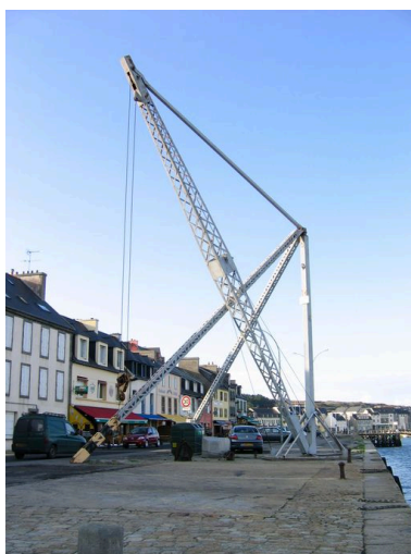
Grue à mâter et de levage sur le quai Toudouze Phot. Guillaume Marie IVR53_20062908341NUCA
