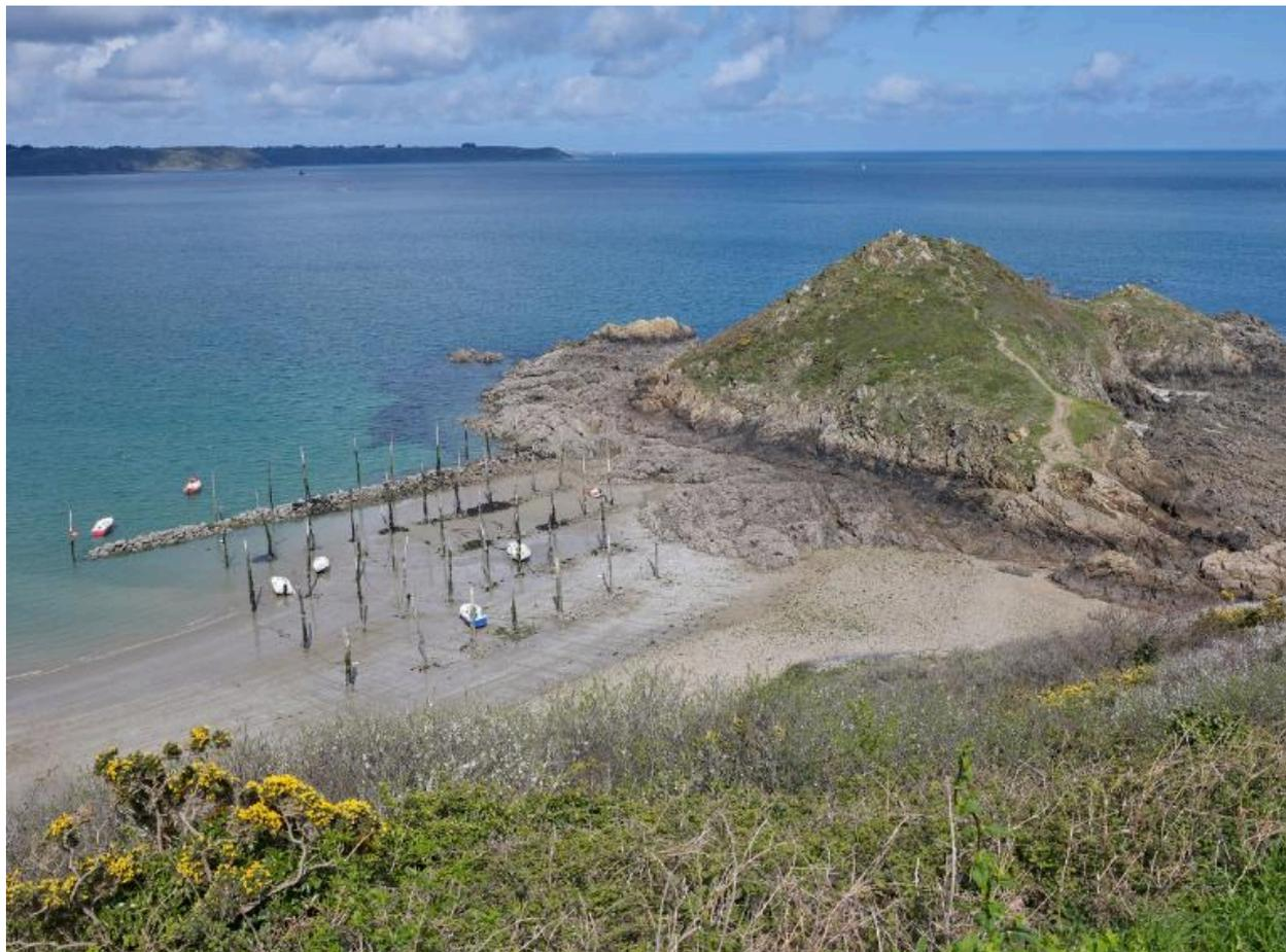
A marée basse, alignement de mouillage et enrochements formant brise-houle
