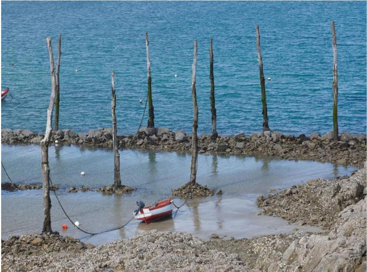
A marée basse, alignement d'enrochement pour maintenir les pieux de mouillage et formant brise-houle
