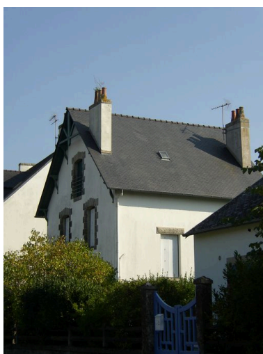
Villa Les Ajoncs, côté mer Phot. Johan Vincent IVR53_20062908692NUCA
