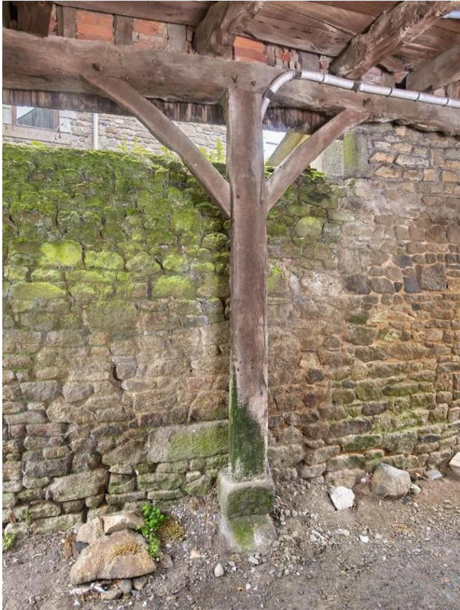
Des marques d'assemblages sont visibles sur le pied des aisseliers (II et III).
