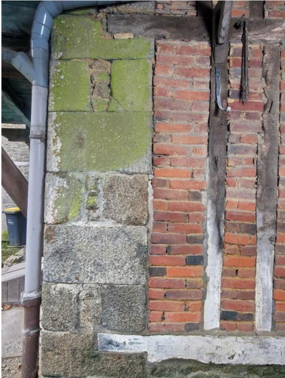
Encastrement, dans le mur maçonné, du pan de bois contemporain hourdis de briques.
