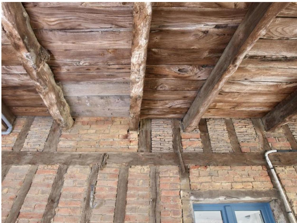
Un plancher recouvre les solives du porche. Le rez-de-chaussée est comblé par un pan de bois avec hourdis de brique.
