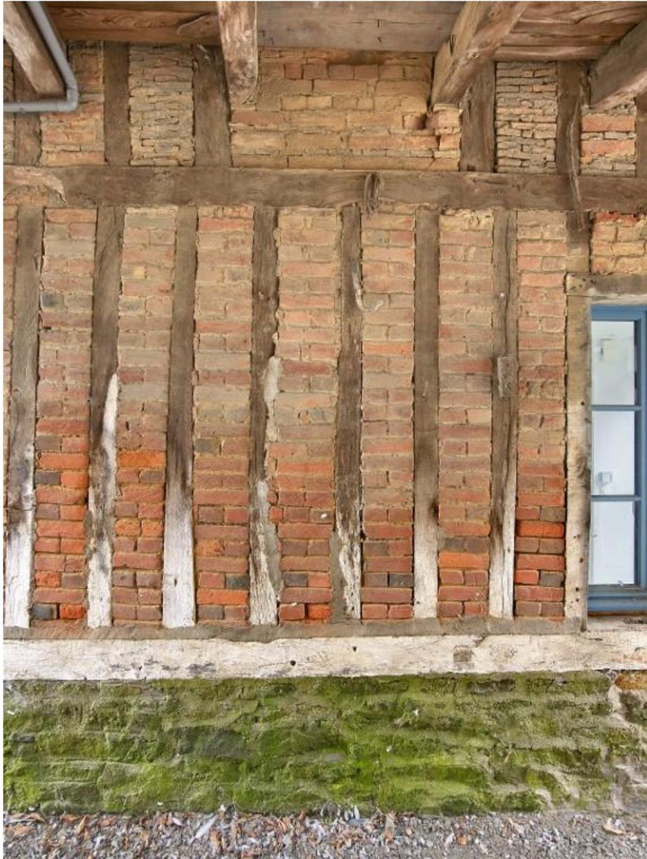
Ce pan de bois en grille repose sur un mur bahut en pierre et est hourdis de briques.
