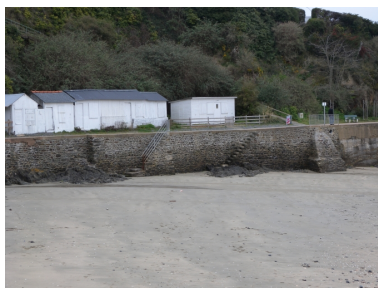
Vue des cabines de bains alignées sur la digue- promenade de l'anse aux Moines Phot. Guy Prigent IVR53_20082213195NUCA
