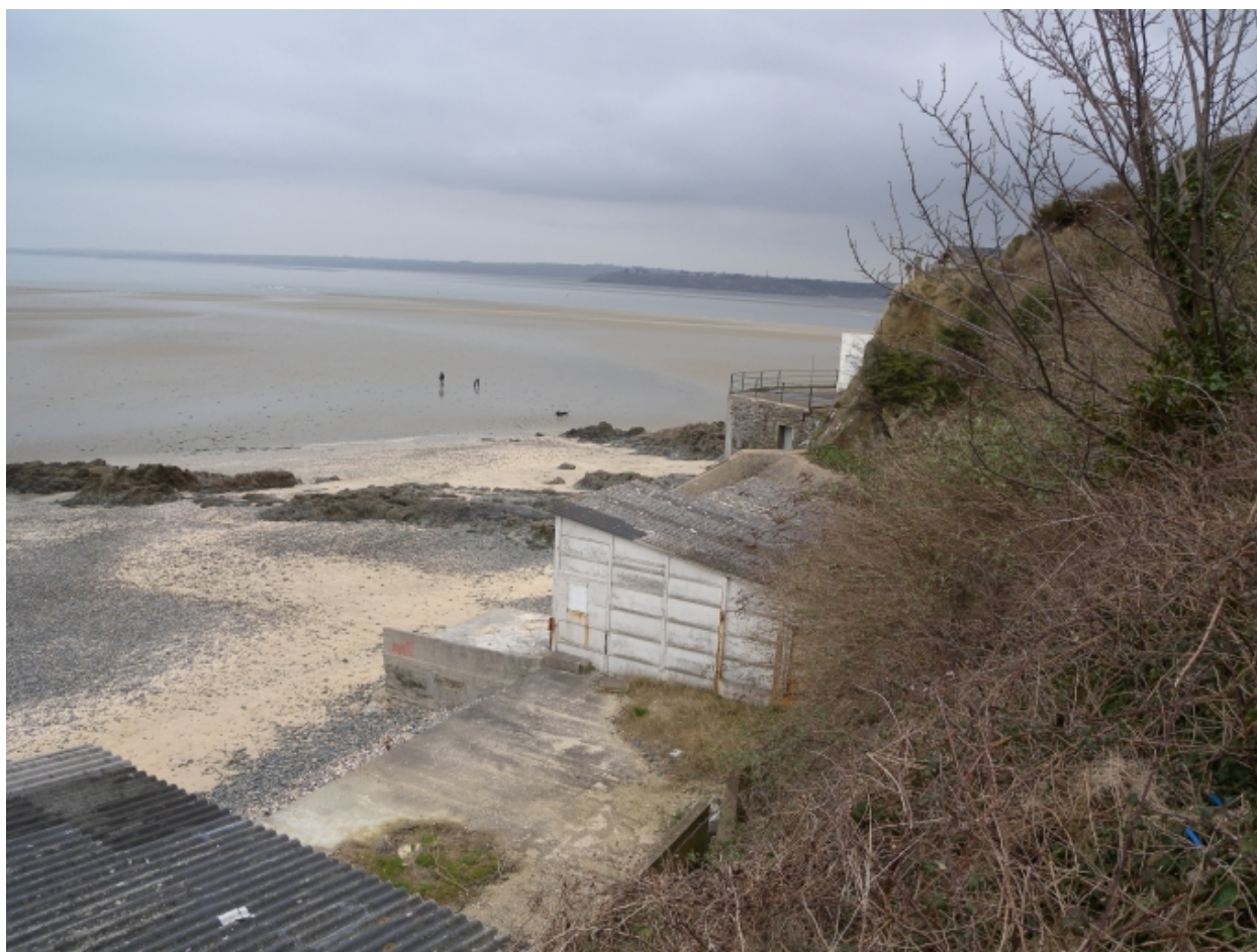
Vue des cabines de bains contemporaines en ciment et tôle nervurée en couverture
