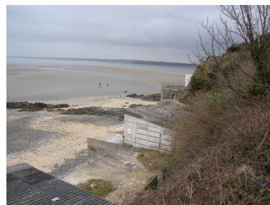
Vue des cabines de bains contemporaines en ciment et tôle nervurée en couverture Phot. Guy Prigent IVR53_20082213196NUCA
