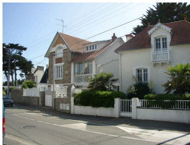
Maison de villégiature Les Algues Phot. Johan Vincent IVR53_20065606548NUCA
