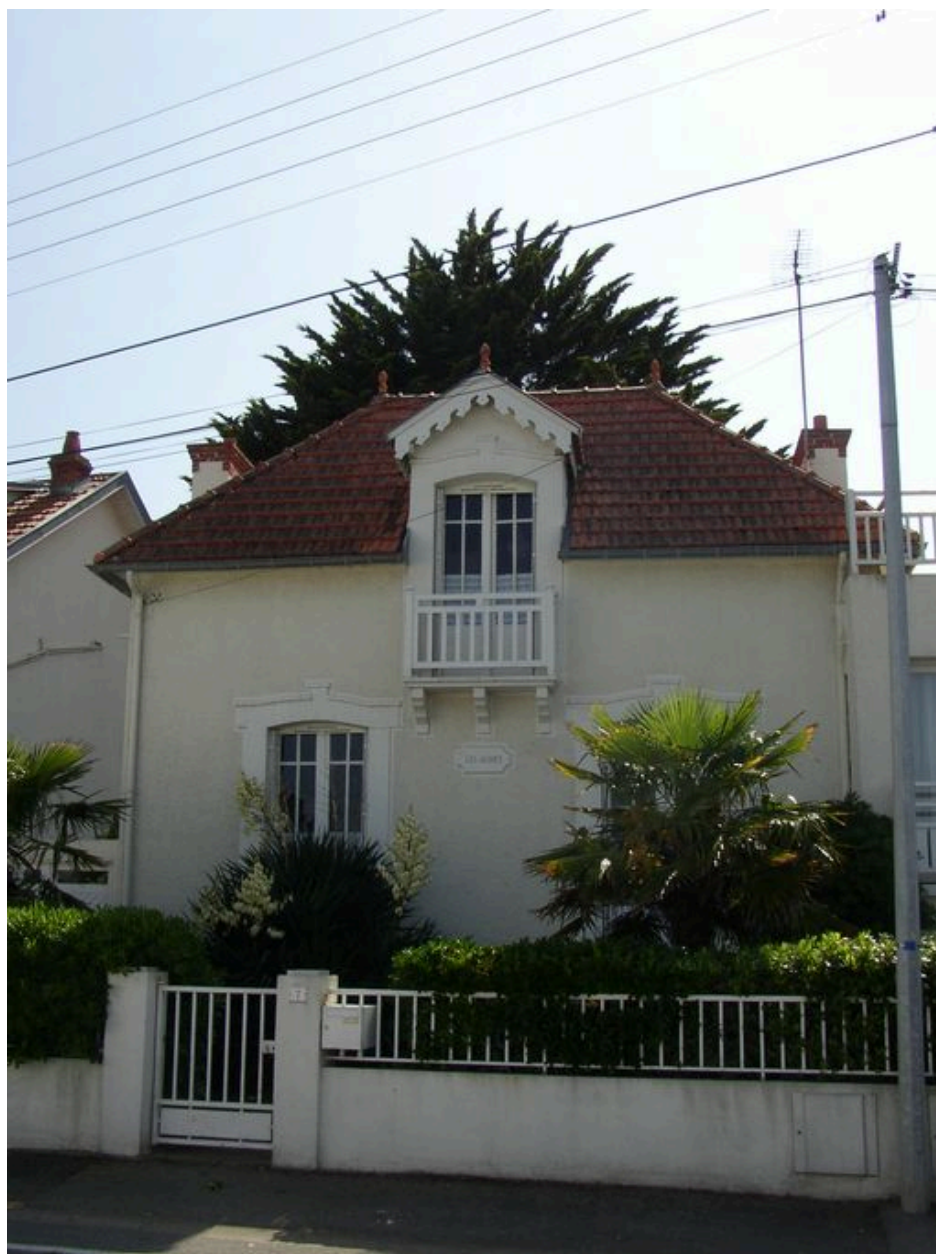
Vue générale de la maison de villégiature Les Algues
