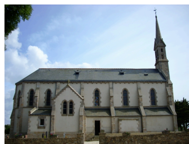
Plouarzel, église de Trézien : élévation nord Phot. Gwénaél Fauchille IVR53_20082906235NUCA
