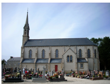
Plouarzel, église de Trézien : élévation sud Phot. Gwénaél Fauchille IVR53_20082906234NUCA
