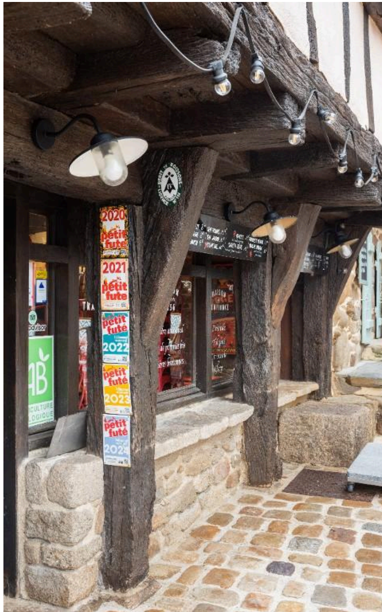
Fort encorbellement porté au rez-de-chaussée par des poteaux renforcés de pigeâtres (1 rue Saint-René).
