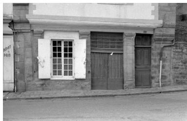
Rez-de-chaussée divisé par des pilastres "à l'antique" (56-58 rue du Château).
