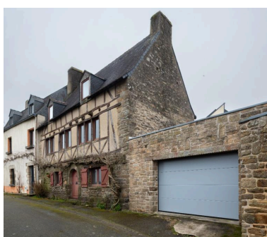
Maison dont l'étage et le surcroît sont en pan de bois et témoignent d'une reprise importante (22 rue Neuve).
