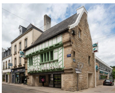
Façade en pan de bois en partie refaite et profondément modifiée au rez-de-chaussée commercial (1 rue Jean-Marie Barre).
