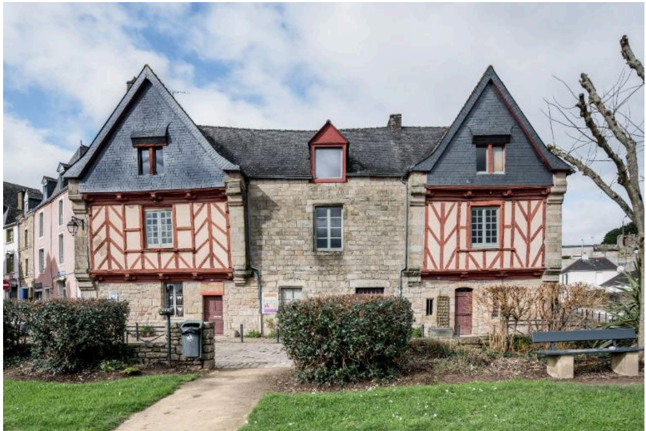
Alignement de trois façades construites de façon concomitante, dont celle du centre a perdu son pan de bois (26-28 rue Philippe Vannier).
