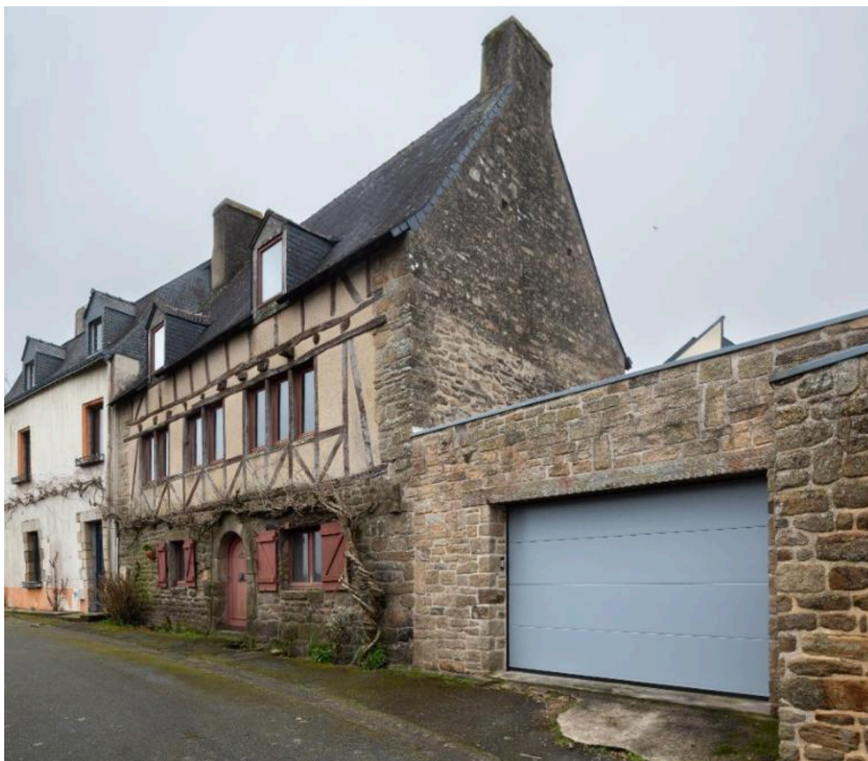
Maison dont l'étage et le surcroît sont en pan de bois et témoignent d'une reprise importante (22 rue Neuve).
