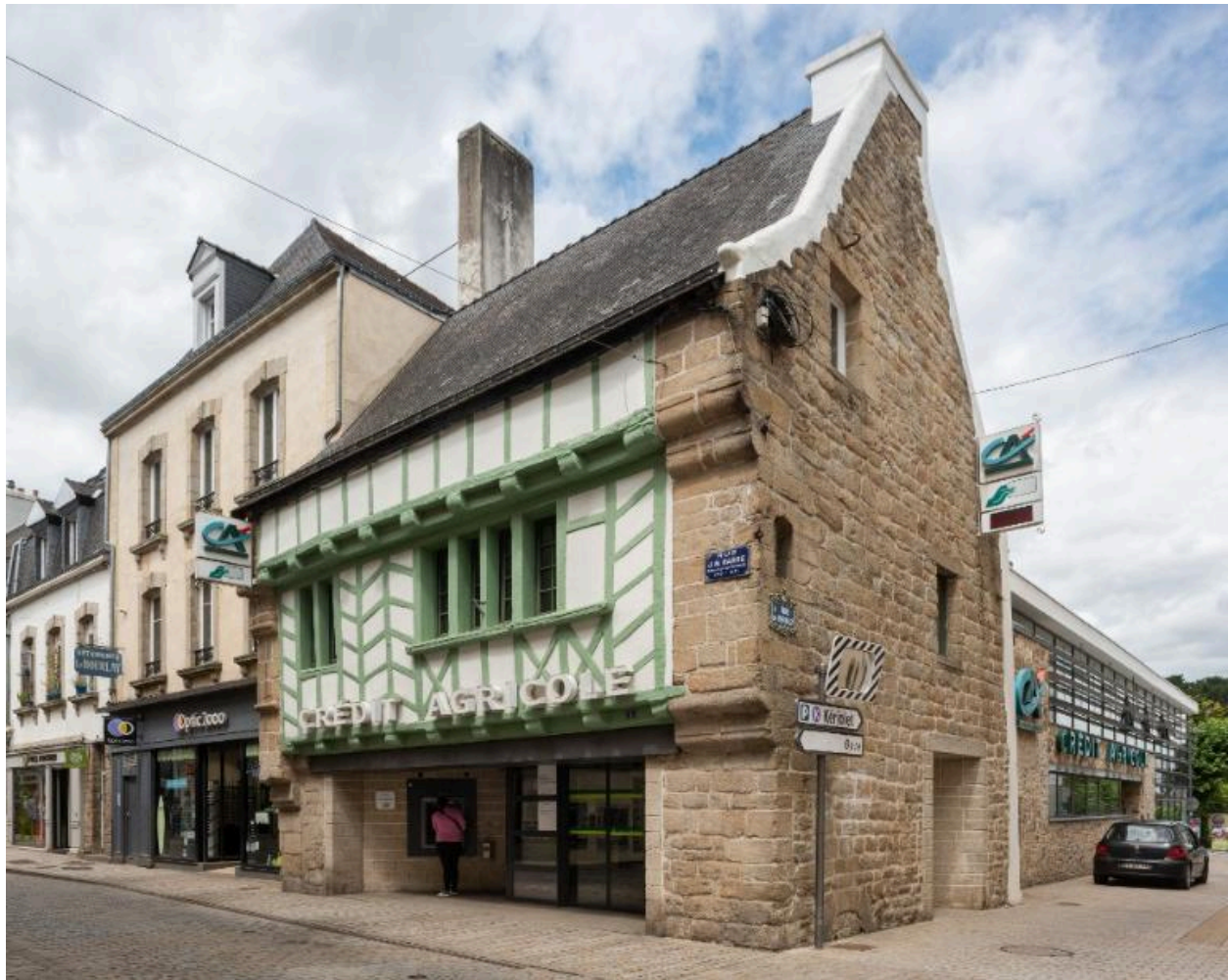
Façade en pan de bois en partie refaite et profondément modifiée au rez-de-chaussée commercial (1 rue Jean-Marie Barre).
