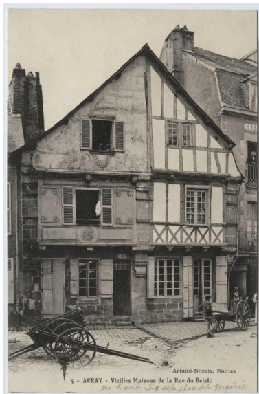
Maison divisée en deux logements sous un pignon unique. Un mur mitoyen sépare jusqu'au premier étage (rue du Belzic).
