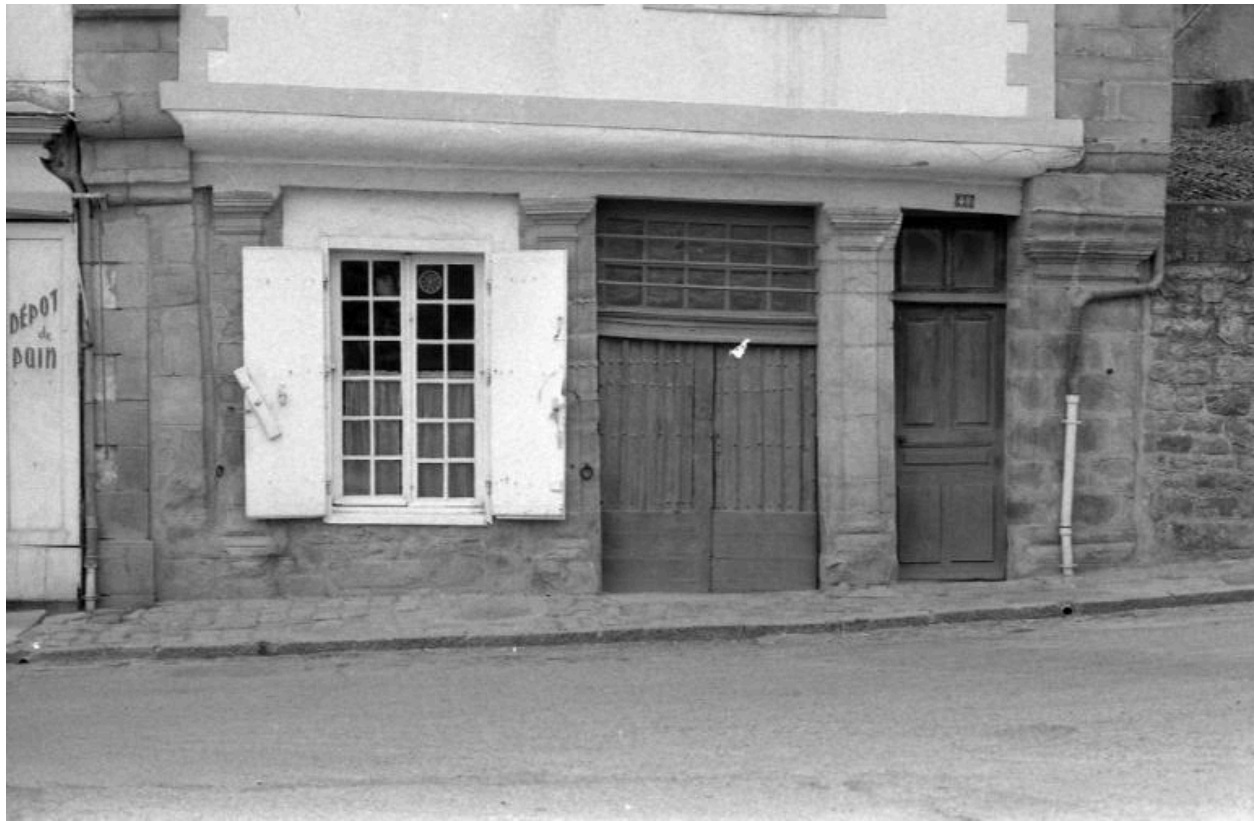
Rez-de-chaussée divisé par des pilastres "à l'antique" (56-58 rue du Château).
