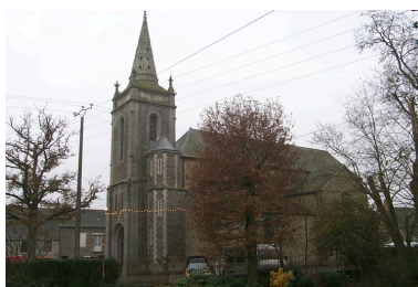
Vue partielle nord-est Phot. Xavier Gilbert IVR53_20013507369NUCA
