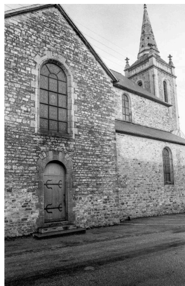
Vue partielle de la façade sud (état en 1973) Phot. Martine Brin IVR53_19733505574Z
