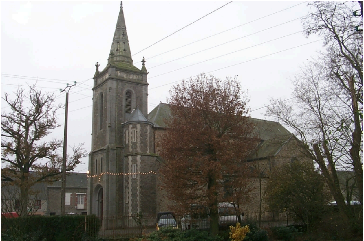
Vue partielle nord-est
