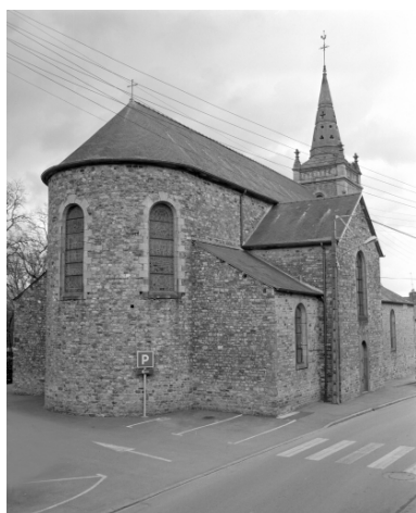
Chevet : vue générale sud-ouest Phot. Guy Artur, Phot. Norbert Lambart IVR53_19943500789X
