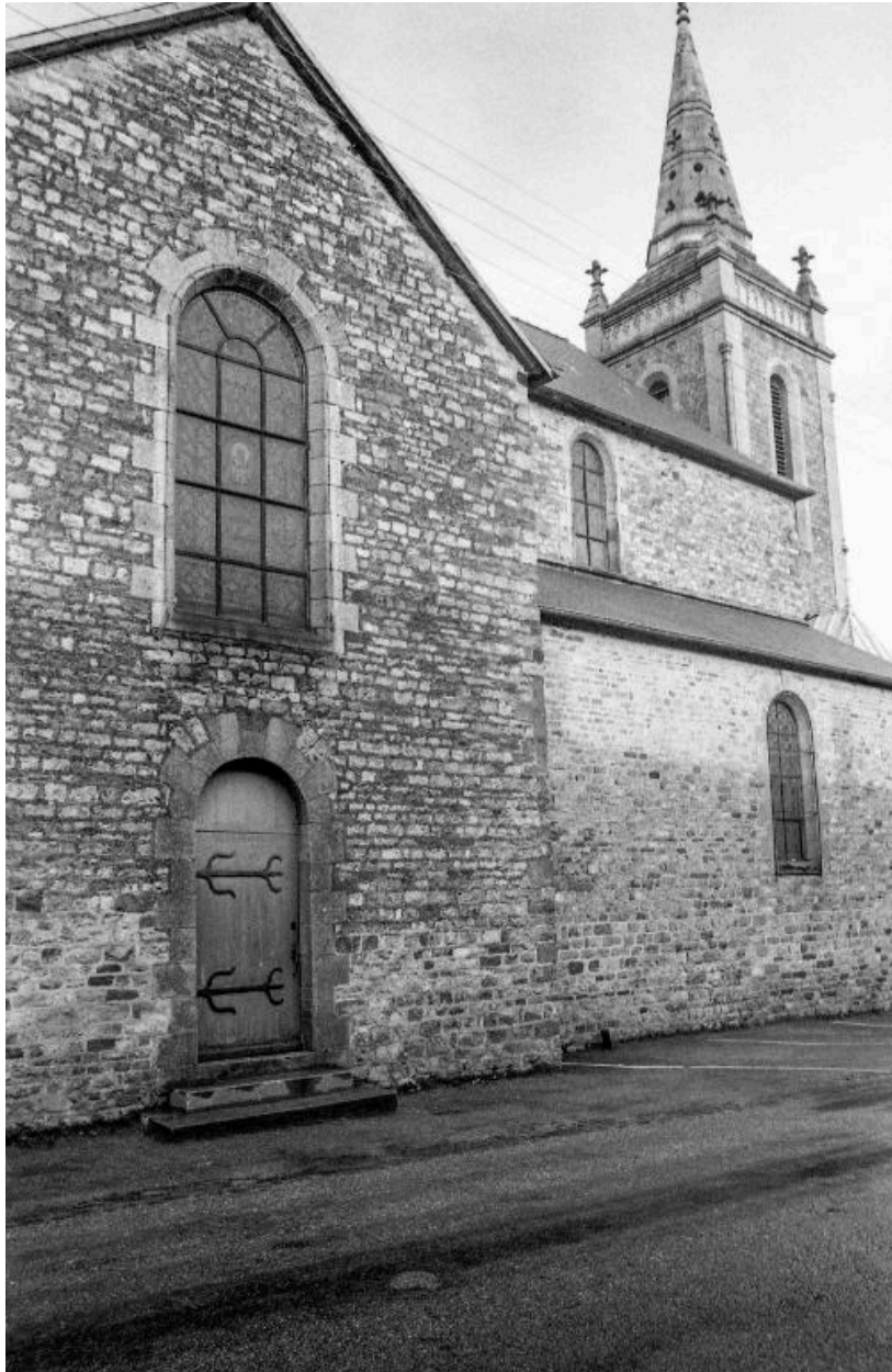
Vue partielle de la façade sud (état en 1973)
