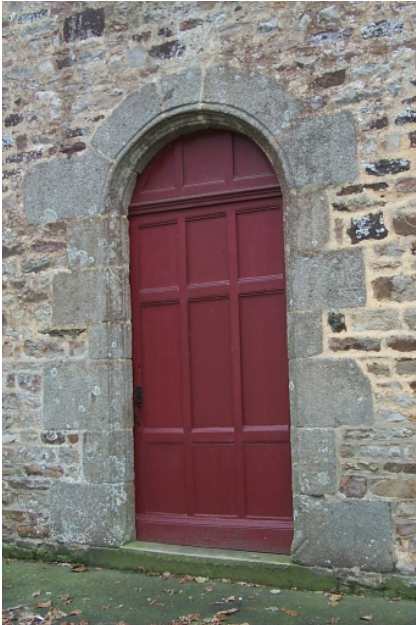
Porte ancienne réemployée dans la façade nord
