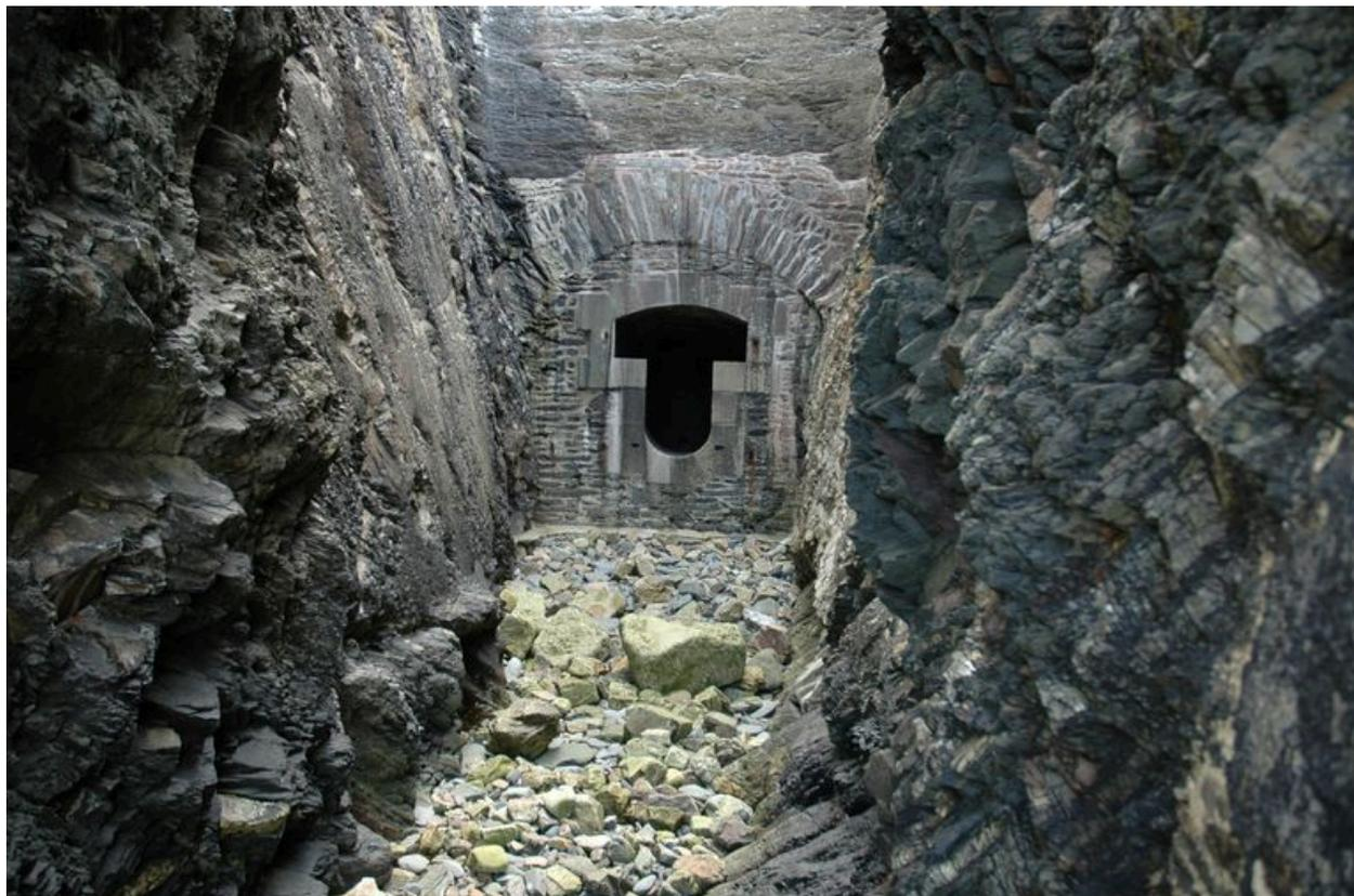
Vue de l'une des deux embrasures de la batterie casematée de Cornouaille : couloir aménagé dans le terre-plein / falaise de la batterie de Vauban pour permettre le passage des obus (état en 2005)
