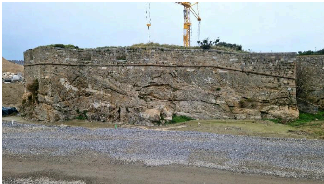
Vue générale depuis le sud (couverture photographique du 17 décembre 2025)
