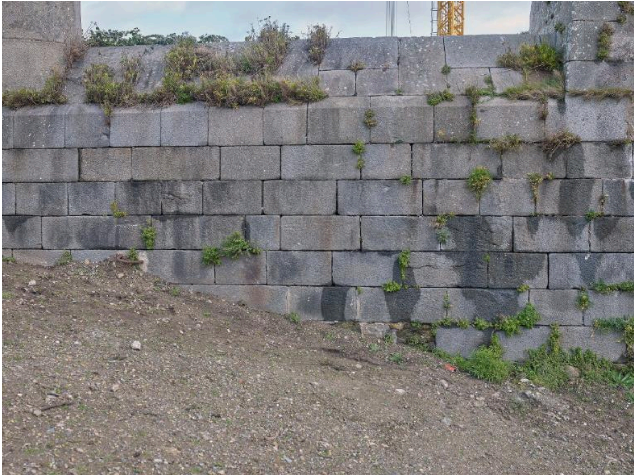
Vue de détail de la maçonnerie en pierre de taille de granite de la digue du fossé (couverture photographique du 22 janvier 2026)
