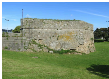
Vue de détail de l'escarpe ouest (état en 2015). Fondée sur le rocher, cette partie du fort est montée en maçonnerie de moellon et en pierre de taille Phot. Guillaume Lécueillier IVR53_20263510025NUCA
