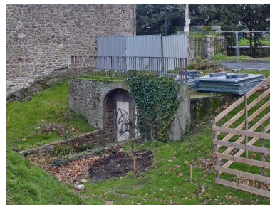
Vue des sanitaires situés au sud-est du fort (couverture photographique du 22 janvier 2026) Phot. Bernard Bègne IVR53_20263500131NUCA
