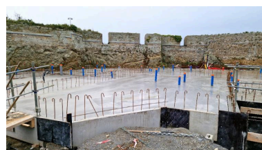
Vue de l'escarpe depuis le nord-est (couverture photographique du 17 décembre 2025). Au premier plan, la future gare maritime
