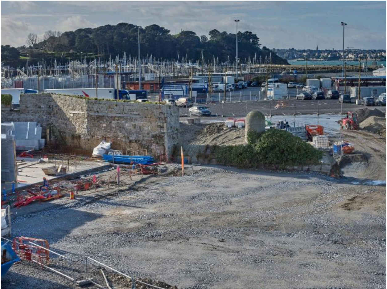
Vue générale depuis le nord-est : intérieur de l'escarpe, digue et dame du fossé (couverture photographique du 22 janvier 2026). A gauche, le chantier de la gare maritime du Naye
