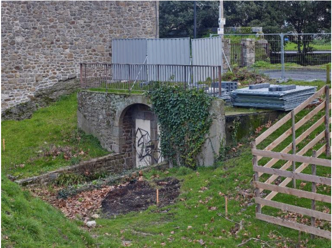
Vue des sanitaires situés au sud-est du fort (couverture photographique du 22 janvier 2026)
