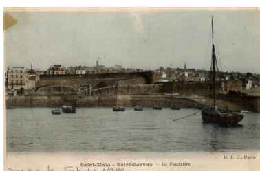
Vue générale depuis le nord, carte postale (B.J.C., Paris). De gauche à droite, on distingue le fort du Naye (mur crénelé et pont levis) et l'avant-port avec digue et cale. En arrière-plan, la ville de Saint-Servan Phot. Archives municipales de Saint-Malo IVR53_20263510180NUCA
