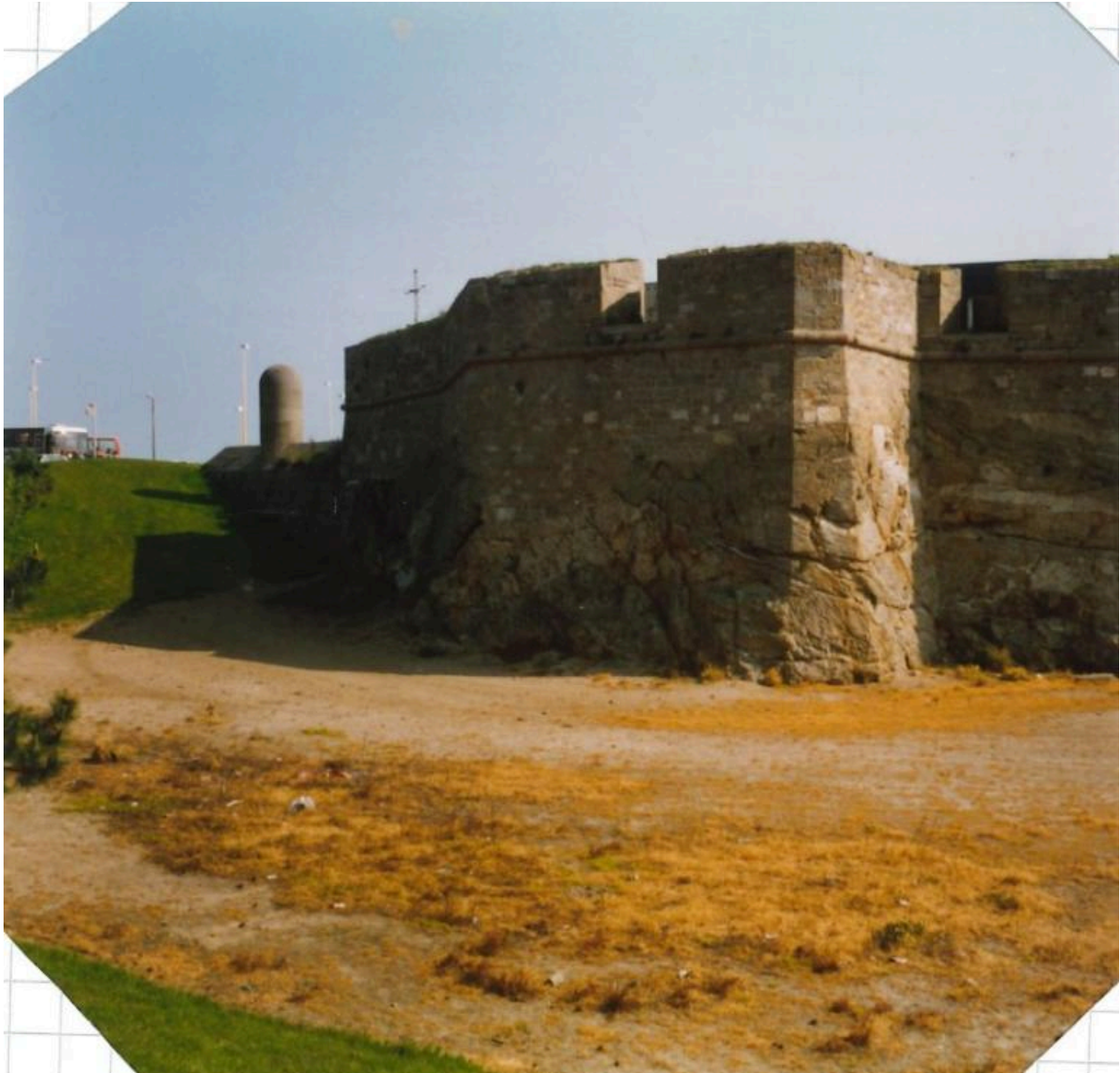
Vue générale depuis le sud, mai 1991
