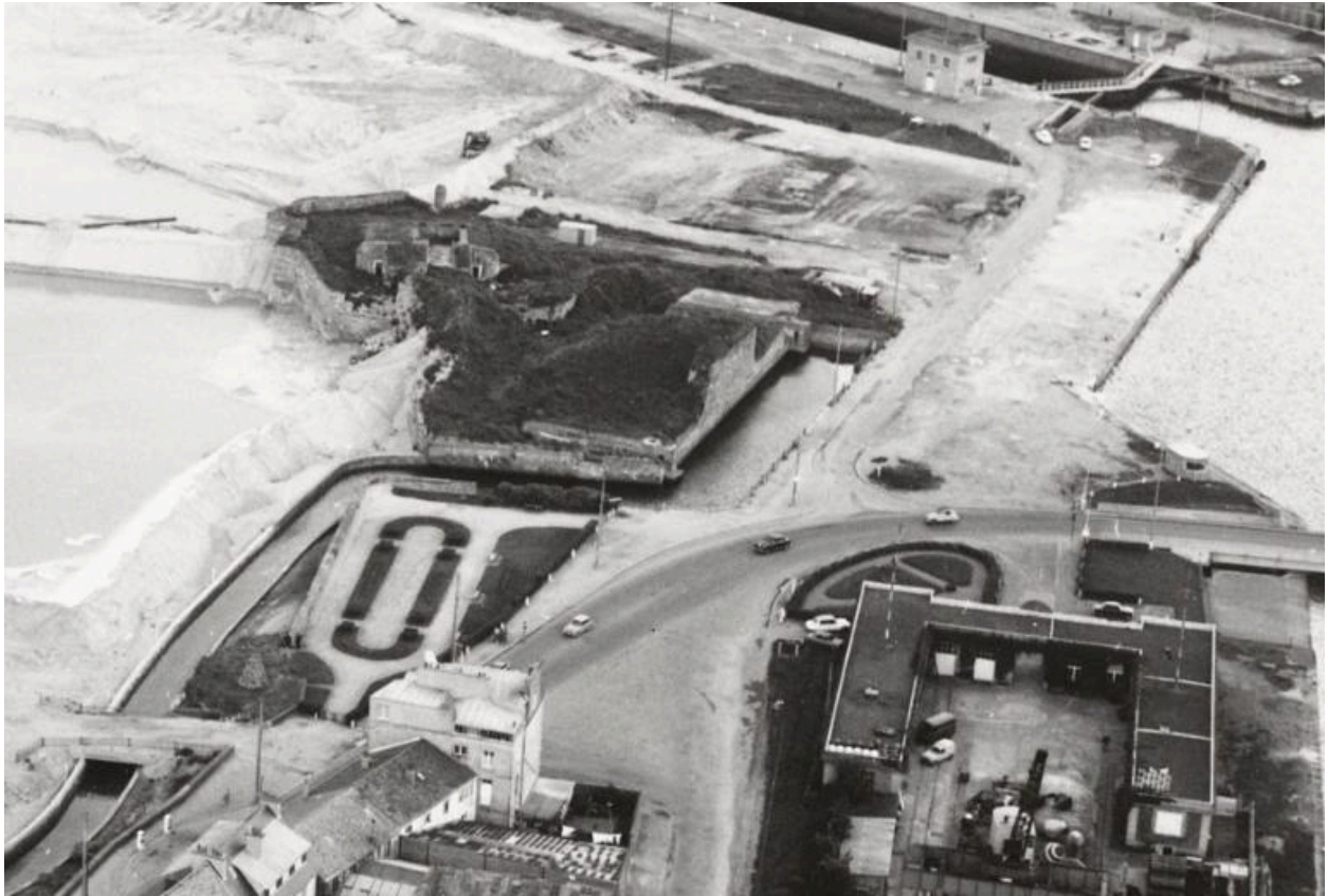
Vue aérienne oblique du fort du Naye depuis le sud-est, 14 juin 1971
