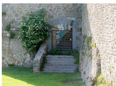
Vue de la porte en arc surbaissé aménagée dans le flanc de l'escarpe (état en 2015). Cette partie du fort a été remontée comme l'atteste la mise en oeuvre de la maçonnerie Phot. Guillaume Lécueillier IVR53_20263510031NUCA
