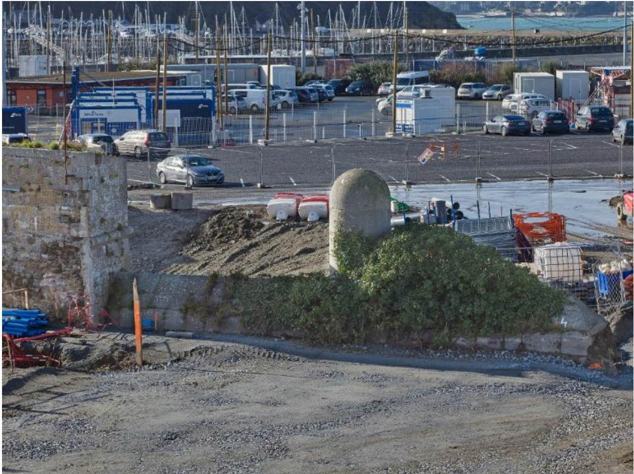
Vue depuis le nord-est : digue et dame du fossé (couverture photographique du 22 janvier 2026)
