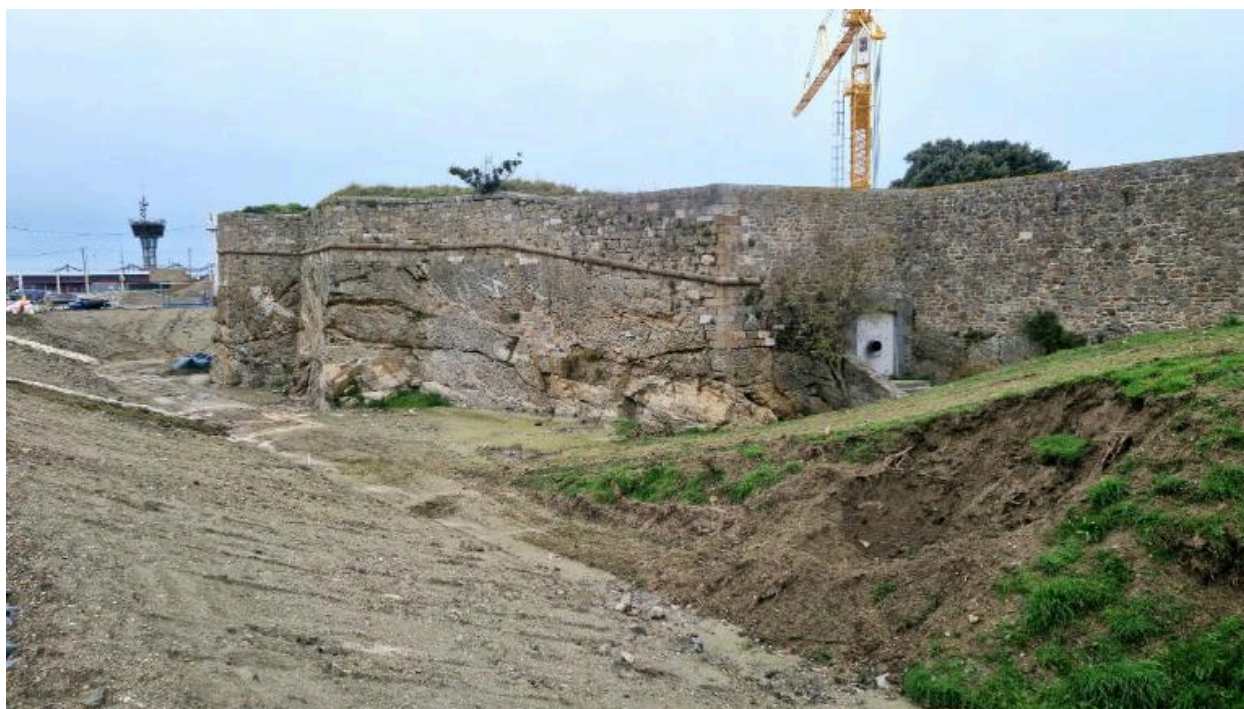
Vue générale depuis le sud-est (couverture photographique du 17 décembre 2025)
