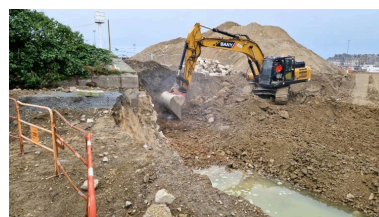
Vue de l'excavation réalisée dans l'alignement nord de la digue du fossé (couverture photographique du 17 décembre 2025)
