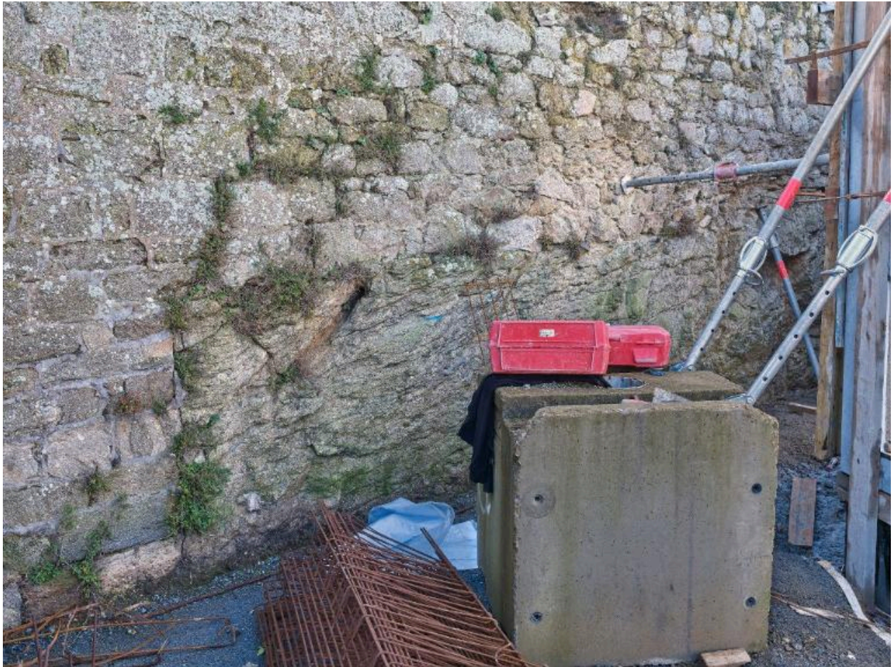
Vue de détail de l'intérieur de l'escarpe (couverture photographique du 22 janvier 2026). Au premier plan, le chantier de la gare maritime du Naye
