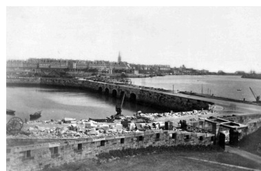
Vue du fort du Naye : front nord-ouest. Au premier plan, le mur crénelé et le pont-levis ; on distingue également au second plan la contrescarpe. Sur le quai de l'avant-port de Saint-Servan : un chantier de taille de pierre. En arrière-plan, Saint-Malo Phot. Auteur inconnu IVR53_20263510100NUC
