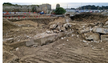
Vue de situation depuis le nord (couverture photographique du 17 décembre 2025). Au premier plan, les vestiges du quai de l'avant-port de Saint-Servan. Il est construit en maçonnerie de pierre de taille de granite Phot. Guillaume Lécueillier IVR53_20263510075NUCA
