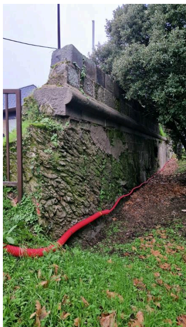
Vue des vestiges de l'escarpe au sud-est (couverture photographique du 17 décembre 2025) Phot. Guillaume Lécueillier IVR53_20263510069NUCA
