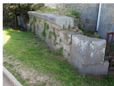
Vue des vestiges de l'escarpe à l'est, le long du rond-point du Naye (état en 2015). En arrière-plan à droite, le bâtiment des Douanes Phot. Guillaume Lécueillier IVR53_20263510033NUCA
