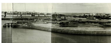
Extrait de la vue panoramique du terre-plein du Naye depuis les Bas Sablons, vers 1966-1967 (Archives municipales de Saint-Malo). Le nouveau polder est en cours de remplissage par du sable de mer. A l'extrême droite, le fort du Naye Repro. Guillaume Lécueillier IVR53_20263510259NUCA
