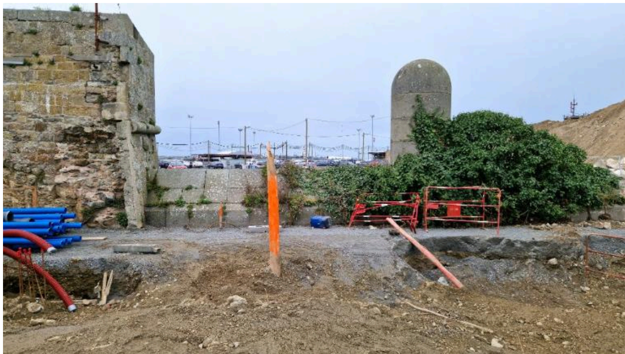
Vue de la digue et de la dame du fossé depuis l'est (couverture photographique du 17 décembre 2025). Cette partie du fort est montée en maçonnerie de pierre de taille de granite
