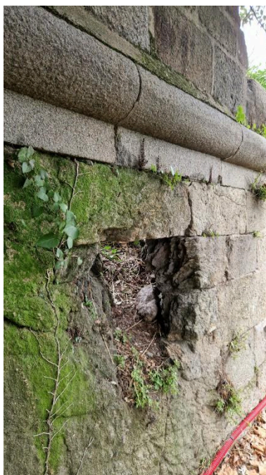
Vue des vestiges de l'escarpe au sud-est (couverture photographique du 17 décembre 2025) Phot. Guillaume Lécueillier IVR53_20263510070NUCA
