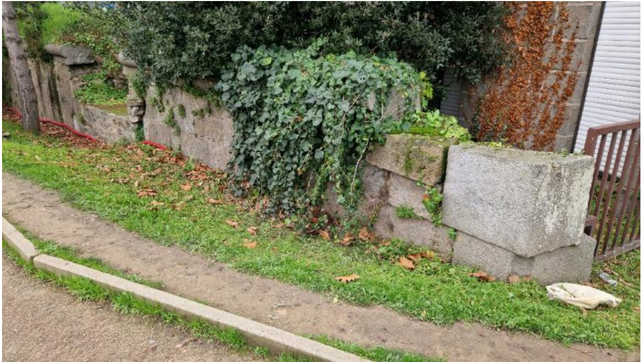
Vue des vestiges de l'escarpe à l'est, le long du rond-point du Naye (couverture photographique du 17 décembre 2025). En arrière-plan à droite, le bâtiment des Douanes
