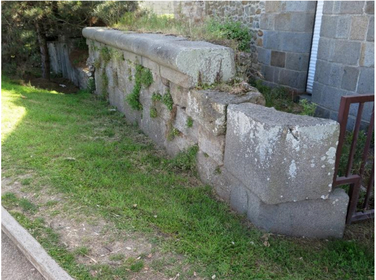
Vue des vestiges de l'escarpe à l'est, le long du rond-point du Naye (état en 2015). En arrière-plan à droite, le bâtiment des Douanes
