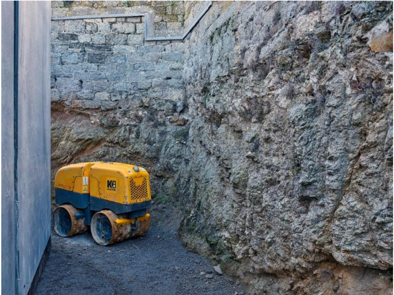
Vue de détail de l'intérieur de l'escarpe (couverture photographique du 22 janvier 2026). A gauche, le chantier de la gare maritime du Naye
