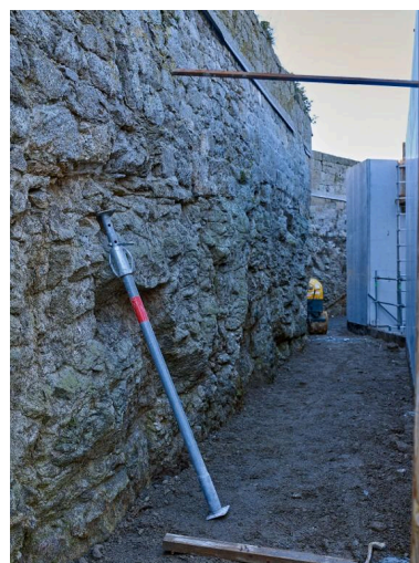
Vue de détail de l'intérieur de l'escarpe (couverture photographique du 22 janvier 2026). A droite, le chantier de la gare maritime du Naye Phot. Bernard Bègne IVR53_20263500123NUCA
