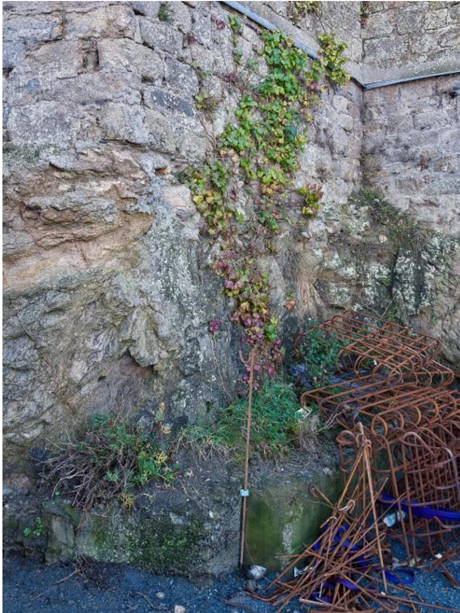
Vue de détail de l'intérieur de l'escarpe (couverture photographique du 22 janvier 2026). Au premier plan, le chantier de la gare maritime du Naye
