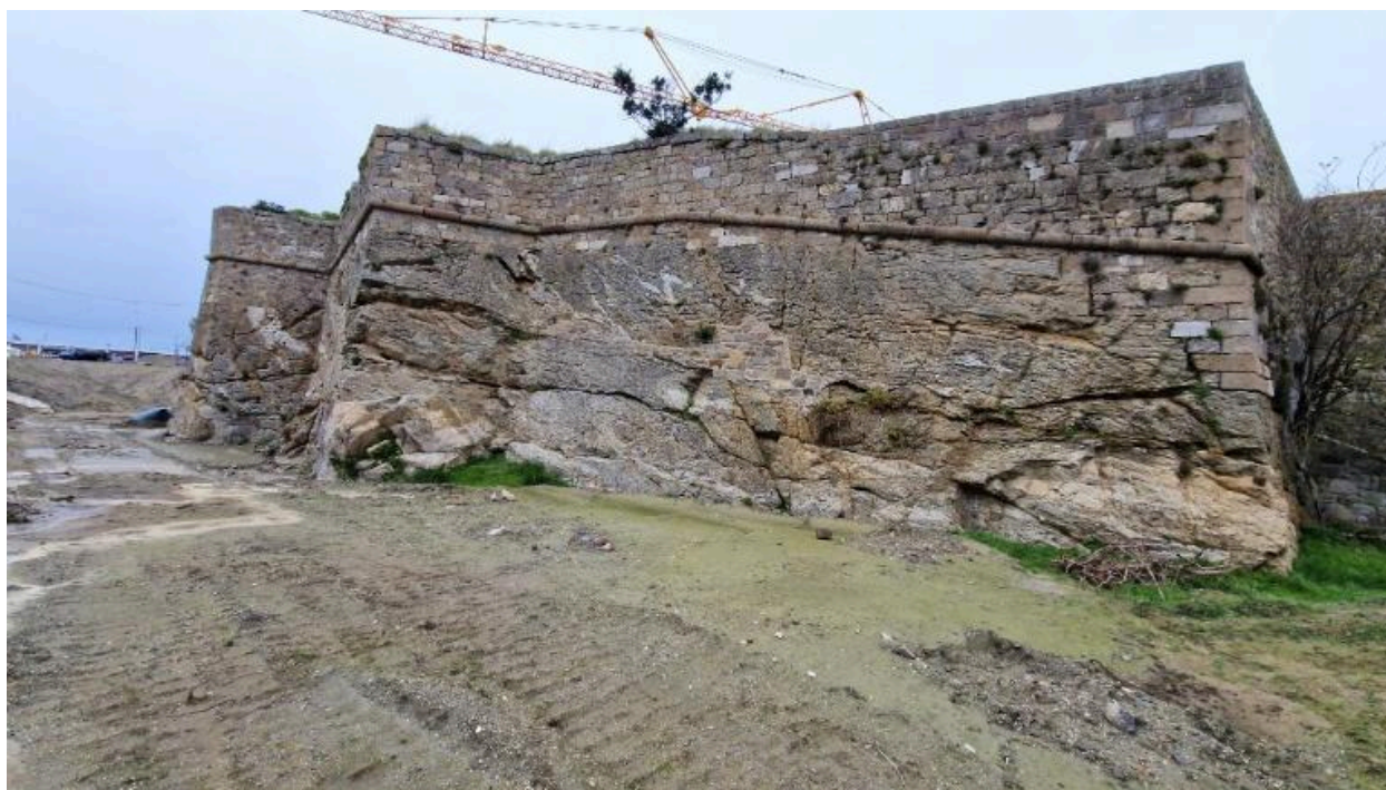
Vue générale depuis le sud-sud-est (couverture photographique du 17 décembre 2025)
