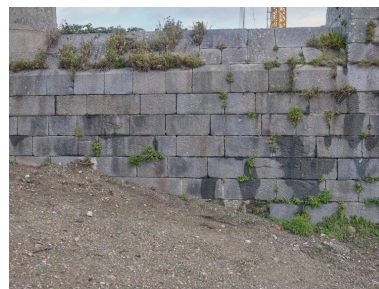
Vue de détail de la maçonnerie en pierre de taille de granite de la digue du fossé (couverture photographique du 22 janvier 2026) Phot. Bernard Bègne IVR53_20263500128NUCA
