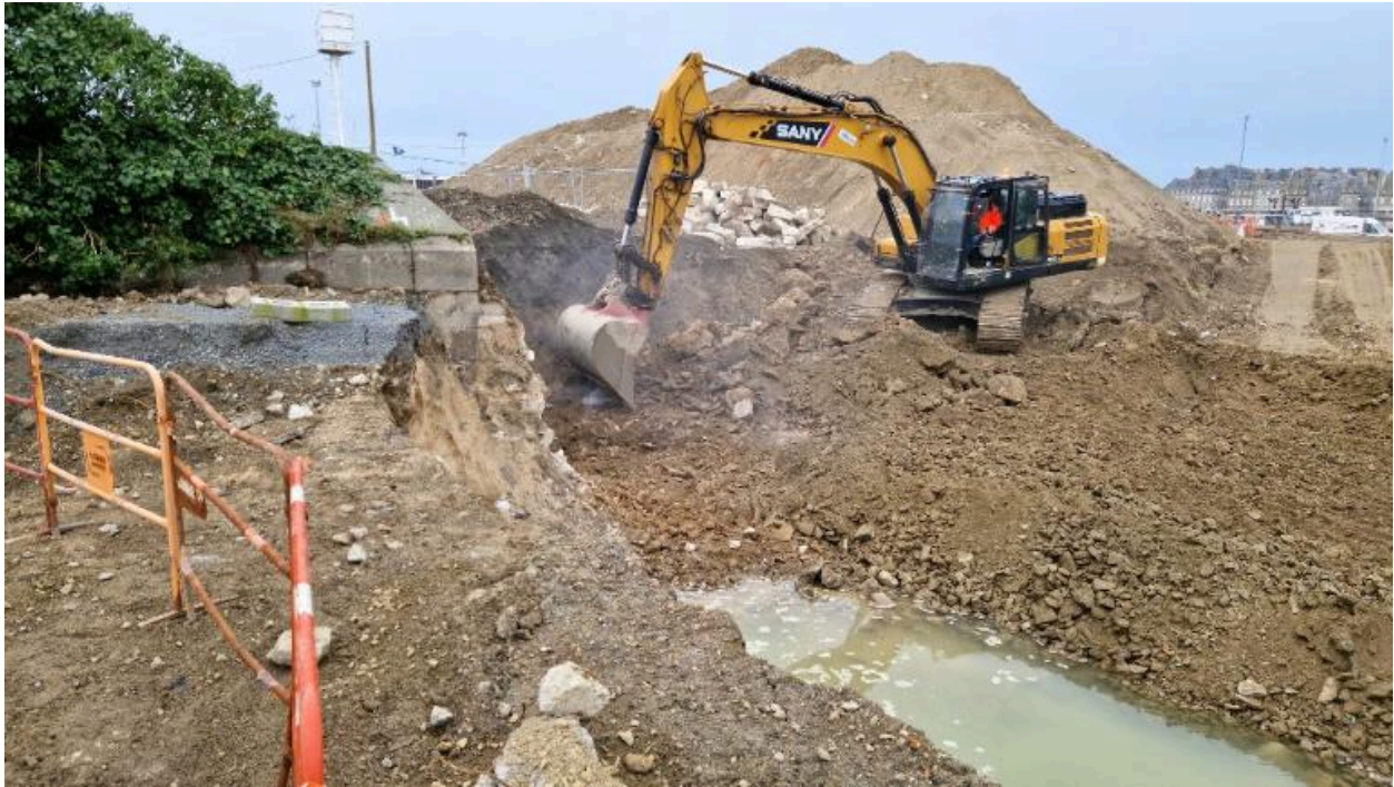
Vue de l'excavation réalisée dans l'alignement nord de la digue du fossé (couverture photographique du 17 décembre 2025)
