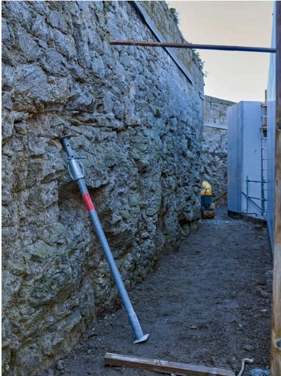
Vue de détail de l'intérieur de l'escarpe (couverture photographique du 22 janvier 2026). A droite, le chantier de la gare maritime du Naye
