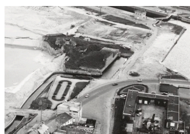
Vue aérienne oblique du fort du Naye depuis le sud-est, 14 juin 1971 Autr. Créations Artistiques Heurtier, Repro. Musée de Bretagne IVR53_20263510045NUC
