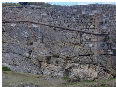
Vue générale depuis l'ouest-sud-ouest (couverture photographique du 22 janvier 2026). Fondée sur le rocher, cette partie du fort est montée en maçonnerie de pierre de taille Phot. Bernard Bègne IVR53_20263500130NUCA
