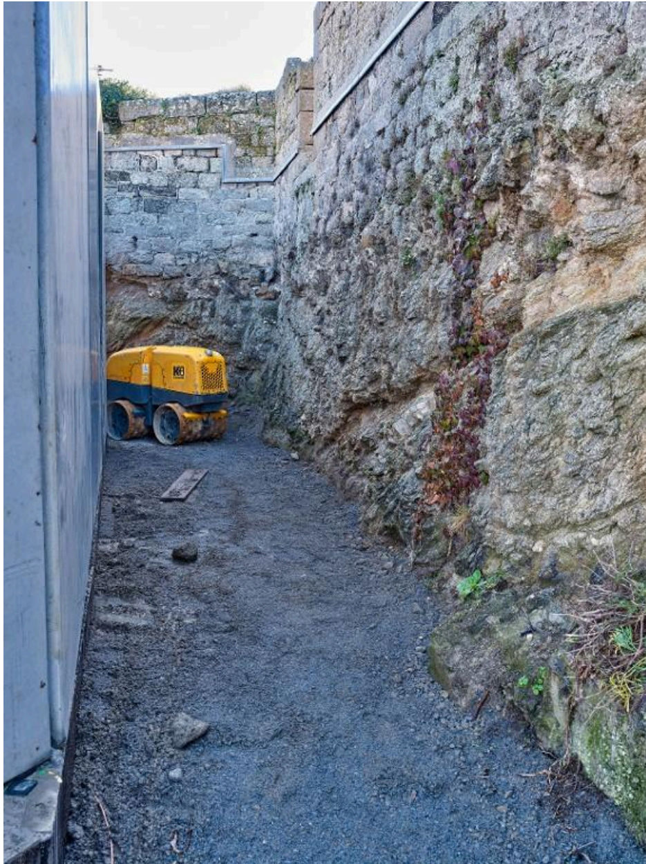
Vue de détail de l'intérieur de l'escarpe (couverture photographique du 22 janvier 2026). A gauche, le chantier de la gare maritime du Naye
