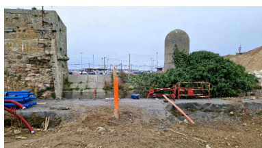
Vue de la digue et de la dame du fossé depuis l'est (couverture photographique du 17 décembre 2025). Cette partie du fort est montée en maçonnerie de pierre de taille de granite
