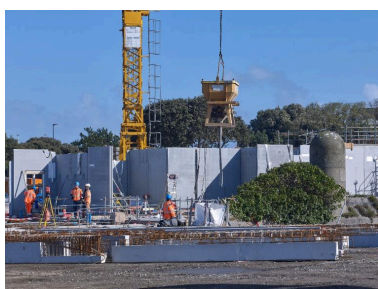
Vue du chantier du terre-plein du Naye (couverture photographique du 11 mars 2026). A droite, la dame du fort du Naye Phot. Bernard Bègne IVR53_20263500565NUCA
