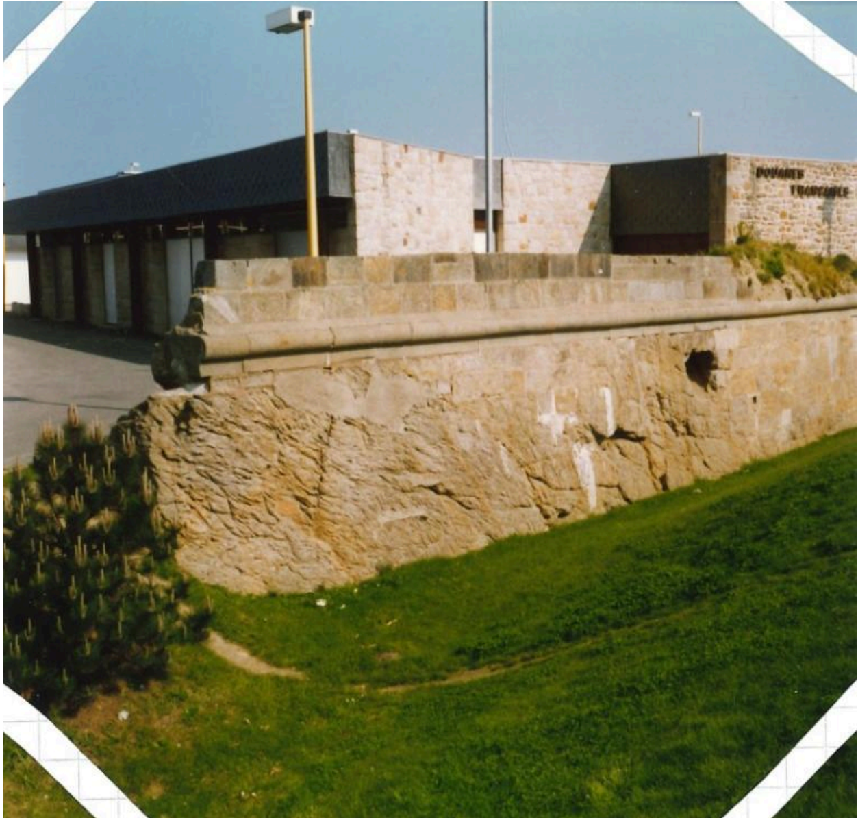
Vue générale depuis l'est : escarpe sud-est, mai 1991
