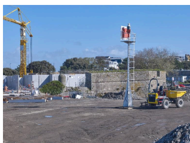
Vue du chantier du terre-plein du Naye (couverture photographique du 11 mars 2026). Au premier plan, un feu de signalisation du port. En arrière-plan, le fort du Naye Phot. Bernard Bègne IVR53_20263500563NUCA
