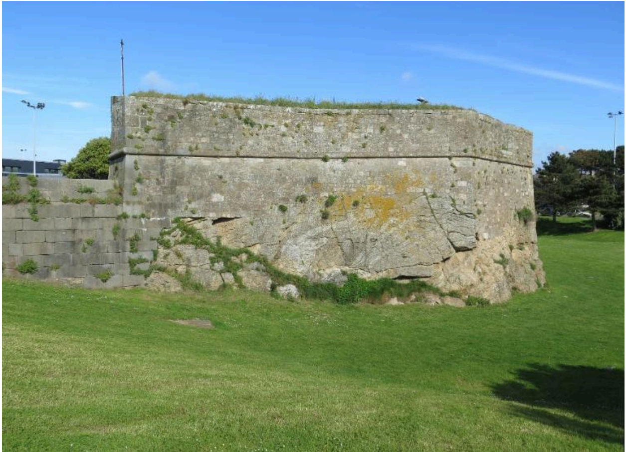
Vue de détail de l'escarpe ouest (état en 2015). Fondée sur le rocher, cette partie du fort est montée en maçonnerie de moellon et en pierre de taille
