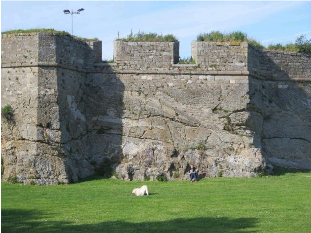
Vue de détail depuis le sud-ouest (état en 2015). Fondée sur le rocher, cette partie du fort est montée en maçonnerie de moellon et en pierre de taille. Son parapet est percé de trois embrasures
