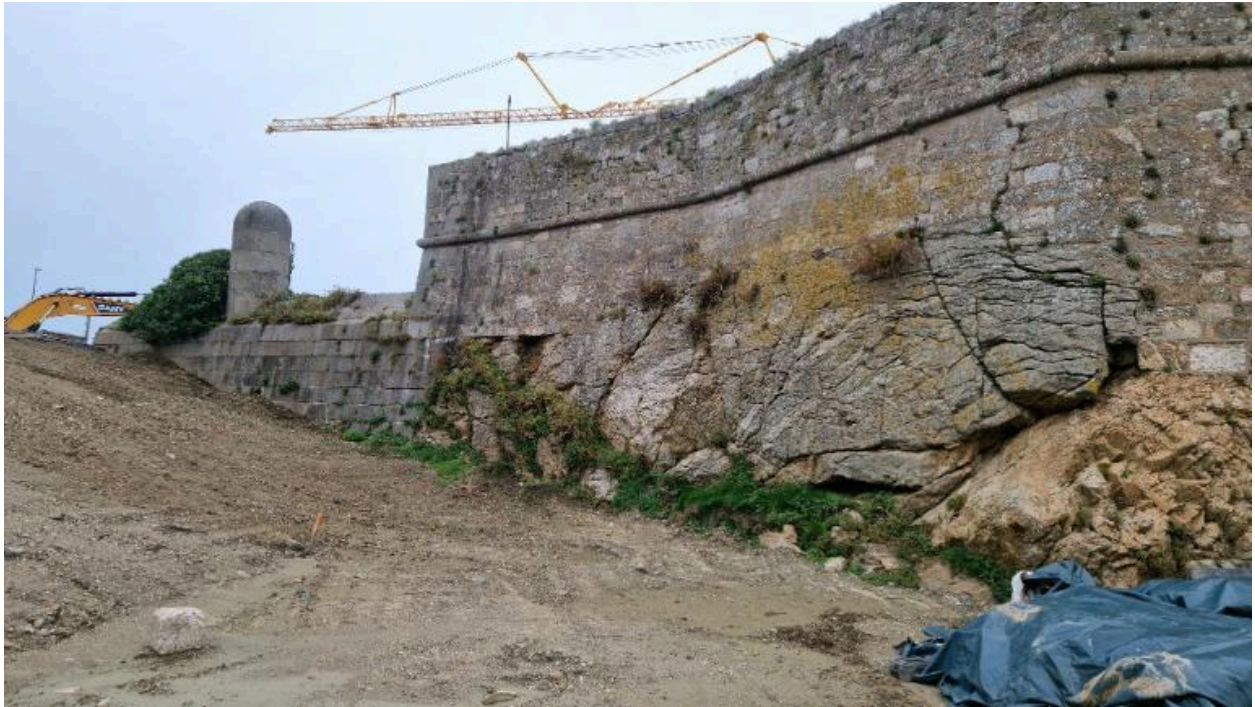
Vue de l'escarpe ouest et de la digue du fossé du fort (couverture photographique du 17 décembre 2025)
