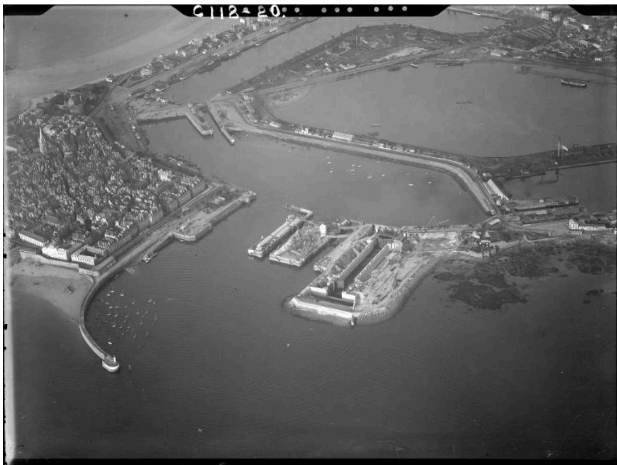
Vue aérienne oblique depuis l'ouest-sud-ouest montrant le chantier de construction de la grande écluse du Naye, 27 septembre 1929
