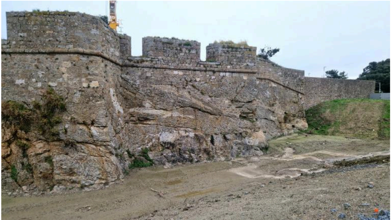
Vue générale depuis le sud-ouest (couverture photographique du 17 décembre 2025)
