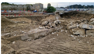
Vue de situation depuis le nord (couverture photographique du 17 décembre 2025). Au premier plan, les vestiges du quai de l'avant-port de Saint-Servan. Il est construit en maçonnerie de pierre de taille de granite Phot. Guillaume Lécueillier IVR53_20263510075NUCA
