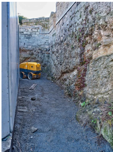
Vue de détail de l'intérieur de l'escarpe (couverture photographique du 22 janvier 2026). A gauche, le chantier de la gare maritime du Naye Phot. Bernard Bègne IVR53_20263500119NUCA
