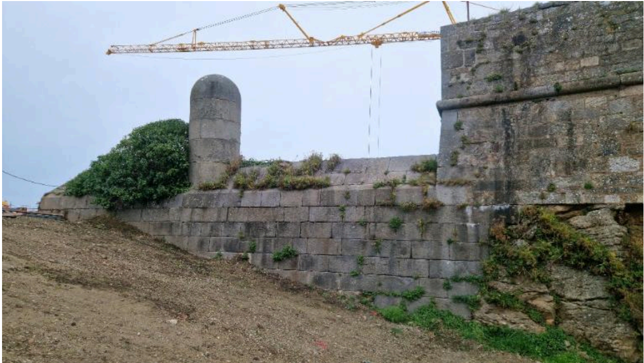
Vue de la digue et de la dame du fossé du fort depuis l'ouest-sud-ouest (couverture photographique du 17 décembre 2025). Cette partie du fort est montée en maçonnerie de pierre de taille de granite
