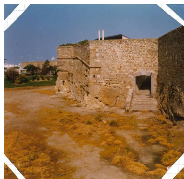
Vue générale depuis l'est-sud-est, mai 1991 Repro. Archives municipales de Saint-Malo, Repro. Marc Jean, Phot. Louis Pottier IVR53_20263510217NUCA
