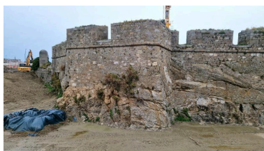
Vue générale depuis le sud-ouest (couverture photographique du 17 décembre 2025) Phot. Guillaume Lécueillier IVR53_20263510077NUCA
