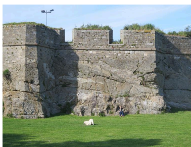
Vue de détail depuis le sud-ouest (état en 2015). Fondée sur le rocher, cette partie du fort est montée en maçonnerie de moellon et en pierre de taille. Son parapet est percé de trois embrasures Phot. Guillaume Lécueillier IVR53_20263510029NUCA
