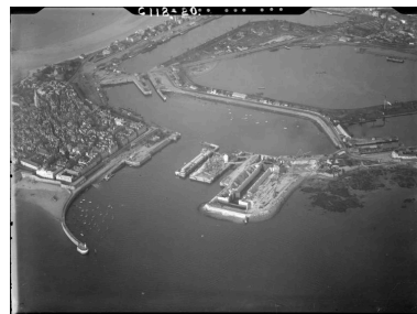
Vue aérienne oblique depuis l'ouest-sud-ouest montrant le chantier de construction de la grande écluse du Naye, 27 septembre 1929 Repro. Institut national de l'information géographique et forestière, Autr. Auteur inconnu IVR53_20263510114NUC
