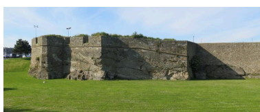
Vue générale depuis le sud (état en 2015). Fondée sur le rocher, cette partie du fort est montée en maçonnerie de moellon et en pierre de taille. Son parapet est percé de trois embrasures. A droite, le mur a été remonté Phot. Guillaume Lécueillier IVR53_20263510030NUCA
