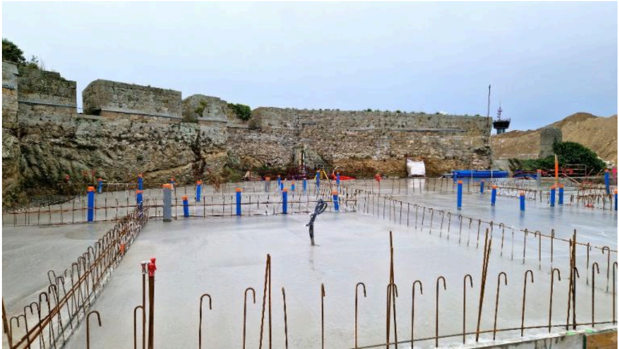
Vue de l'escarpe depuis l'est-nord-est (couverture photographique du 17 décembre 2025). Au premier plan, la future gare maritime
