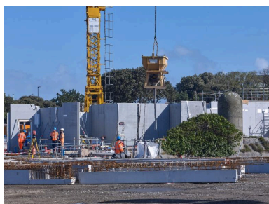
Vue du chantier du terre-plein du Naye (couverture photographique du 11 mars 2026). A droite, la dame du fort du Naye Phot. Bernard Bègne IVR53_20263500565NUCA
