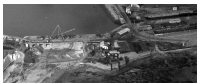
Vue aérienne oblique depuis l'ouest-sud-ouest montrant le chantier de construction de la grande écluse du Naye, 27 septembre 1929. Sur la photographie, on voit notamment l'avant-port de Saint-Servan en cours de remblaiement et le fort du Naye Repro. Institut national de l'information géographique et forestière, Autr. Auteur inconnu IVR53_20263510116NUC
