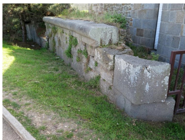
Vue des vestiges de l'escarpe à l'est, le long du rond-point du Naye (état en 2015). En arrière-plan à droite, le bâtiment des Douanes Phot. Guillaume Lécueillier IVR53_20263510033NUCA
