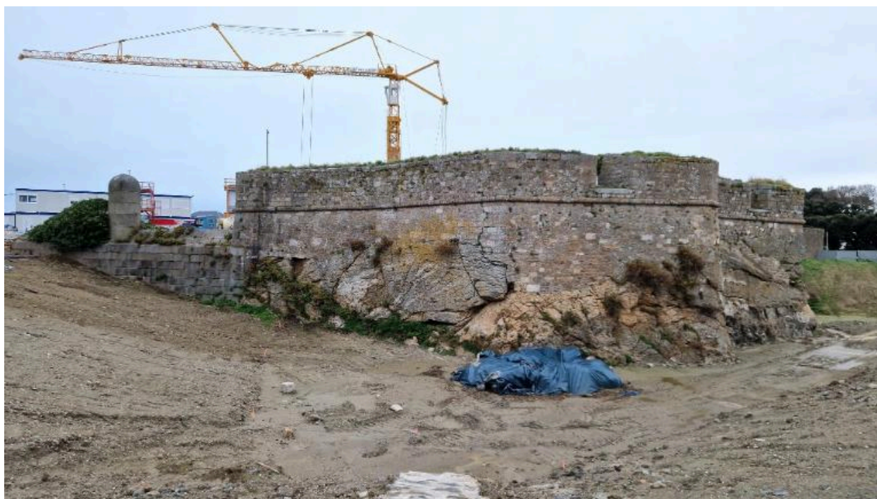
Vue générale depuis l'ouest-sud-ouest (couverture photographique du 17 décembre 2025)
