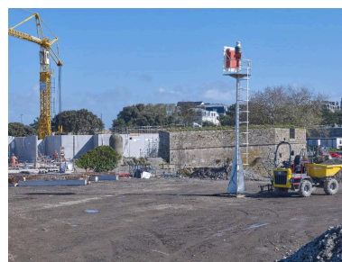
Vue du chantier du terre-plein du Naye (couverture photographique du 11 mars 2026). Au premier plan, un feu de signalisation du port. En arrière-plan, le fort du Naye Phot. Bernard Bègne IVR53_20263500563NUCA
