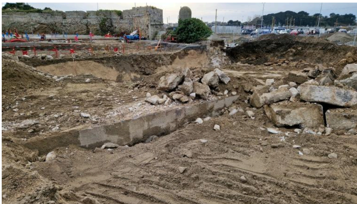
Vue de situation depuis le nord (couverture photographique du 17 décembre 2025). Au premier plan, les vestiges du quai de l'avant-port de Saint-Servan. Il est construit en maçonnerie de pierre de taille de granite
