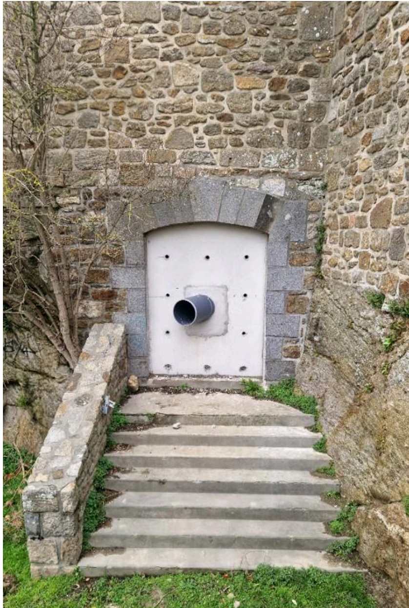
Vue de la porte en arc surbaissé aménagée dans le flanc de l'escarpe (couverture photographique du 17 décembre 2025). Cette partie du fort a été remontée comme l'atteste la mise en oeuvre de la maçonnerie
