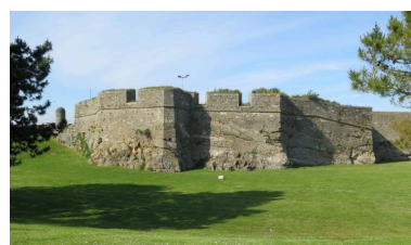
Vue générale depuis le sud- ouest (état en 2015). Fondée sur le rocher, cette partie du fort est montée en maçonnerie de moellon et en pierre de taille. Son parapet est percé de trois embrasures Phot. Guillaume Lécueillier IVR53_20263510028NUCA
