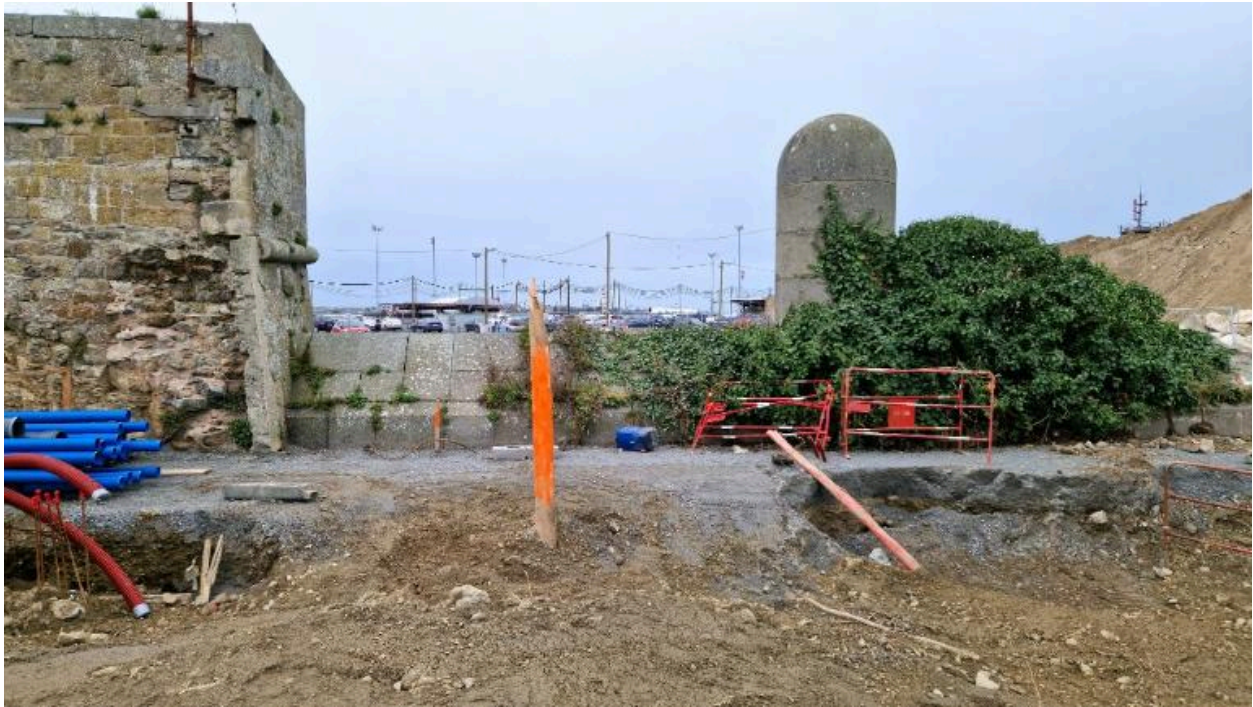
Vue de la digue et de la dame du fossé depuis l'est (couverture photographique du 17 décembre 2025). Cette partie du fort est montée en maçonnerie de pierre de taille de granite
