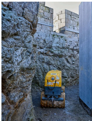
Vue de détail de l'intérieur de l'escarpe (couverture photographique du 22 janvier 2026). A droite, le chantier de la gare maritime du Naye Phot. Bernard Bègne IVR53_20263500124NUCA
