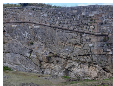
Vue générale depuis l'ouest-sud-ouest (couverture photographique du 22 janvier 2026). Fondée sur le rocher, cette partie du fort est montée en maçonnerie de pierre de taille Phot. Bernard Bègne IVR53_20263500130NUCA
