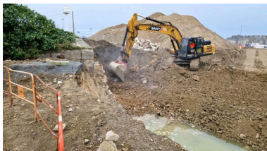
Vue de l'excavation réalisée dans l'alignement nord de la digue du fossé (couverture photographique du 17 décembre 2025) Phot. Guillaume Lécueillier IVR53_20263510090NUCA
