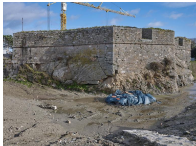
Vue générale depuis l'ouest (couverture photographique du 22 janvier 2026). Fondée sur le rocher, cette partie du fort est montée en maçonnerie de moellon et en pierre de taille. Son parapet est percé de trois embrasures Phot. Bernard Bègne IVR53_20263500125NUCA
