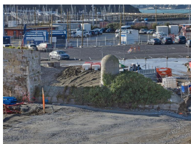
Vue depuis le nord-est : batardeau et dame du fossé (couverture photographique du 22 janvier 2026) Phot. Bernard Bègne IVR53_20263500114NUCA
