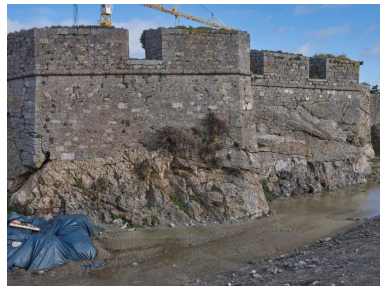
Vue générale depuis le sud-ouest (couverture photographique du 22 janvier 2026). Fondée sur le rocher, cette partie du fort est montée en maçonnerie de moellon et en pierre de taille. Son parapet est percé de trois embrasures Phot. Bernard Bègne IVR53_20263500126NUCA
