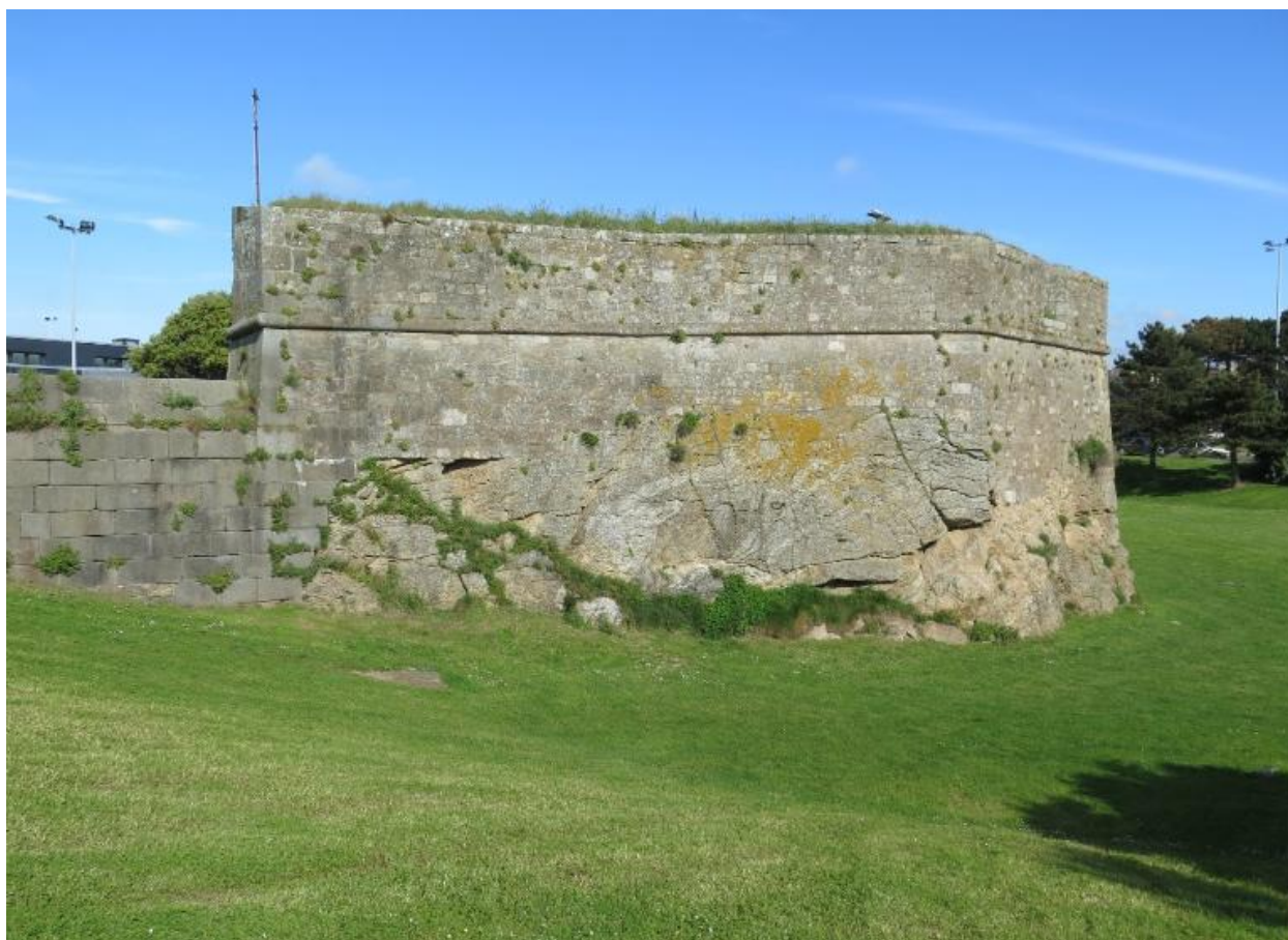
Vue de détail de l'escarpe ouest (état en 2015). Fondée sur le rocher, cette partie du fort est montée en maçonnerie de moellon et en pierre de taille
