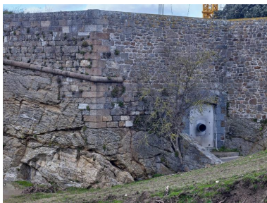
Vue générale depuis le sud-est (couverture photographique du 22 janvier 2026). A droite : porte en arc surbaissé aménagée dans le flanc de l'escarpe ; cette partie du fort a été remontée comme l'atteste la mise en oeuvre de la maçonnerie
