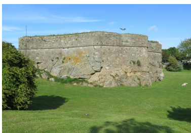
Vue générale depuis l'ouest (état en 2015). Fondée sur le rocher, cette partie du fort est montée en maçonnerie de moellon et
