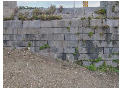
Vue de détail de la maçonnerie en pierre de taille de granite du batardeau du fossé (couverture photographique du 22 janvier 2026) Phot. Bernard Bègne IVR53_20263500128NUCA
