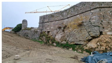
Vue de l'escarpe ouest et du batardeau du fossé du fort (couverture photographique du 17 décembre 2025) Phot. Guillaume Lécueillier IVR53_20263510083NUCA
