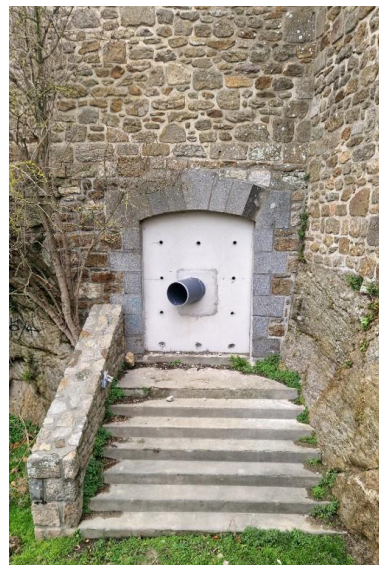
Vue de la porte en arc surbaissé aménagée dans le flanc de l'escarpe (couverture photographique du 17 décembre 2025). Cette partie du fort a été remontée comme l'atteste la mise en oeuvre de la maçonnerie Phot. Guillaume Lécueillier IVR53_20263510081NUCA
