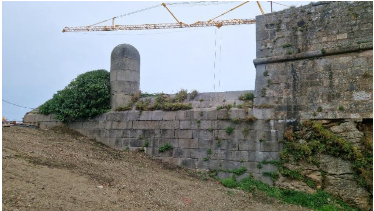
Vue du batardeau et de la dame du fossé du fort depuis l'ouest-sud-ouest (couverture photographique du 17 décembre 2025). Cette partie du fort est montée en maçonnerie de pierre de taille de granite
