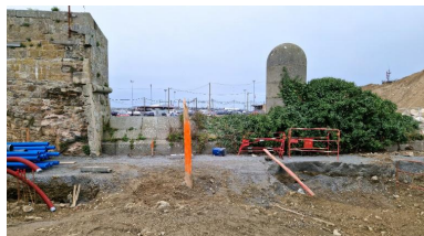
Vue du batardeau et de la dame du fossé depuis l'est (couverture photographique du 17 décembre 2025). Cette partie du fort est montée en maçonnerie de pierre de taille de granite Phot. Guillaume Lécueillier IVR53_20263510089NUCA
