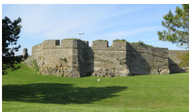
Vue générale depuis le sud-ouest (état en 2015). Fondée sur le rocher, cette partie du fort est montée en maçonnerie de moellon
