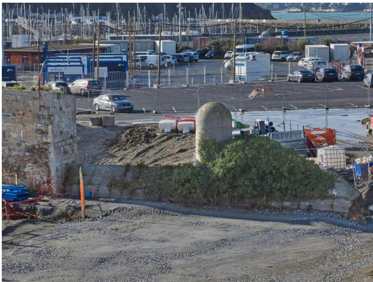
Vue depuis le nord-est : batardeau et dame du fossé (couverture photographique du 22 janvier 2026)
