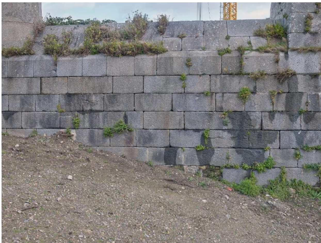
Vue de détail de la maçonnerie en pierre de taille de granite du batardeau du fossé (couverture photographique du 22 janvier 2026)
