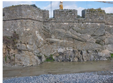
Vue générale depuis le sud-ouest (couverture photographique du 22 janvier 2026). Fondée sur le rocher, cette partie du fort est montée en maçonnerie de moellon et en pierre de taille. Son parapet est percé de trois embrasures Phot. Bernard Bègne IVR53_20263500127NUCA
