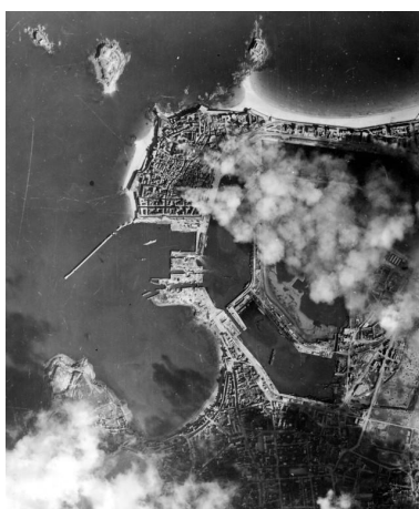
Vue aérienne verticale de Saint- Malo, 13 août 1944 (?). On peut observer le résultat de la destruction du port par l'occupant dans la nuit du 7 au 8 août (collection : Institut national de l'information géographique et forestière ?) Phot. Auteur inconnu IVR53_20263510105NUC
