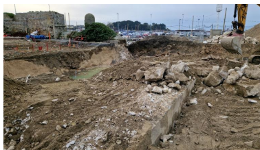
Vue de situation depuis le nord- est (couverture photographique du 17 décembre 2025). Au premier plan, les vestiges du quai de l'avant-port de Saint-Servan. Il est construit en maçonnerie de pierre de taille de granite Phot. Guillaume Lécueillier IVR53_20263510073NUCA
