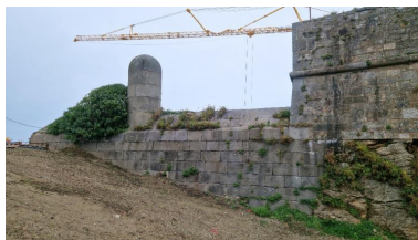
Vue du batardeau et de la dame du fossé du fort depuis l'ouest-sud-ouest (couverture photographique du 17 décembre 2025). Cette partie du fort est montée en maçonnerie de pierre de taille de granite Phot. Guillaume Lécueillier IVR53_20263510084NUCA
