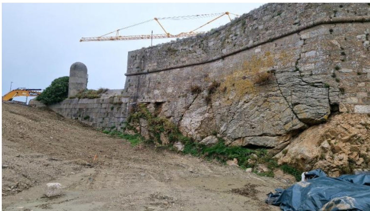
Vue de l'escarpe ouest et du batardeau du fossé du fort (couverture photographique du 17 décembre 2025)
