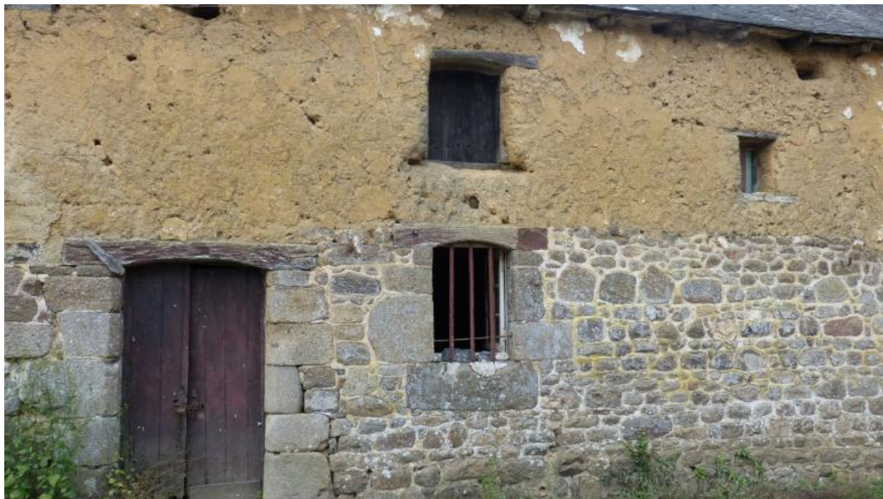
Détail de la façade est
