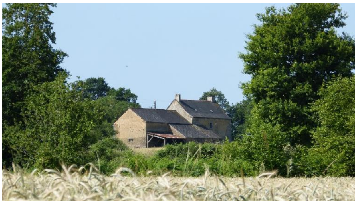
Vue d'ensemble nord est
