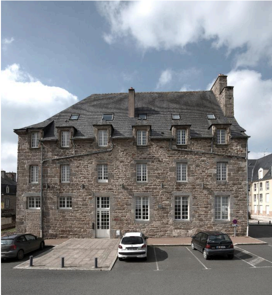
Vue de la façade est du bâtiment
