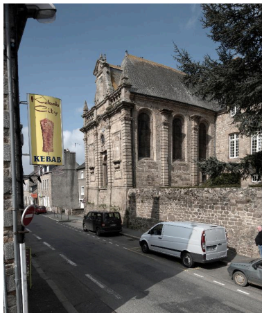
Vue sud-est de la chapelle des Ursulines Phot. Bernard Bègne IVR53_20162200137NUCA
