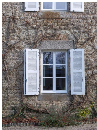
Façade ouest. Détail d'une fenêtre et de son arc de décharge en brique Phot. Bernard Bègne IVR53_20243501465NUCA
