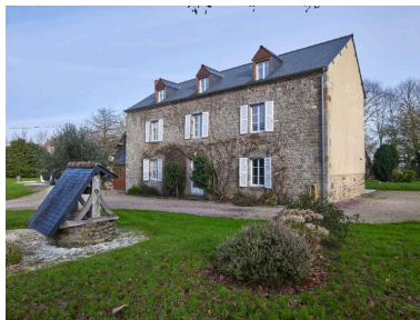
Vue générale sud-ouest Phot. Bernard Bègne IVR53_20243501463NUCA
