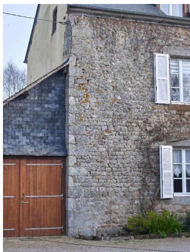
Façade ouest. Détail du chaînage d'angle avec changement de mise en oeuvre lié à la surélévation du mur Phot. Bernard Bègne IVR53_20243501466NUCA
