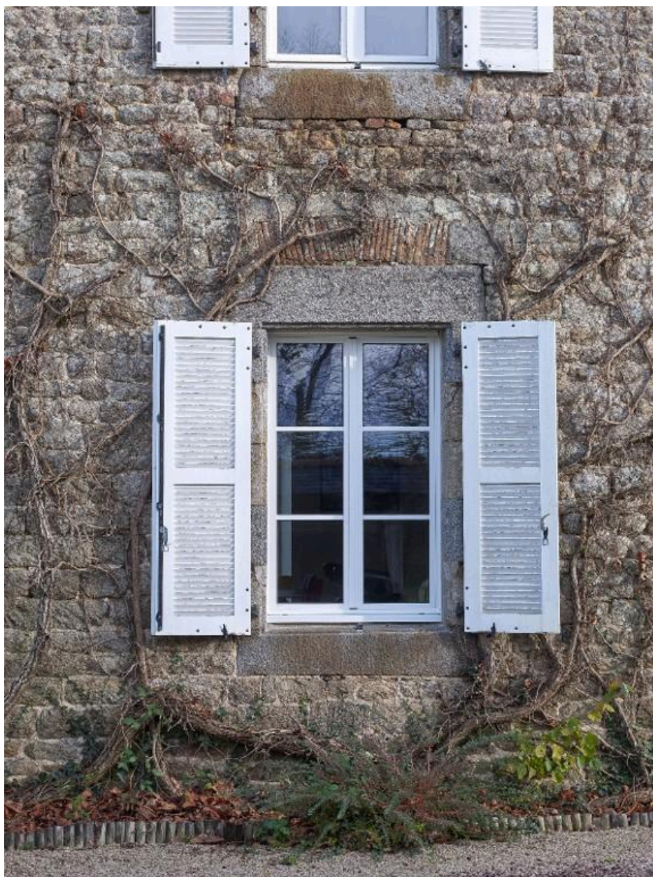
Façade ouest. Détail d'une fenêtre et de son arc de décharge en brique
