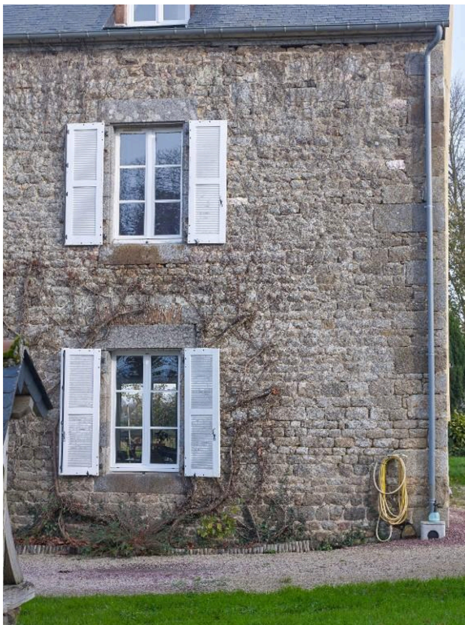
Façade ouest. Travée de fenêtres
