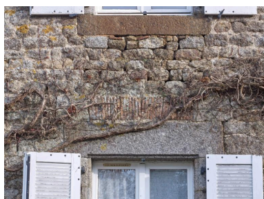
Façade ouest. Détail de l'arc de décharge en brique d'une fenêtre Phot. Bernard Bègne IVR53_20243501464NUCA
