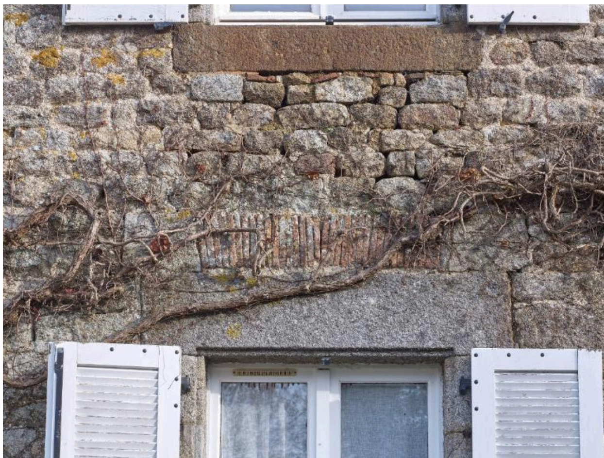
Façade ouest. Détail de l'arc de décharge en brique d'une fenêtre
