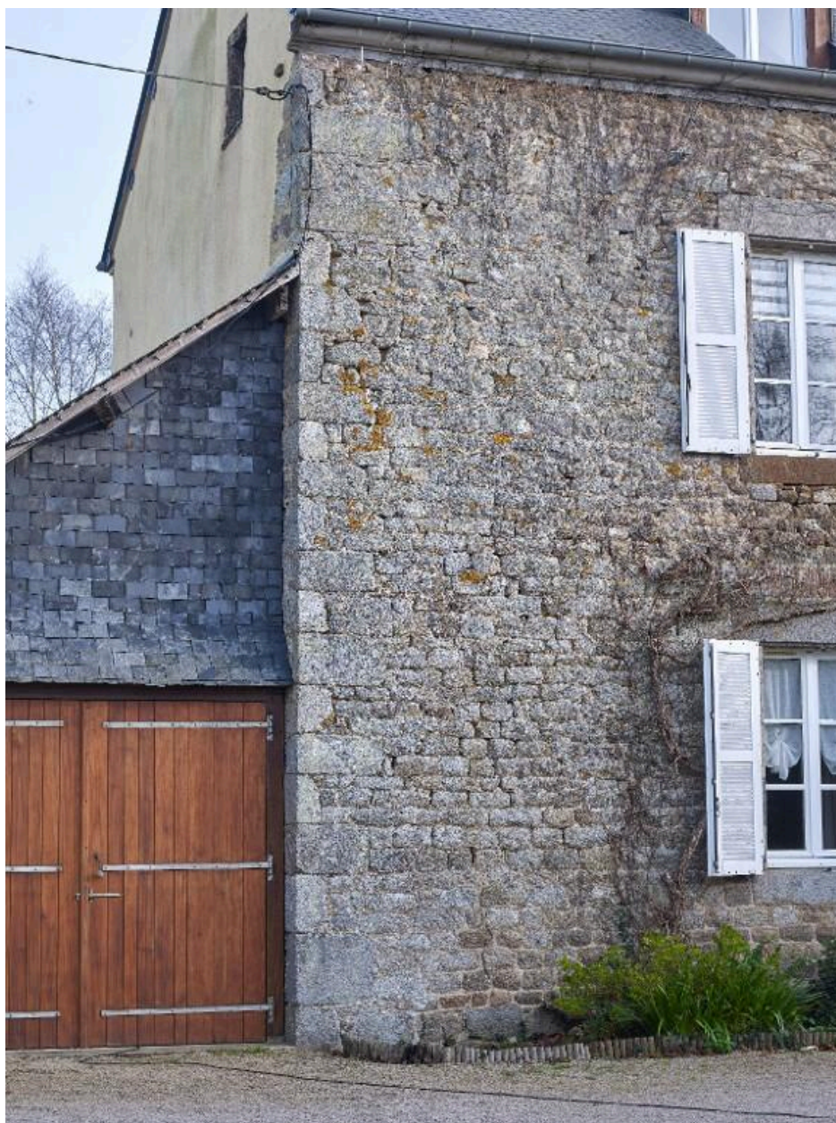
Façade ouest. Détail du chaînage d'angle avec changement de mise en oeuvre lié à la surélévation du mur
