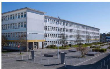
Externat du lycée Jules Lesven (bâtiment P), façades ouest (vue partielle) et sud (vue d'ensemble). J-B. Mathon, architecte. Phot. Bernard Bègne IVR53_20212900047NUCA
