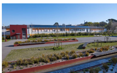
La cour prise du sud (noter le traitement paysager) et la façade sud du bâtiment V, ancienne école nationale d'ingénieurs, (Péron et Weisbein, architectes, 1961). Noter la création d'un édicule pour la mise aux normes d'accessibilité (Atelier Rubin, architectes, vers 2016). Phot. Bernard Bègne IVR53_20212900055NUCA
