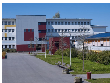
Externer et administration du lycée Jules Lesven (bâtiment P), façade est de l'aile ouest. J-B. Mathon, architecte. Détail sur la restructuration et mise aux normes d'accessibilité, 2020. A droite, bâtiment V, ancienne école nationale d'ingénieurs, façade sud (Péron et Weisbein, architectes, 1961). Phot. Bernard Bègne IVR53_20212900052NUCA
