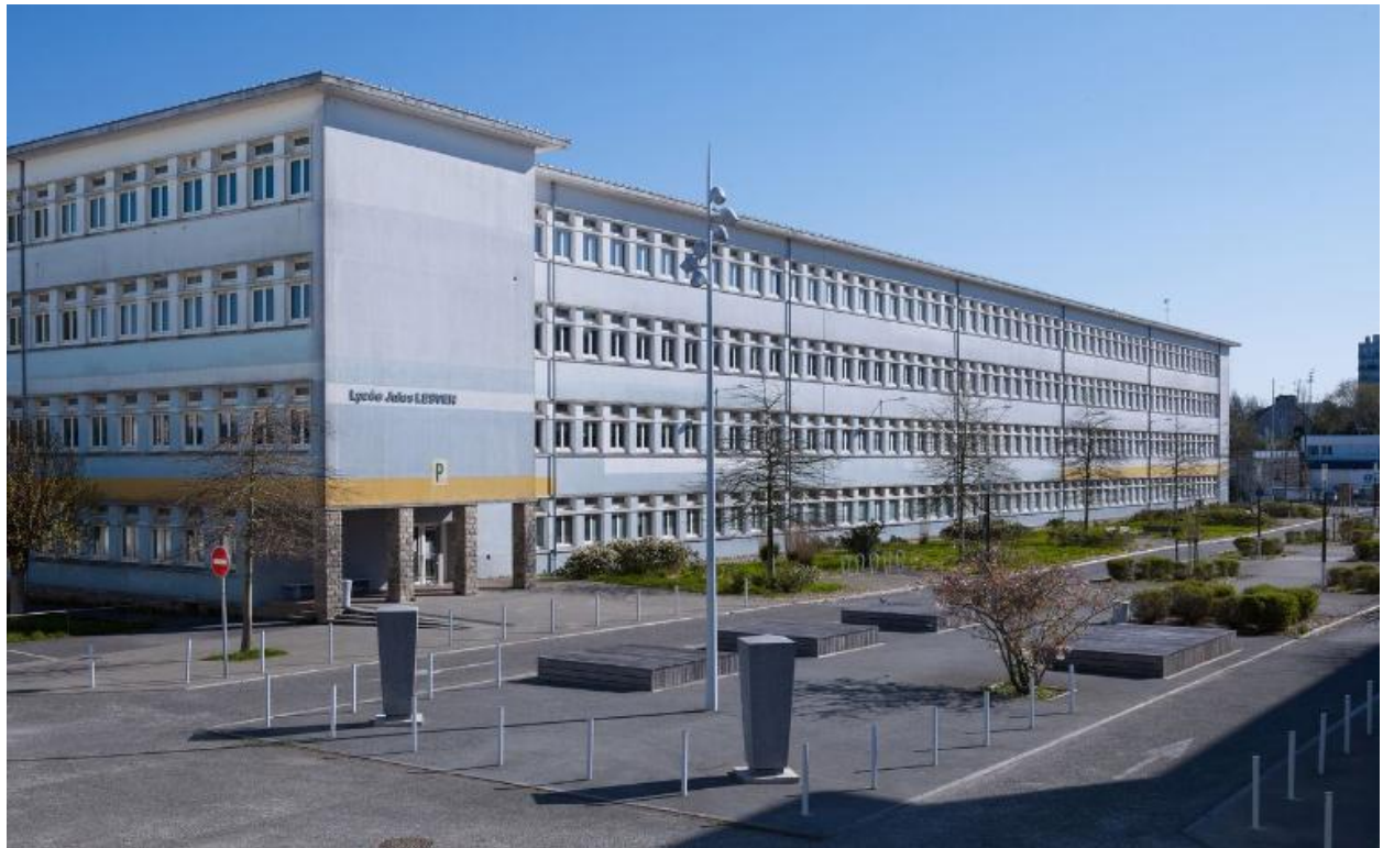
Externat du lycée Jules Lesven (bâtiment P), façades ouest (vue partielle) et sud (vue d'ensemble). J-B. Mathon, architecte.
