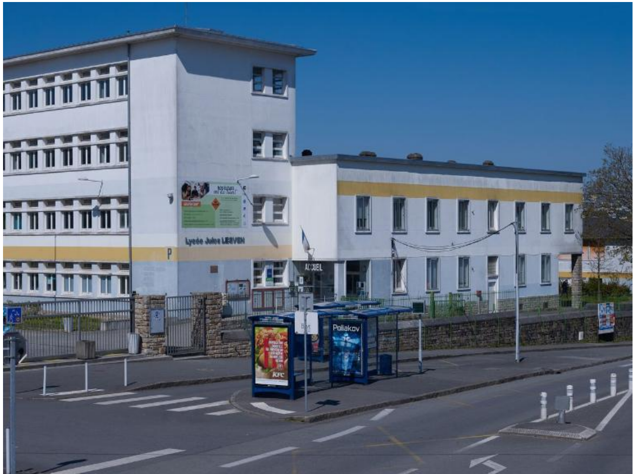
Externat et administration du lycée Jules Lesven (bâtiment P), angle sud-est, accueil. J-B. Mathon, architecte.
