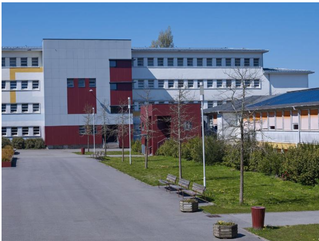
Externat et administration du lycée Jules Lesven (bâtiment P), façade est de l'aile ouest. J-B. Mathon, architecte. Détail sur la restructuration et mise aux normes d'accessibilité, 2020. A droite, bâtiment V, ancienne école nationale d'ingénieurs, façade sud (Péron et Weisbein, architectes, 1961).
