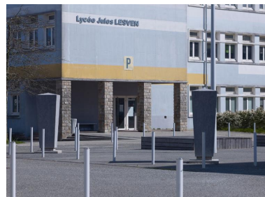
Externat du lycée Jules Lesven (bâtiment P), entrée sud- ouest. J-B. Mathon, architecte. Phot. Bernard Bègne IVR53_20212900048NUCA
