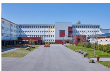
Vue d'ensemble de la cour prise de l'est. A gauche et au fond, les externats et ateliers (J-B. Mathon, architecte, 1963). Un foyer des élèves et une galerie couverte ont été ajoutés en 2016 (Atelier Rubin, architectes). Les bâtiments ont été mis aux normes d'accessibilité par l'adjonction d'ouvrages hors œuvre en façade. Phot. Bernard Bègne IVR53_20212900053NUCA
