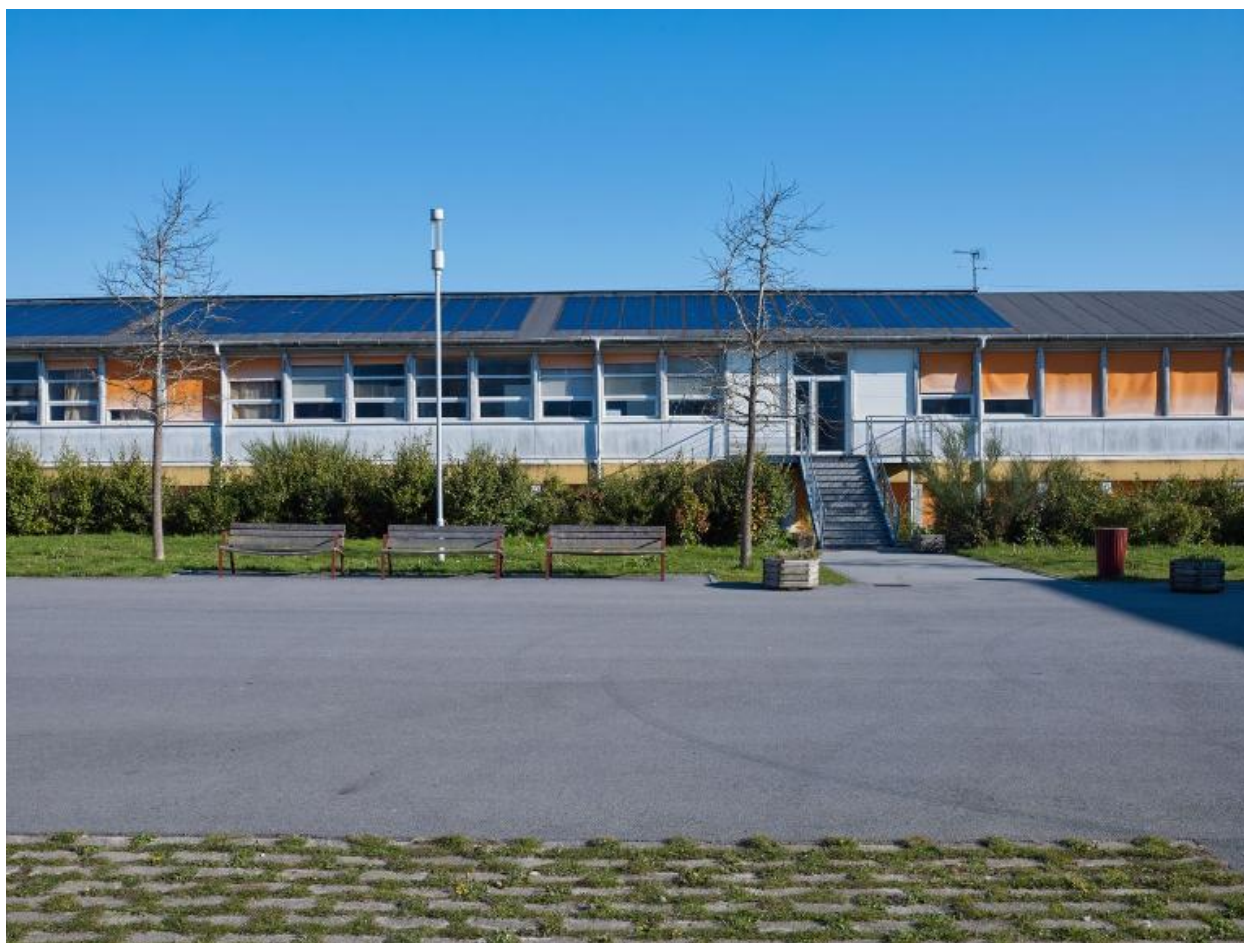
Façade sud du bâtiment V, ancienne école nationale d'ingénieurs, (Péron et Weisbein, architectes, 1961).
