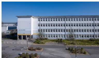
Externat du lycée Jules Lesven (bâtiment P), façade sud, vue partielle (J-B. Mathon, architecte). A gauche, à l'arrière plan, l'un des deux gymnases de type A (entreprise Tible, constructeur). Phot. Bernard Bègne IVR53_20212900046NUCA
