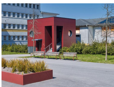
Edicule devant la façade sud du bâtiment V : une mise aux normes d'accessibilité soignée. Atelier Rubin, architectes, vers 2016. Phot. Bernard Bègne IVR53_20212900056NUCA
