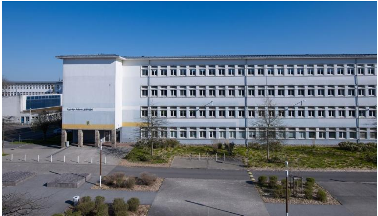
Externat du lycée Jules Lesven (bâtiment P), façade sud, vue partielle (J-B. Mathon, architecte). A gauche, à l'arrière plan, l'un des deux gymnases de type A (entreprise Tible, constructeur).
