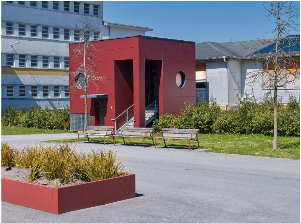
Edicule devant la façade sud du bâtiment V : une mise aux normes d'accessibilité soignée. Atelier Rubin, architectes, vers 2016.
