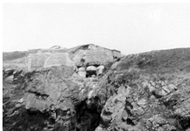
Vue de situation, vers 1946 (photographie extraite du rapport Pinczon du Sel) Phot. Guillaume Lécueillier IVR53_20032901807NUCA
