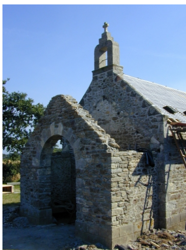
Le porche en cours de restauration : vue générale sud-ouest Phot. Xavier Gilbert IVR53_20003509507NUCA
