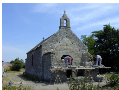
Vue générale nord-ouest Phot. Xavier Gilbert IVR53_20003509506NUCA
