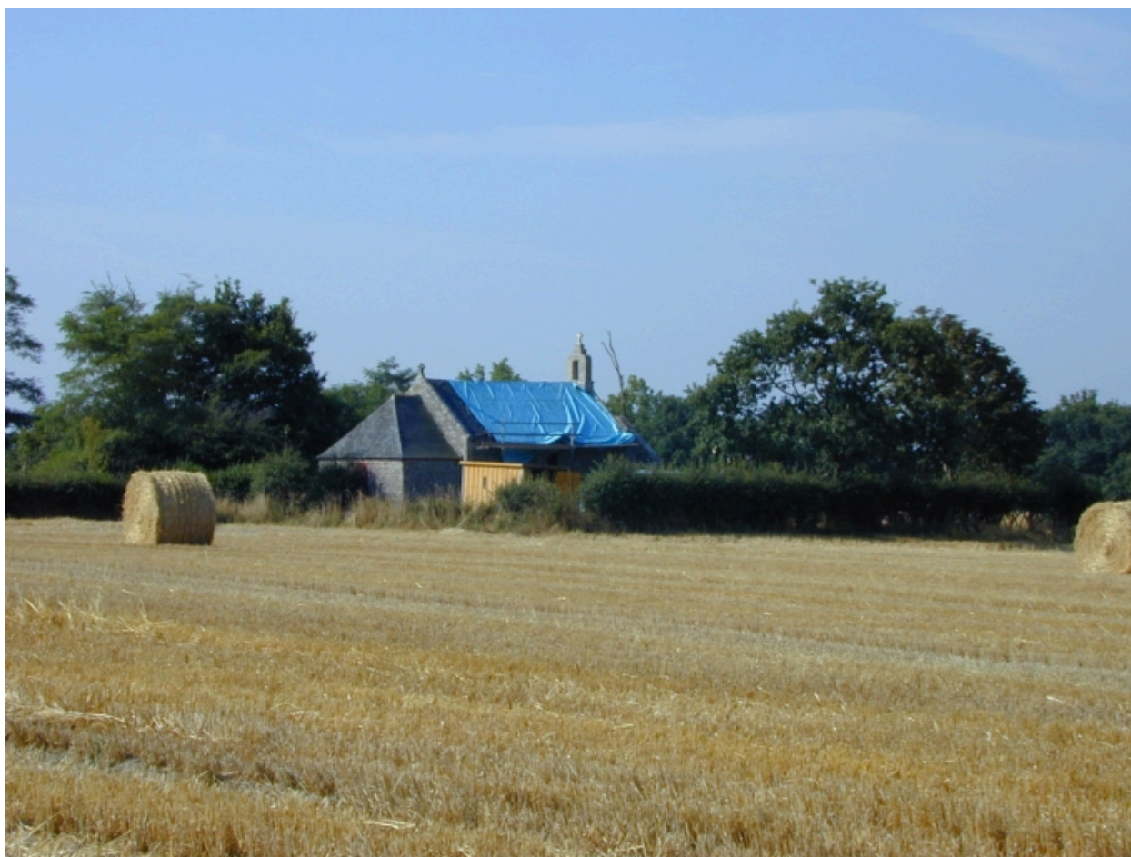
Vue de situation nord-est
