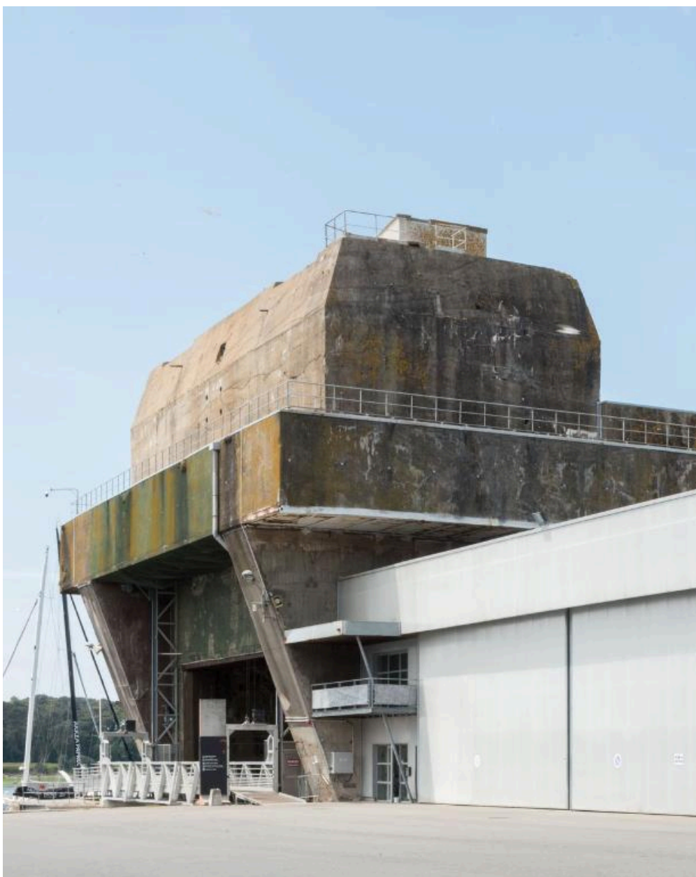
Vue du bunker KI avec l'entrée du slipway : sur la dalle de couverture, le bunker - cuves pour deux canons antiaériens. A droite, le hangar H1
