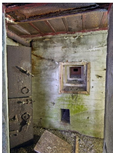
Vue intérieure : créneau de défense situé dans l'axe de l'entrée ouest ; il a conservé son bois
