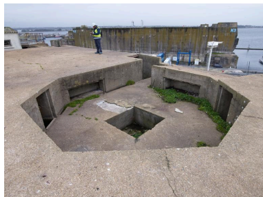
Vue de la cuve ouest pour canon. Au centre, l'emplacement pour le canon ; autour, niches à munition et petits abris pour les soldats.
