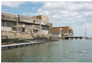
Vue du bunker KI depuis l'ouest : sur la dalle de couverture, le bunker - cuves pour deux canons antiaériens. A l'arrière-plan, le bunker KIII et les pontons Phot. Charlotte Barraud IVR53_20215600612NUCA
