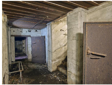
Vue intérieure : sas d'entrée ; les pièces de vie - chambrées sont chacune dotées d'une porte étanche. Entre les deux portes, l'escalier desservant les deux cuves pour canon Phot. Bernard Bègne IVR53_20235600221NUCA
