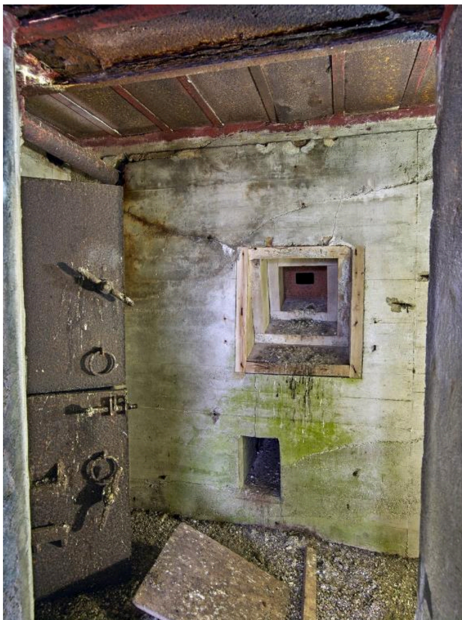
Vue intérieure : créneau de défense situé dans l'axe de l'entrée ouest ; il a conservé son bois de coffrage. A gauche, porte blindée à deux vantaux du sas
