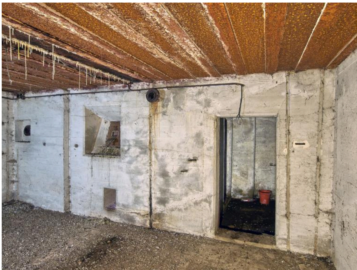
Vue intérieure : pièce de vie - chambre ouest avec son unique porte
