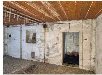
Vue intérieure : pièce de vie - chambrée ouest avec son unique porte Phot. Bernard Bègne IVR53_20235600217NUCA
