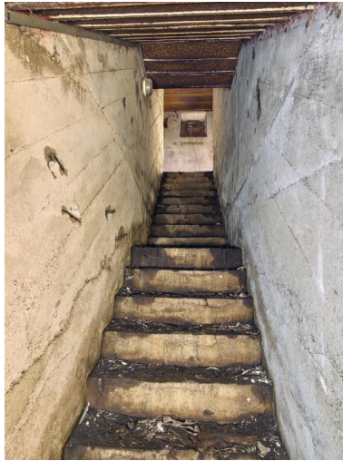
Vue intérieure : escalier desservant les deux cuves à canon Phot. Bernard Bègne IVR53_20235600225NUCA
