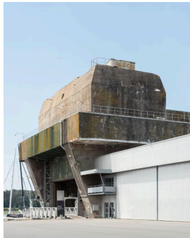
Vue du bunker KI avec l'entrée du slipway : sur la dalle de couverture, le bunker - cuves pour deux canons antiaériens. A droite, le hangar H1
