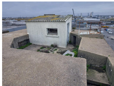
Vue de la cuve est pour canon. Au centre, l'emplacement pour le canon ; autour, niches à munition et petits abris pour les soldats. Elle est ensuite dotée d'un poste d'observation.
