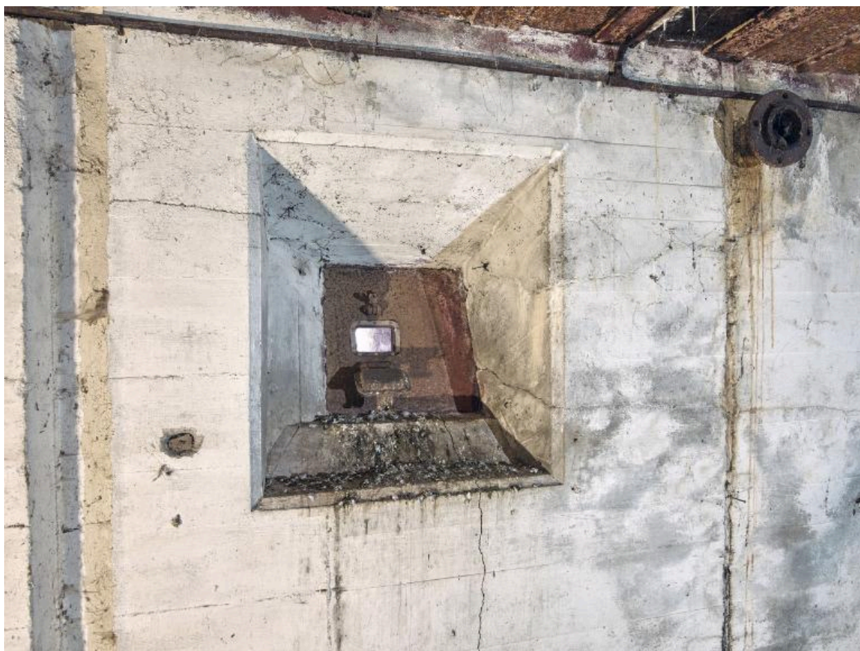
Vue intérieure : créneau de défense de la pièce de vie - chambrée ouest. Il est incliné.
