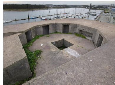
Vue de la cuve ouest pour canon. Au centre, l'emplacement pour le canon ; autour, niches à munition et petits abris pour les soldats. En arrière-plan, le port
