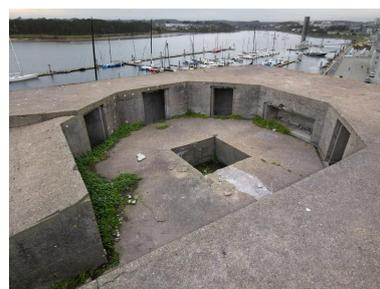
Vue de la cuve ouest pour canon. Au centre, l'emplacement pour le canon ; autour, niches à munition et petits abris pour les soldats. En arrière-plan, le port
