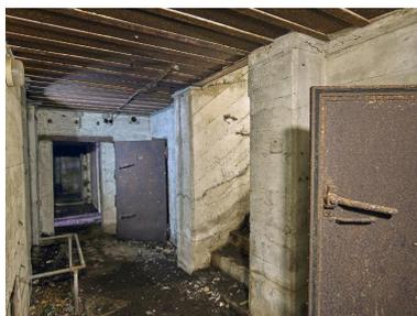
Vue intérieure : sas d'entrée ; les pièces de vie - chambrées sont chacune dotées d'une porte étanche. Entre les deux portes, l'escalier desservant les deux cuves pour canon
