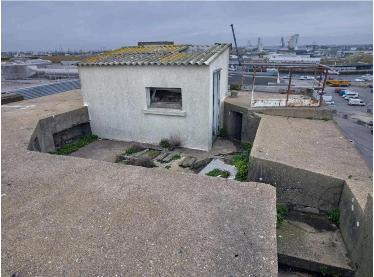
Vue de la cuve est pour canon. Au centre, l'emplacement pour le canon ; autour, niches à munition et petits abris pour les soldats. Elle est ensuite dotée d'un poste d'observation. En arrière-plan, le port de pêche
