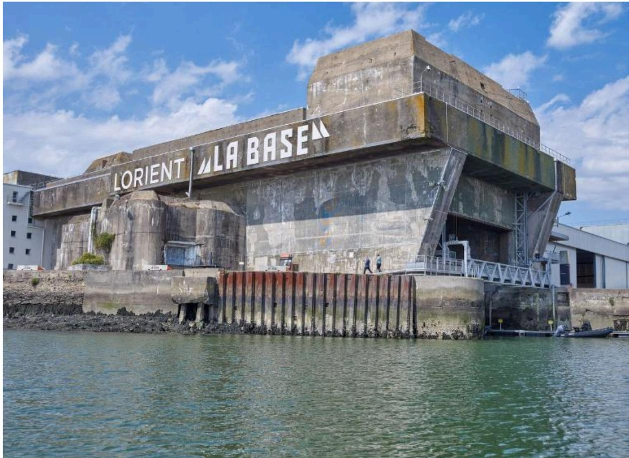
Vue du bunker KI avec l'entrée du slipway : sur la dalle de couverture, le bunker - cuves pour deux canons antiaériens. Sur le quai à gauche, le bunker - casemate de flanquement
