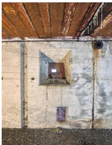
Vue intérieur : créneau de défense de la pièce de vie - chambrée ouest. Il est incliné. Disposée au ras du sol, une ouverture dont la fonction est non identifiée
