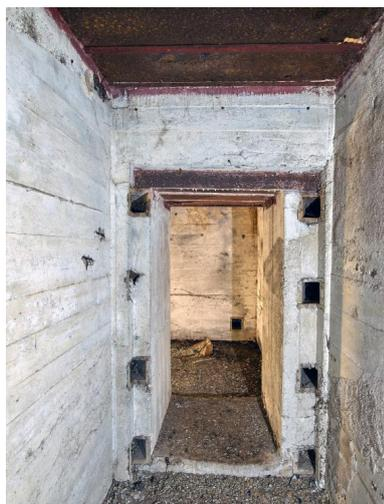
Vue intérieure : emplacement de la porte blindée du magasin de munitions ouest. La porte blindée n'a pas été posée : huit points permettaient de fixer l'huissierie de la porte
