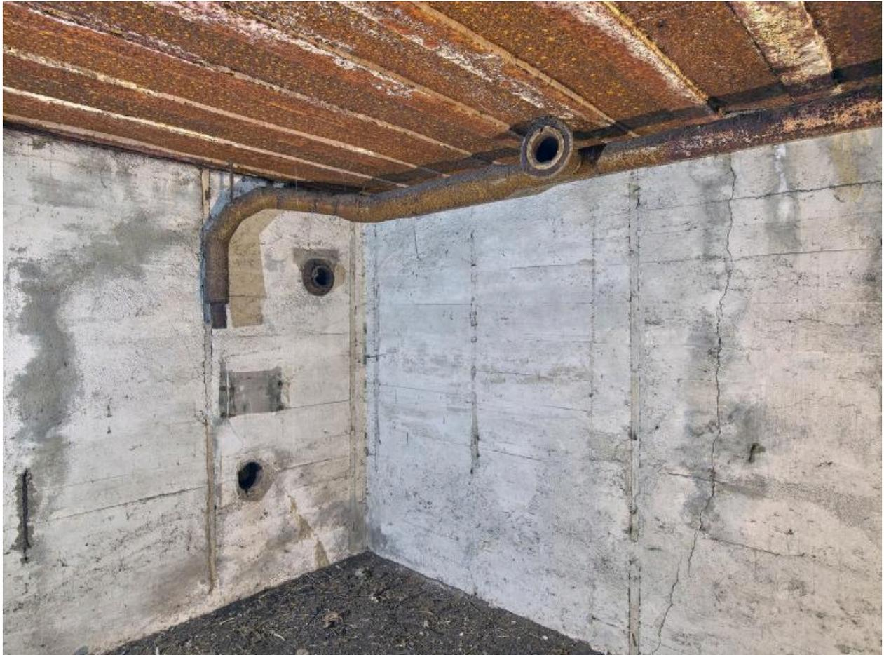
Vue intérieure : pièces de vie - chambre ouest avec la tuyauterie du système de ventilation. L'emplacement du ventilateur est bien visible sur le mur
