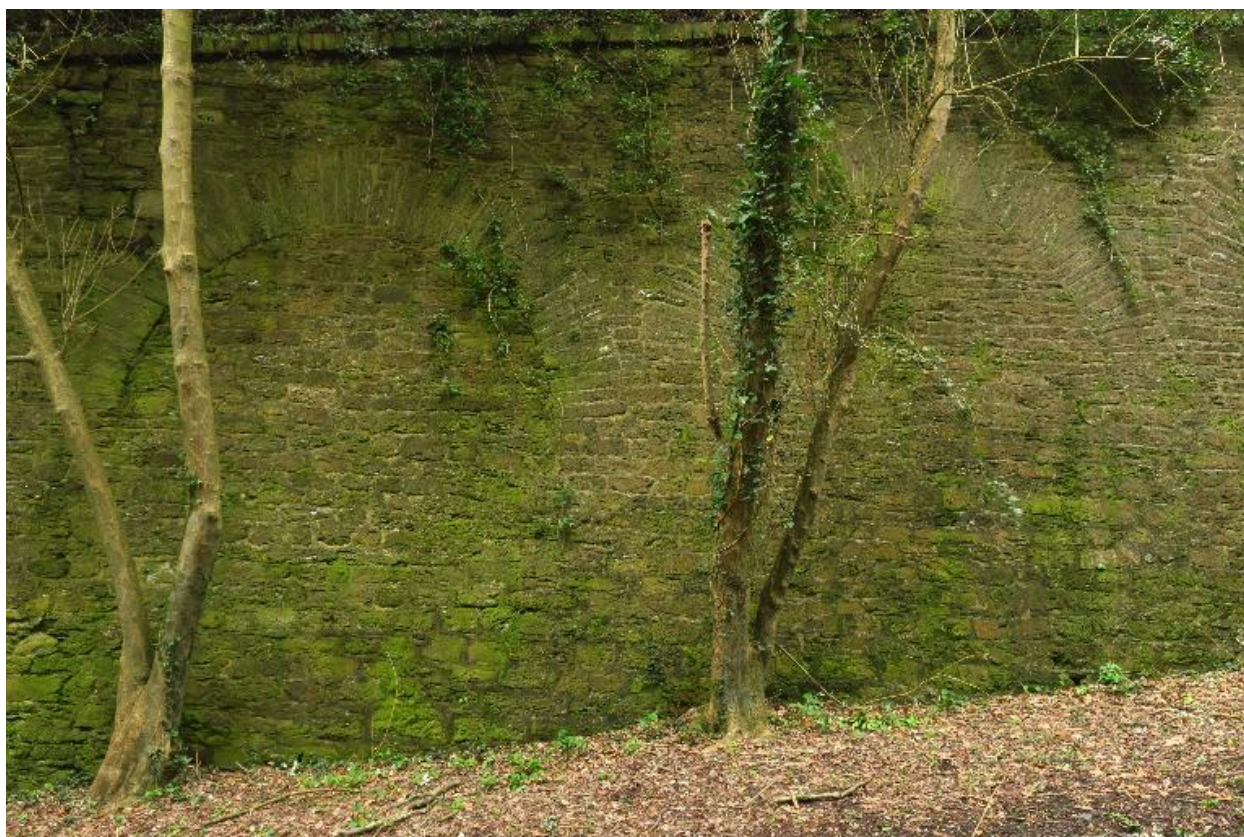
Le Palais, enceinte urbaine, courtine 21-22, escarpe, arcs de décharge.
