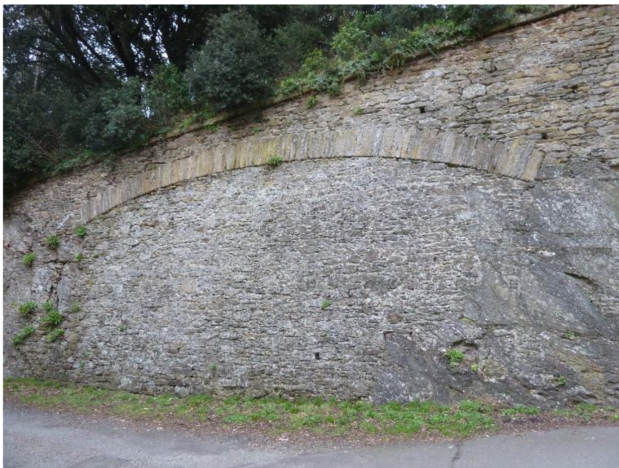
Le Palais, enceinte urbaine, courtine 21-22, extrémité droite, arc de décharge.
