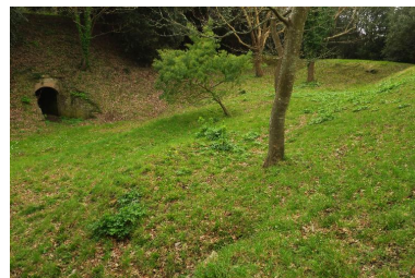
Le Palais, enceinte urbaine, courtine 21-22, ressaut intermédiaire.
