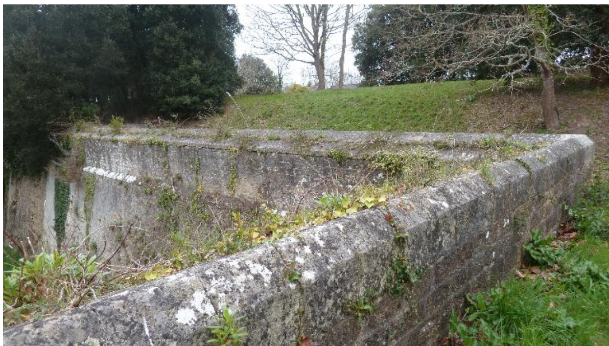
Le Palais, enceinte urbaine, courtine 21-22, jonction avec le bastion 21, parapet d'infanterie.
