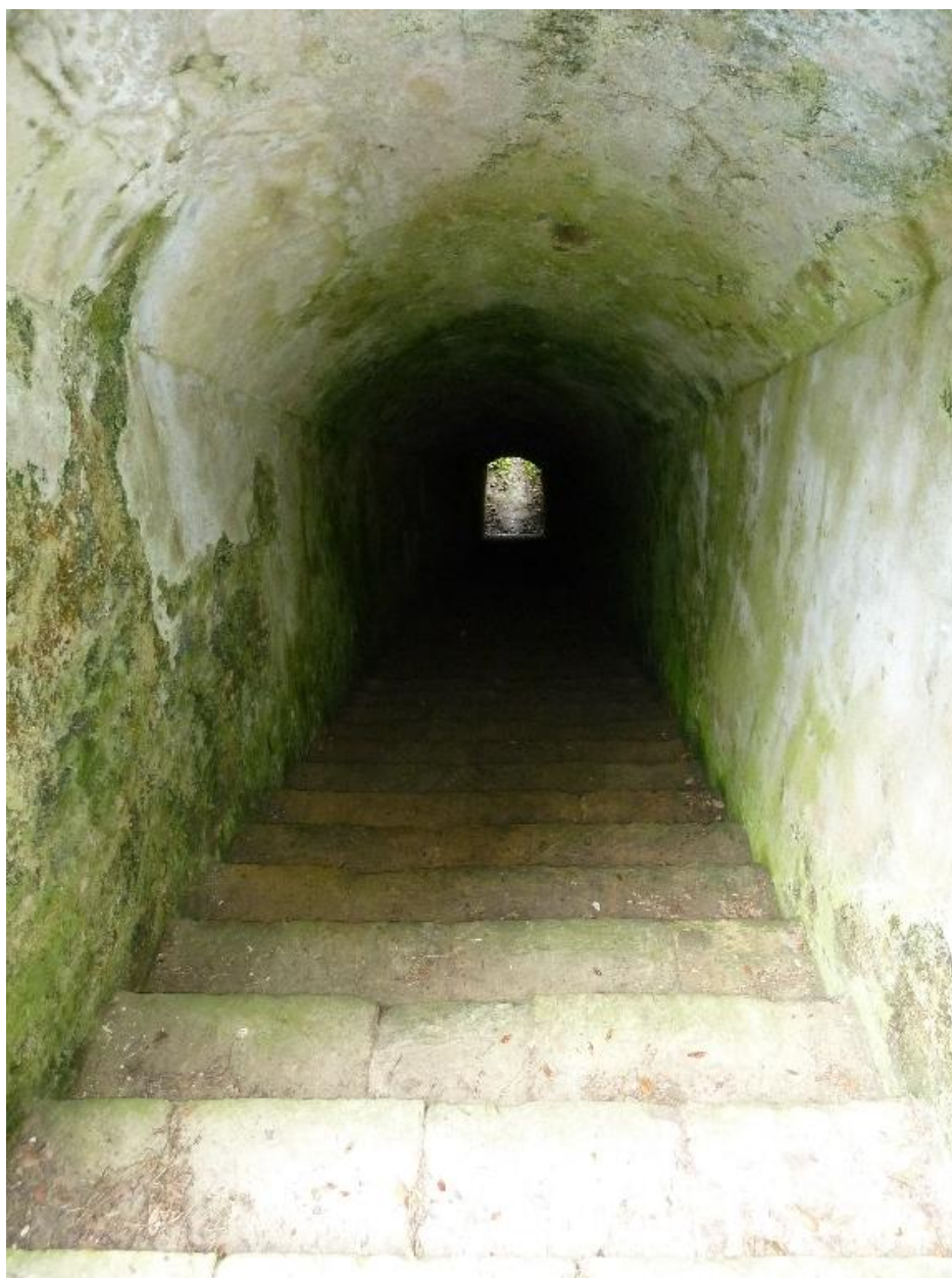
Le Palais, enceinte urbaine, courtine 21-22, galerie intermédiaire.
