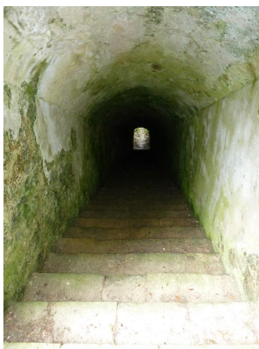
Le Palais, enceinte urbaine, courtine 21-22, galerie intermédiaire.
