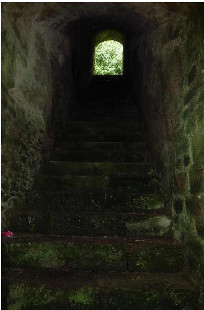
Le Palais, enceinte urbaine, courtine 21-22, galerie inférieure.
