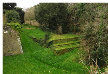
Le Palais, enceinte urbaine, courtine 21-22, banquette d'infanterie flanquant le bastion 21. Phot. Lionel Duigou IVR53_20175608417NUCA
