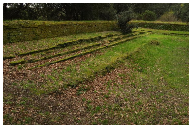
Le Palais, enceinte urbaine, courtine 21-22, ressaut inférieur, parapet et banquette d'infanterie.
