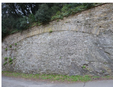
Le Palais, enceinte urbaine, courtine 21-22, extrémité droite, arc de décharge. Phot. Patrick Jadé IVR53_20175608446NUCA
