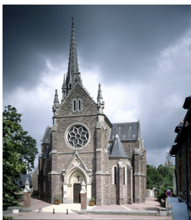
Vue générale de la façade sur la place de l'Eglise Phot. Guy Artur, Phot. Norbert Lambart IVR53_19923500614VA
