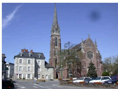
Vue générale Phot. Véronique Orain IVR53_20033510320NUCA
