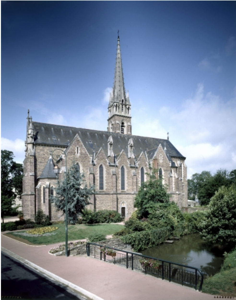
Vue d'ensemble de la façade latérale
