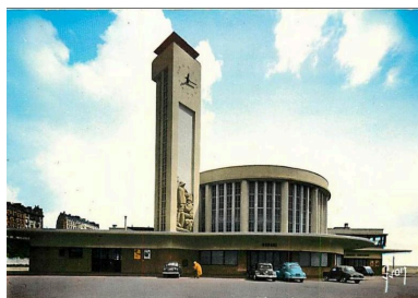
Carte postale, gare de Brest, Ed. Yvon IVR53_20202905377NUCA
