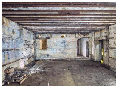
Vue du bunker - abri de type 485 long pour radar Mammout : salle d'exploitation. Au fond : à gauche, ouverture donnant sur la salle des ventilateurs ; à droite, vers la sas étanche ; encore à droite, vers la salle du groupe électrogène de secours
