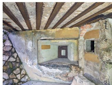
Vue du bunker - abri de type 485 long pour radar Mammout : créneau blindé de défense de l'entrée depuis l'extérieur. A droite, prise d'air (dépourvu de grille de protection et de tuyau) de la salle des ventilateurs. Les murs étaient doublés de brique
