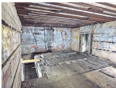
Vue du bunker - abri de type 485 long pour radar Mammout : salle des compensateurs avec sa gaine technique et ses deux socles. La salle d'exploitation et la salle des compensateurs étaient divisées par une cloison en brique
