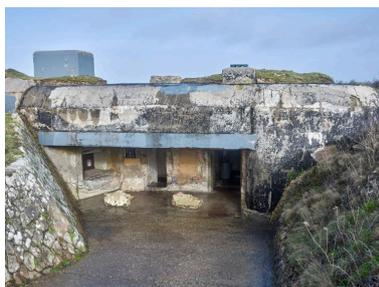
Vue du bunker - abri de type 485 long pour radar Mammout depuis le sud. Une rampe en pente douce - encadrée par deux murs en glacié - donne accès au bunker qui est quasiment entièrement enterré dans le sol
