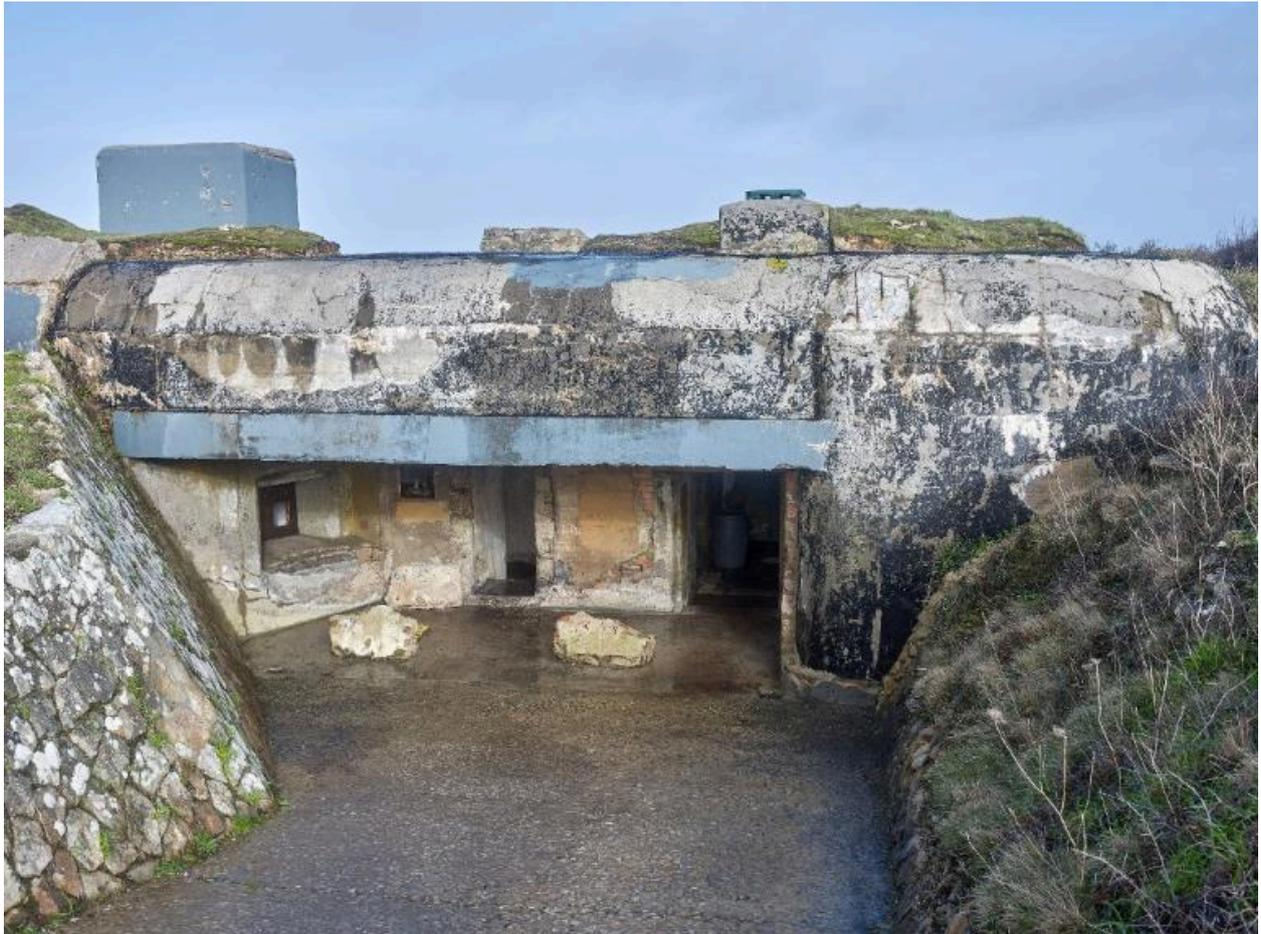
Vue du bunker - abri de type 485 long pour radar Mammout depuis le sud. Une rampe en pente douce - encadrée par deux murs en glacis - donne accès au bunker qui est quasiment entièrement enterré dans le sol
