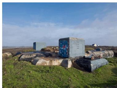
Vue générale du bunker - abri de type 485 long pour radar Mammut depuis le sud-ouest. De la dalle de couverture émergent deux imposants puits pour câble d'antenne et les
