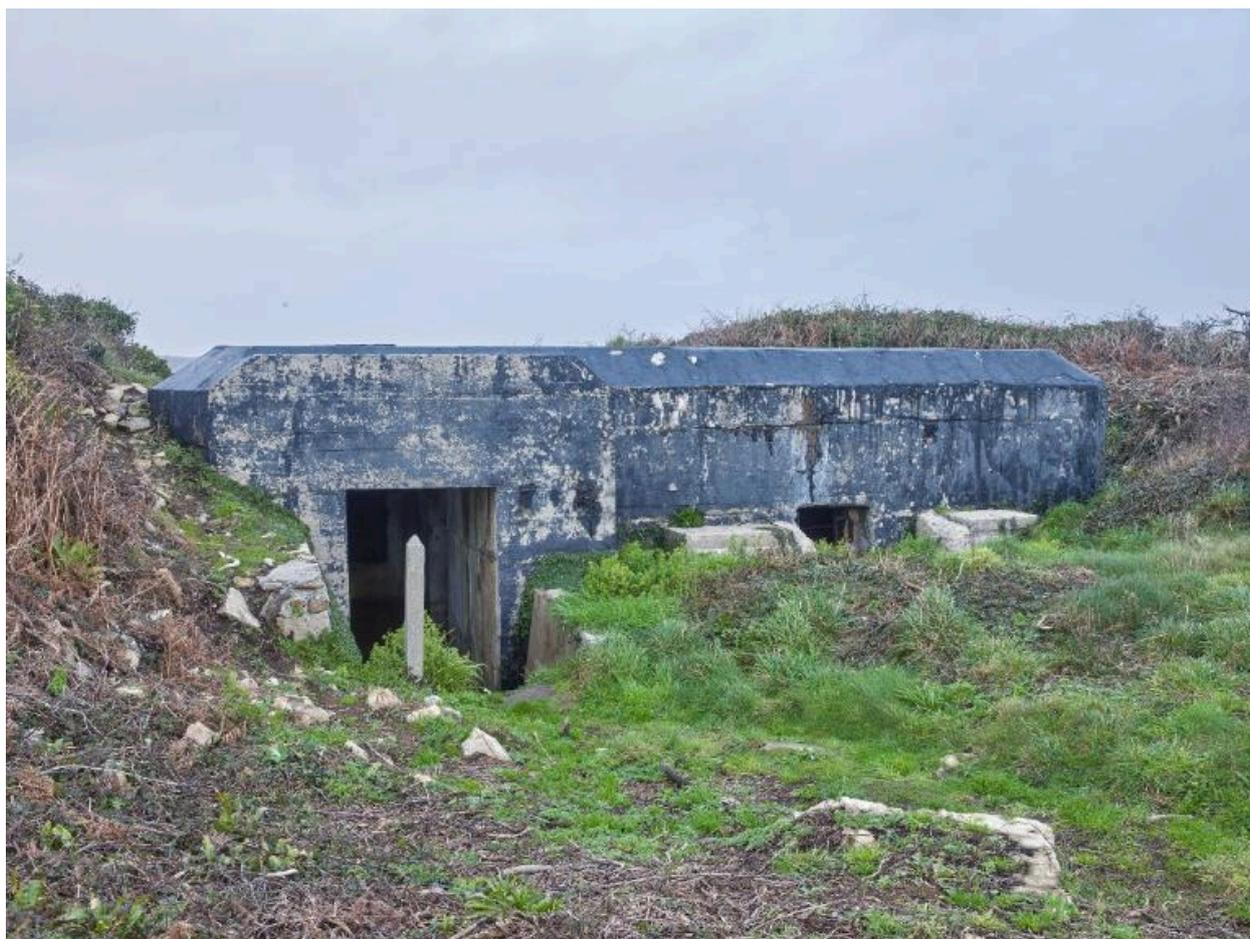
Vue du bunker - abri de type VF 1b pour 6 hommes (élévation sud-ouest). Dans le cadre de sa transformation en logement : le bunker a été recouvert de goudron pour améliorer son étanchéité
