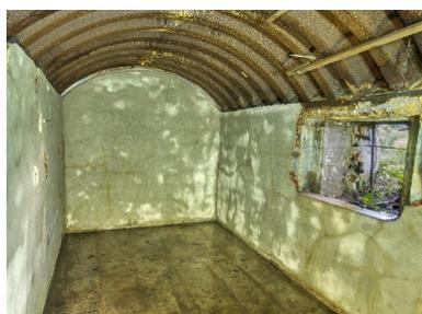
Vue du bunker - abri de type VF 1b pour 6 hommes : salle de garde (couverte en tôle ondulée cintrée dite tôle métro). A droite, la sortie de secours. Le bunker a ultérieurement été transformé en logement
