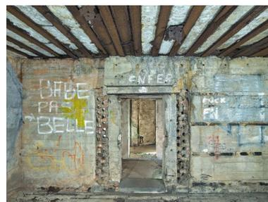
Vue du bunker - abri de type 485 long pour radar Mammout : passages de câble de la salle des compensateurs au puits d'antenne nord-est via un sas étanche. Ils sont photographiés depuis la salle des compensateurs ; au centre, porte disparue
