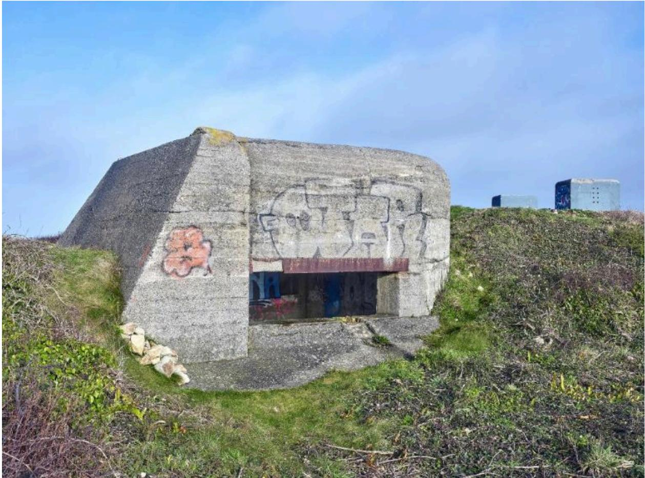
Vue du bunker - casemate, variante d'un type 667 : élévation sud côté embrasure. A gauche, petit mur de flanquement protégeant l'embrasure des coups venant de l'ouest. En arrière-plan, le bunker pour radar Mammot
