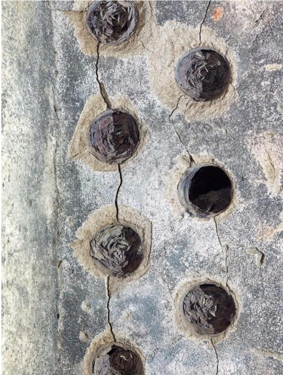
Vue du bunker - abri de type 485 long pour radar Mammut : passages de câble de la salle des compensateurs au puits d'antenne sud-ouest via un sas étanche
