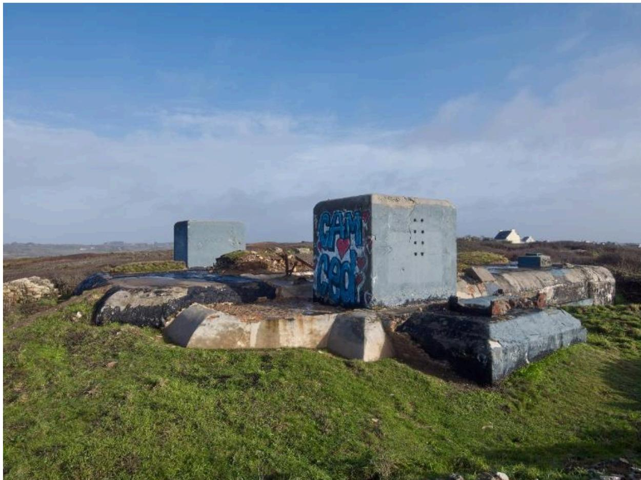
Vue générale du bunker - abri de type 485 long pour radar Mammout depuis le sud-ouest. De la dalle de couverture émergent deux imposants puits pour câble d'antenne et les vestiges des quatre mâts d'antenne. Le bunker est doublé en brique
