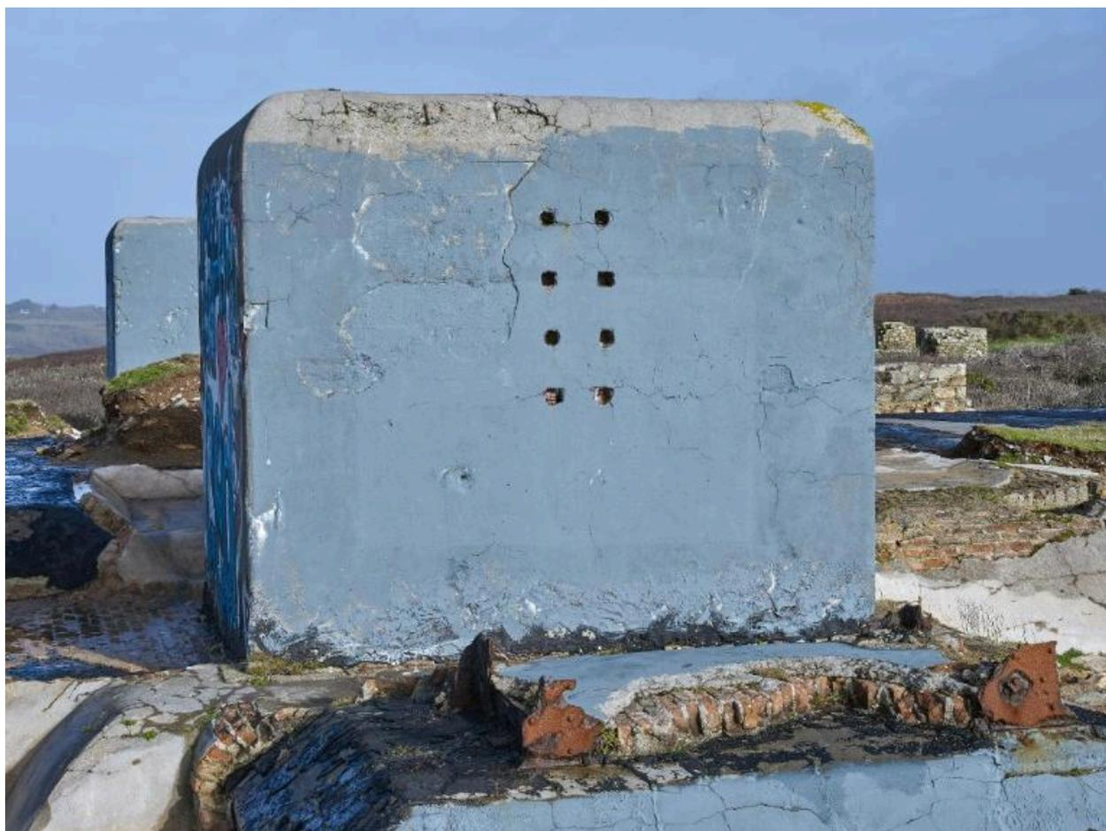
Vue du bunker - abri de type 485 long pour radar Mammut depuis le sud-ouest : puits sud-ouest pour câble d'antenne avec ses passages de câble (8 de ce côté). Au premier plan, les vestiges de l'un des quatre mâts d'antenne. Le bunker est doublé en brique
