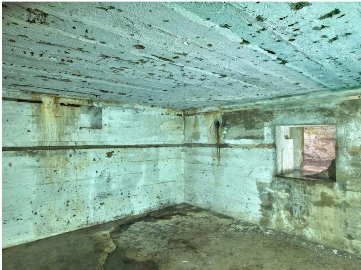
Vue du bunker - abri de type VF 2a pour 10 hommes : salle de garde. A droite, la sortie de secours (mur ouest). Les murs - peints en blanc - sont dotés de tasseaux horizontaux posés à intervalle régulier
