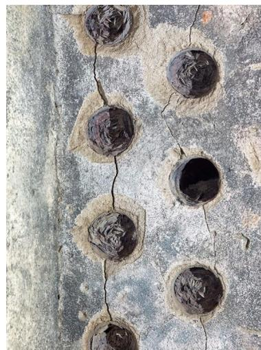
Vue du bunker - abri de type 485 long pour radar Mammot : puits d'antenne nord-est avec ses échelons. Les murs étaient dotés de tasseaux posés à intervalle régulier pour la fixation des câbles
