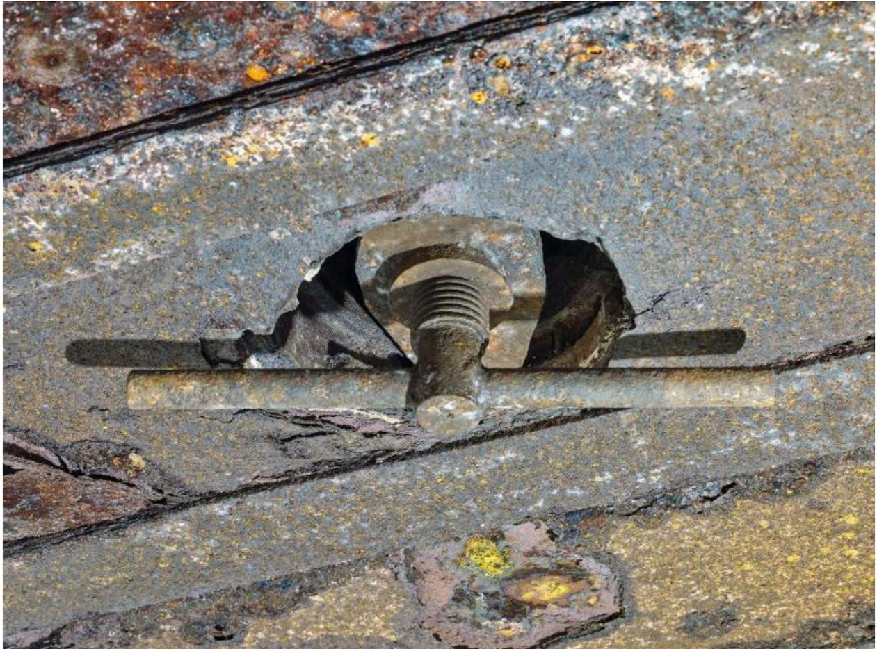
Vue du bunker - abri de type 622 pour deux groupes de combat (soit 20 hommes) : salle de garde nord, bouchon obturateur du puits de périscope. La dalle de couverture en béton armé mesure 2 m d'épaisseur
