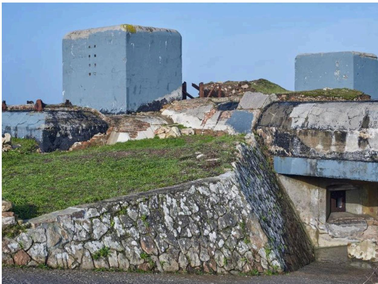
Vue du bunker - abri de type 485 long pour radar Mammout depuis le sud. De la dalle de couverture émergent deux imposants puits pour câble d'antenne. Le mur en glacis de la rampe est en appareillage polygonal. En bas à droite, le créneau blindé
