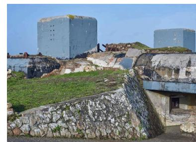
Vue du bunker - abri de type 485 long pour radar Mammut depuis le sud. De la dalle de couverture émergent deux imposants puits pour câble d'antenne. Le mur en glacières de la
