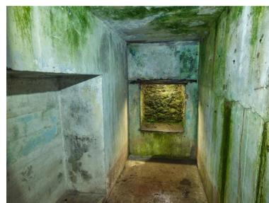
Vue du bunker - abri de type VF 1b pour 6 hommes : couloir d'accès orienté vers le nord-est. A gauche, niches murales. Orientée vers le nord-est, la seconde entrée a été transformée en cheminée
