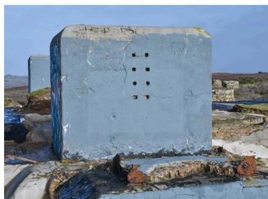
Vue du bunker - abri de type 485 long pour radar Mammout depuis le sud-ouest : puits sud-ouest pour câble d'antenne avec ses passages de câble (8 de ce côté). Au premier plan, les vestiges de l'un des quatre mâts d'antenne. Le bunker est doublé en brique
