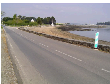
Digue de l'anse de l'Île Longue vue depuis la route Phot. Clotilde Buhot IVR53_20062908534NUCA
