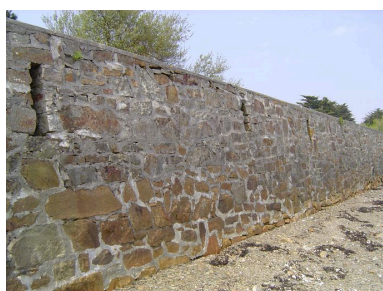
Vue générale de la digue de l'anse de l'Île Longue Phot. Clotilde Buhot IVR53_20062908535NUCA
