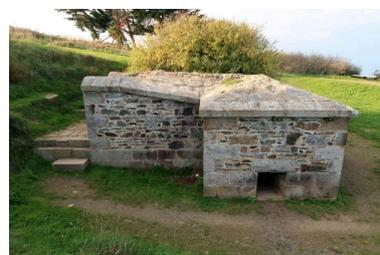
Vue générale de l'élévation orientale (état en 2024). A gauche se trouve la plate-forme permettant le chargement des boulets dans le four ; à droite, l'ouverture du cendrier. Une tablette en pierre de taille couronne les murs
