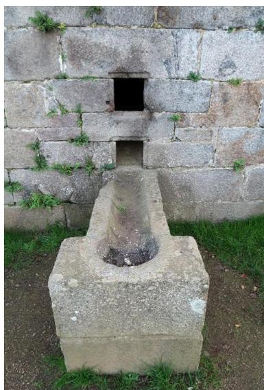
Vue de détail de l'élévation nord en pierre de taille de granite (état en 2024). La goulotte de réception des boulets rouges est en granite
