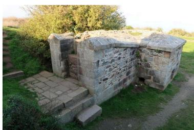
Vue générale depuis le sud (état en 2024). La plate-forme permettant le chargement des boulets dans le four est accessible par des marches. L'élévation sud est en pierre de taille ; l'élévation orientale est en maçonnerie de moellon
