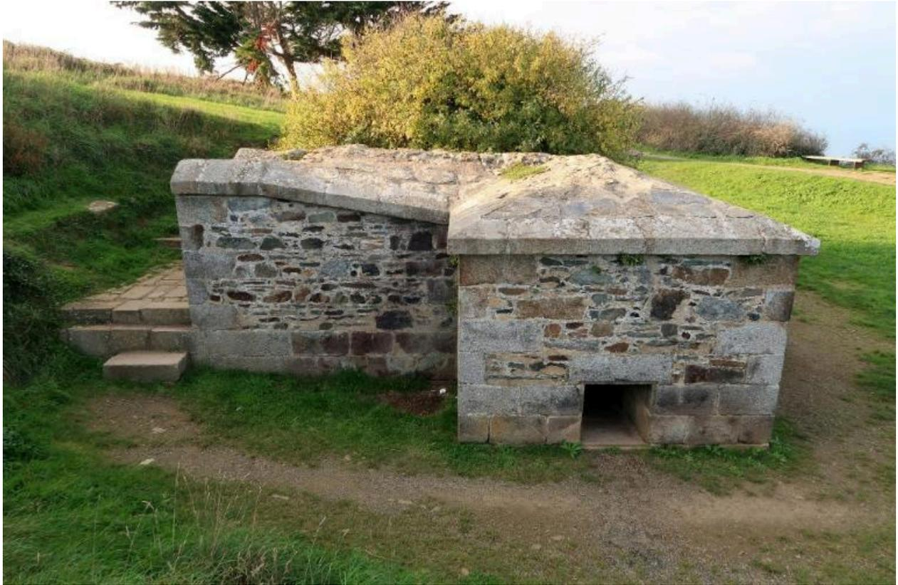
Vue générale de l'élévation orientale (état en 2024). A gauche se trouve la plate-forme permettant le chargement des boulets dans le four ; à droite, l'ouverture du cendrier. Une tablette en pierre de taille couronne les murs
