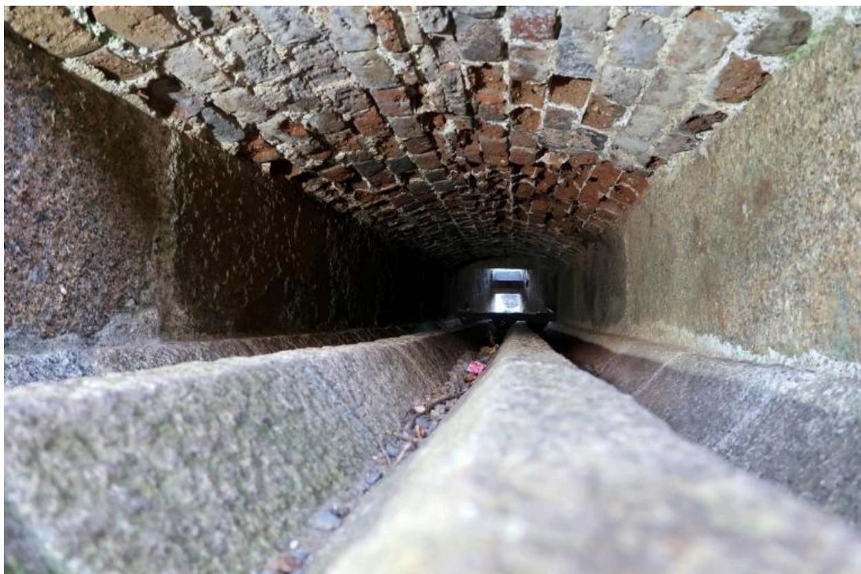
Vue du couloir de chauffe voûté en brique réfractaire (état en 2024). Le plan incliné est doté de trois rainures en granite ; les parois latérales sont en granite
