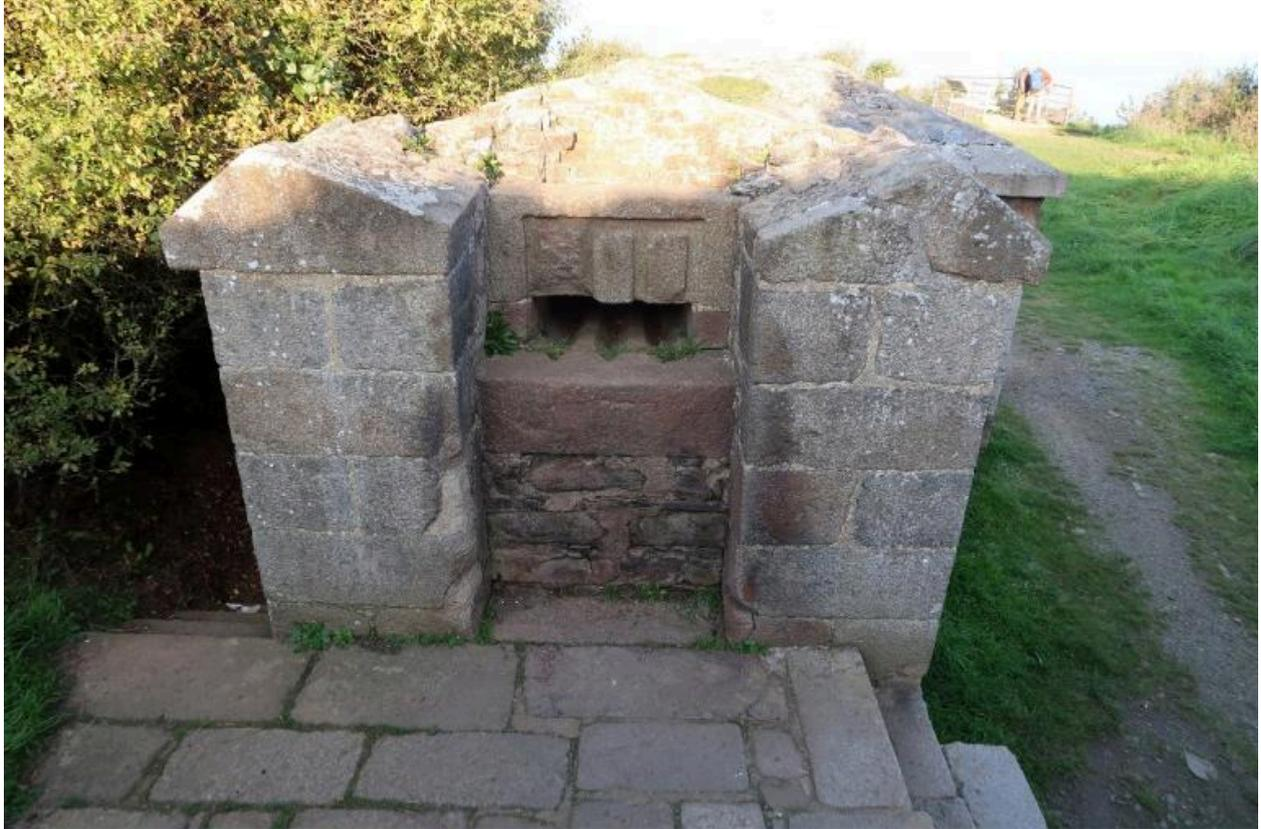
Vue de l'élévation sud en pierre de taille (état en 2024). Au premier plan, la plate-forme accessible par des marches permettant le chargement des boulets dans le four ; la gueule de chargement du four est dotée de trois rainures en granite
