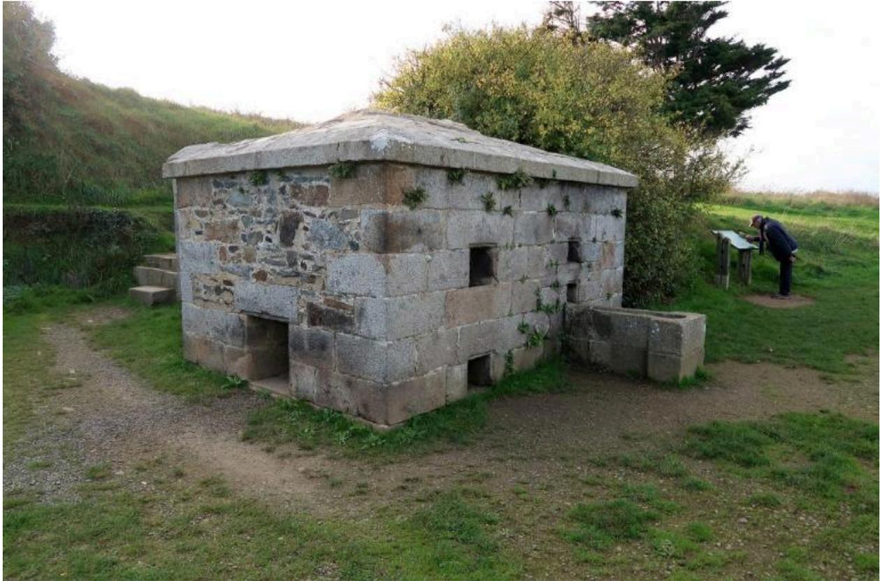
Vue générale depuis l'est (état en 2024). L'élévation principale nord est en pierre de taille de granite ; l'élévation orientale est en maçonnerie de moellon. Une tablette en pierre de taille couronne les murs
