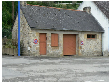
Vue générale du magasin des Ponts et Chaussées Phot. Julien Amghar IVR53_20072908662NUCA
