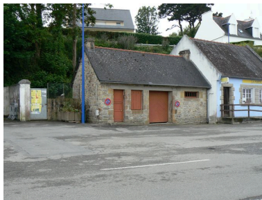
Vue générale du magasin des Ponts et Chaussées Phot. Julien Amghar IVR53_20072908663NUCA
