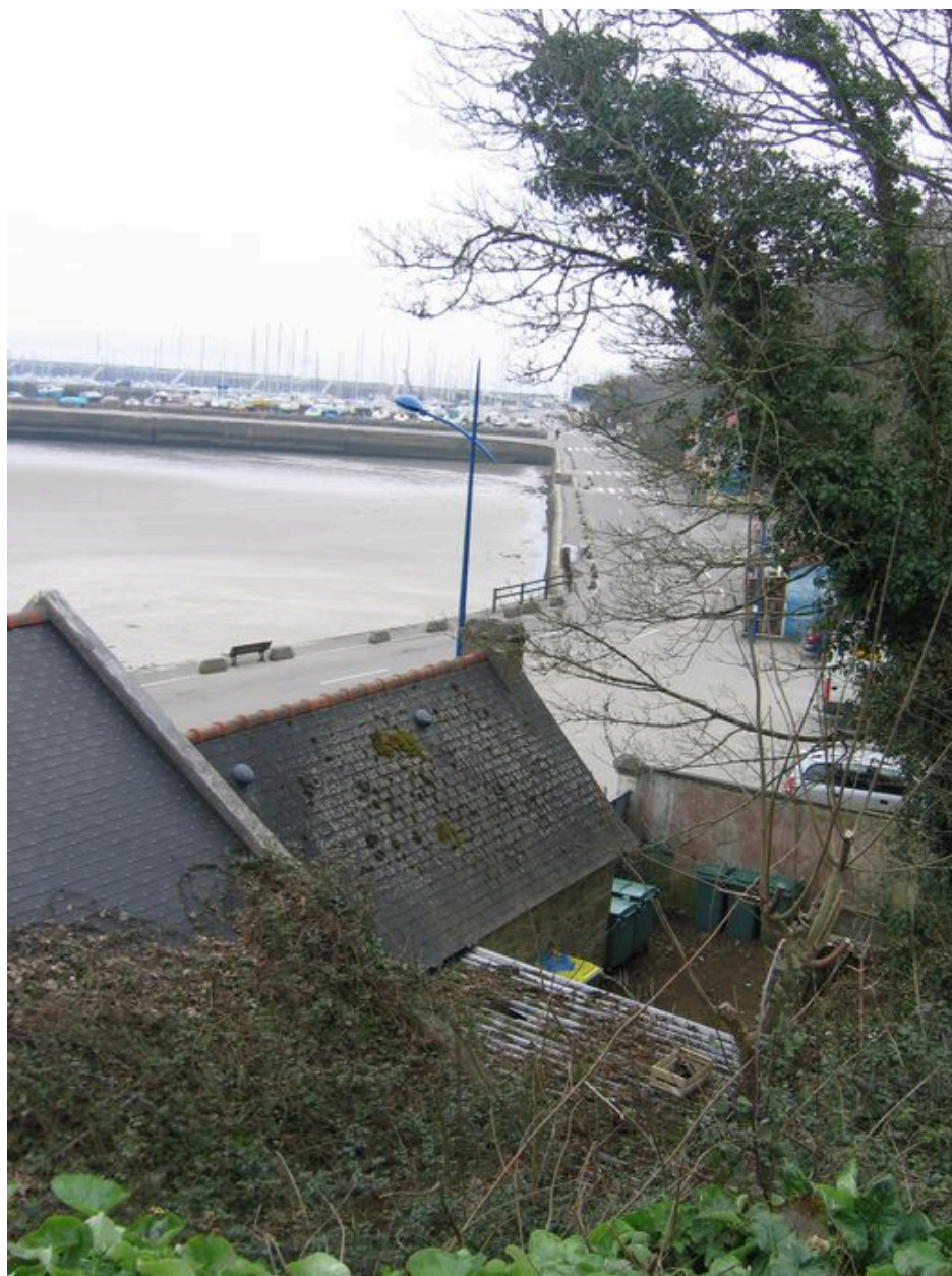
Vue de l'arrière du magasin des Ponts et Chaussées, côté falaise
