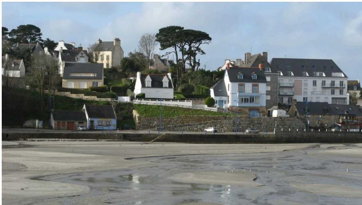
Magasin des Ponts et Chaussées vu du quai
